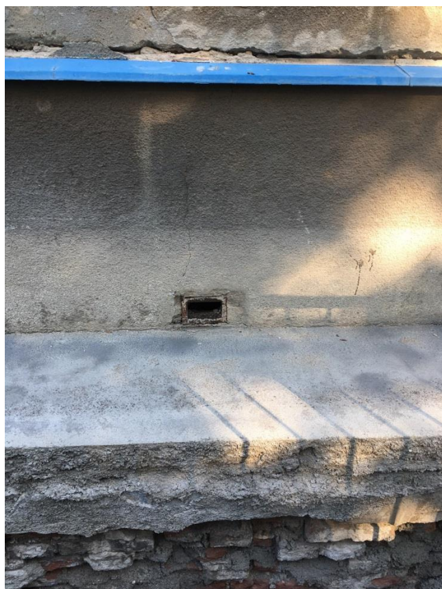
Potenciální vletový otvor - odvětrání podzemního kanálu před suterénní stěnou
