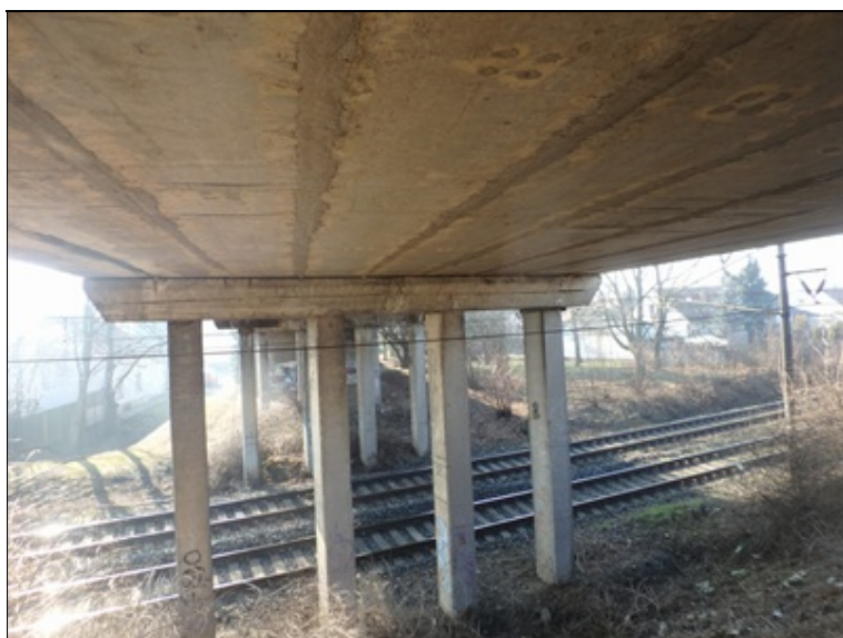
Podhled nosné konstrukce.
