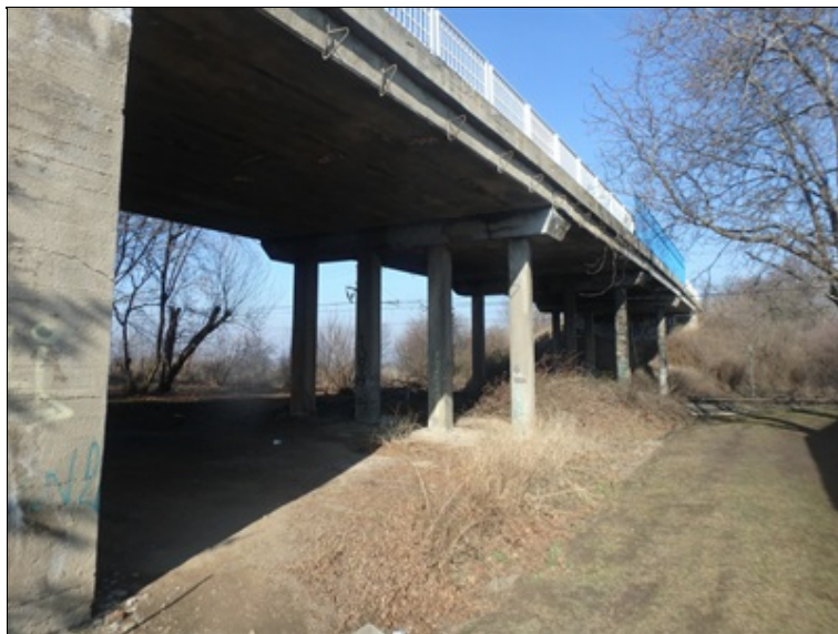
Pravý bok mostu.
