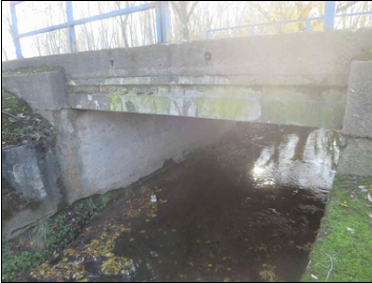
levá strana mostu
