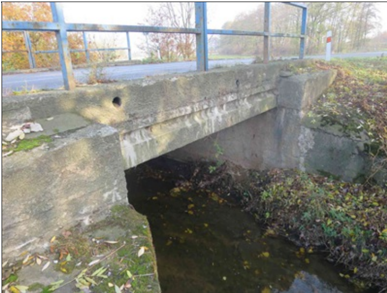
pravá strana mostu
