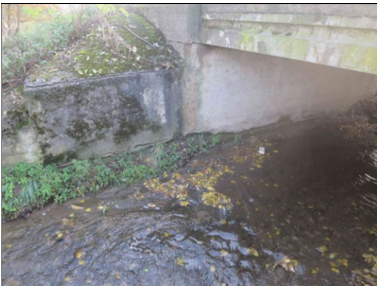
levé křídlo O2
