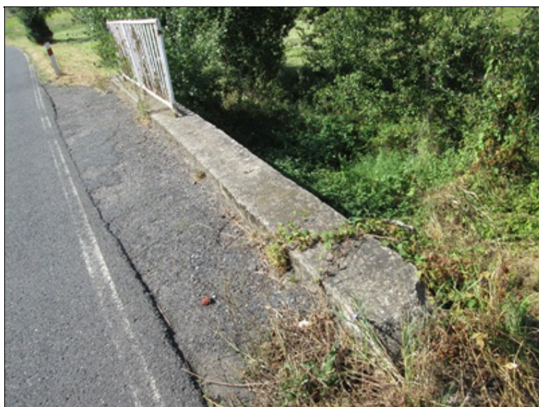
3-IMG_8691.JPG Pravá strana mostu
