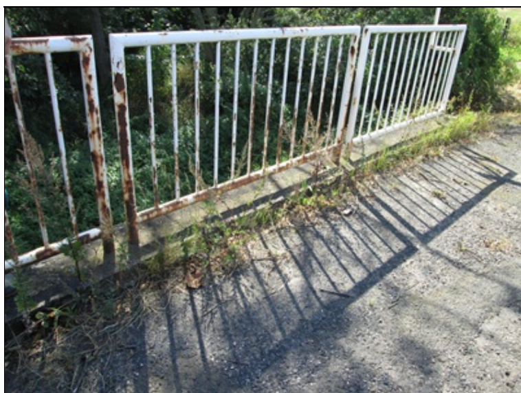
4-IMG_8693.JPG Levá strana mostu.
