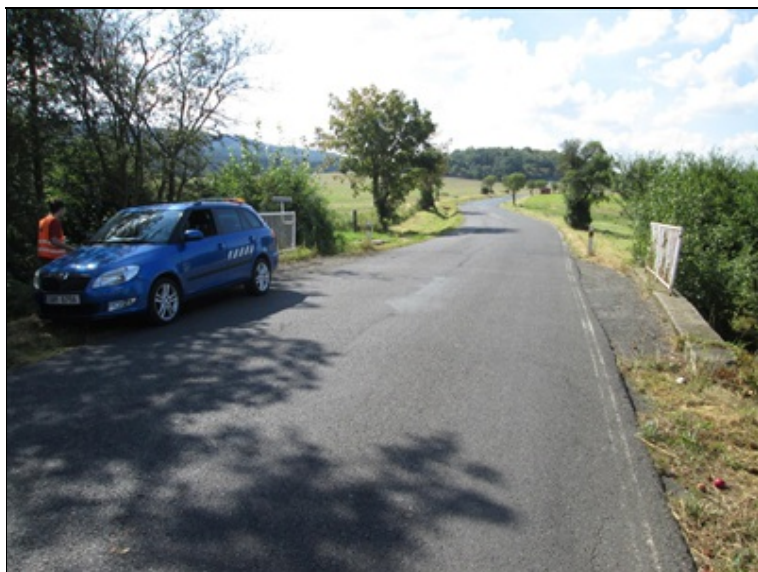
1-IMG_8690.JPG Pohled na most ve směru staničení.
