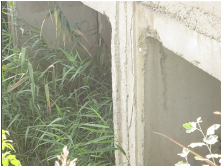
stopy po průsaku na bok stěn
