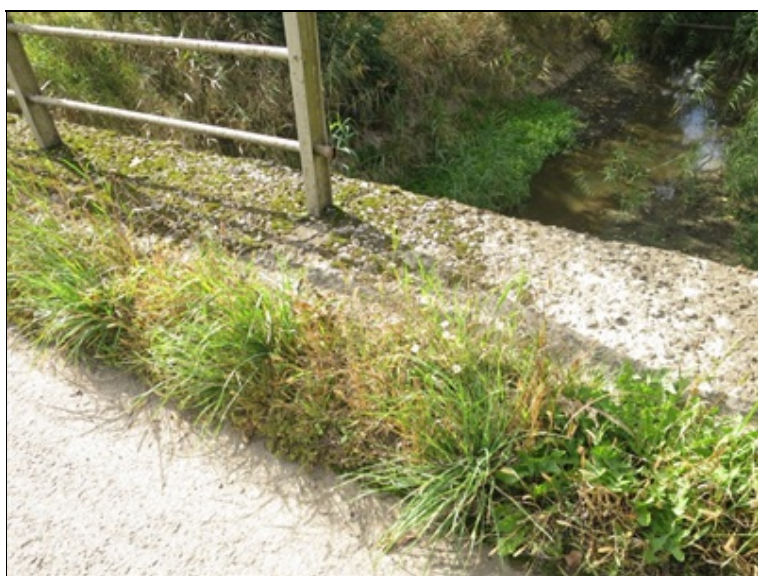
degradace betonu pravé římsy, vegetace podél římsy
