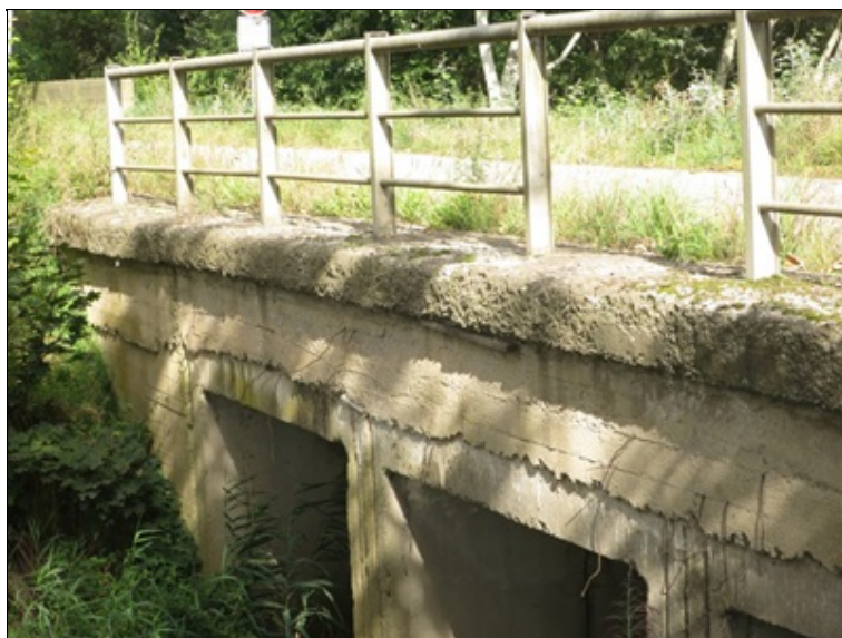
DTTO - degradace betonu římsy
