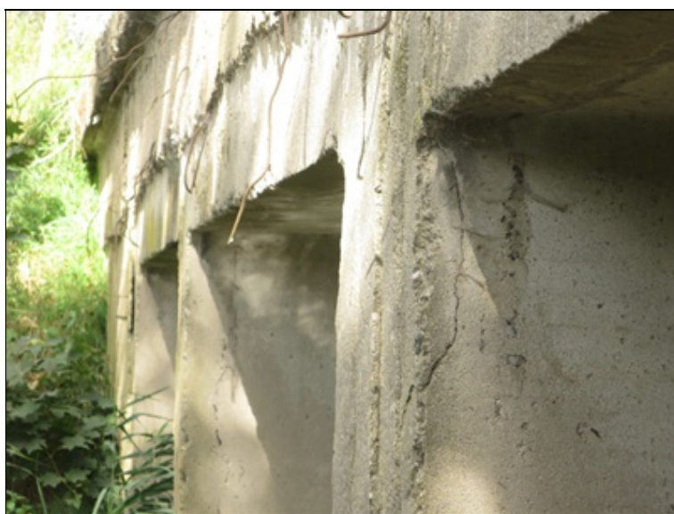
separace krycí vrstvy nad korodující výztuží u stěny krajního rámu
