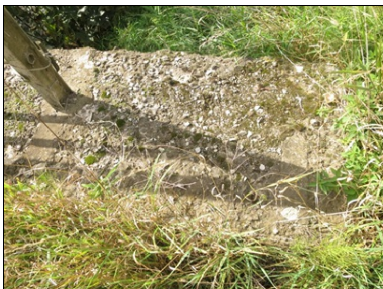
degradace betonu římsy
