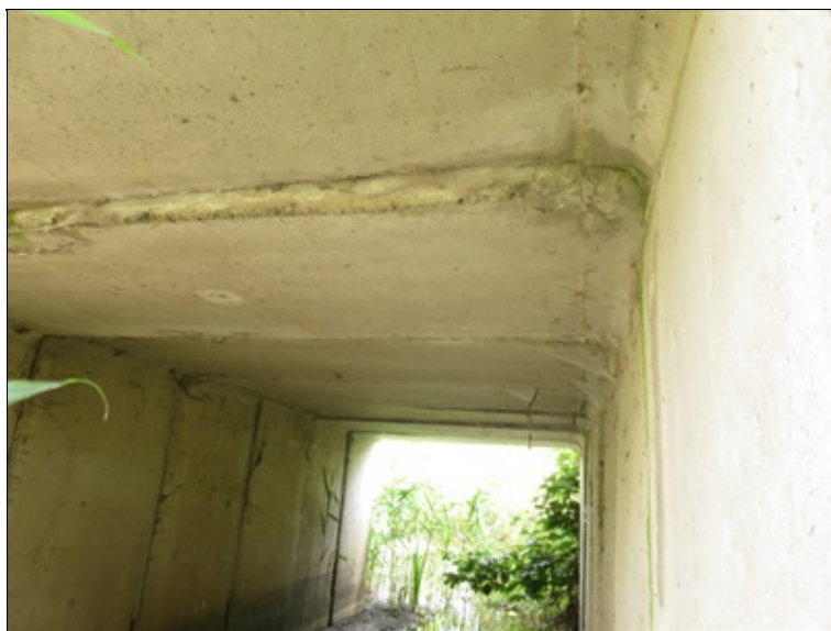
průhled 1. mostním polem, stopy po průsacích sparami mezi prefabrikáty
