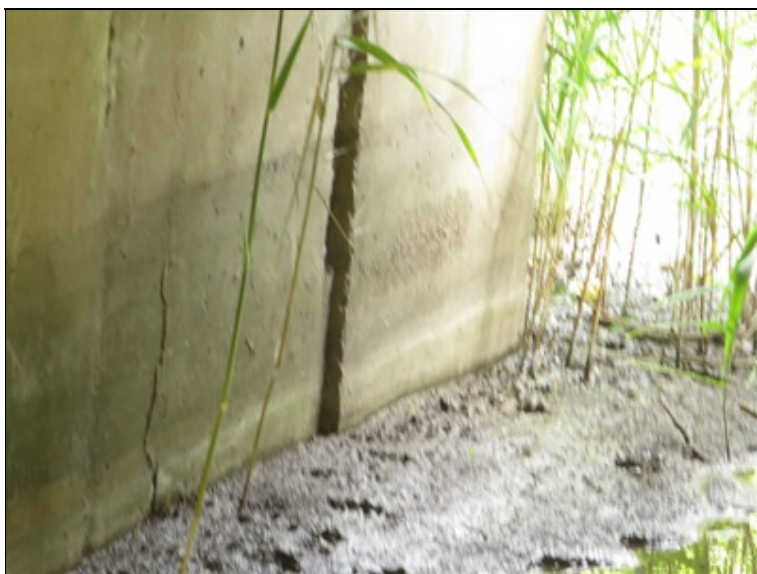
otevřená spára mezi rámy v oblasti stěny
