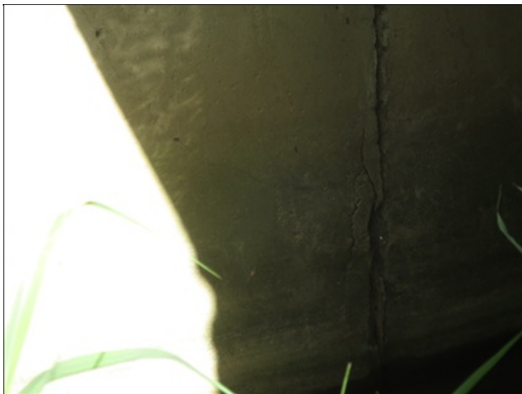
korozí výztuže na spodním lici příčle rámu
