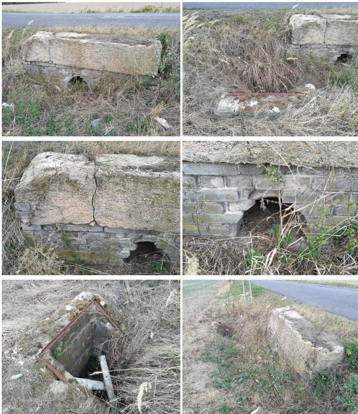
Shora zleva, směr Rudná – Unhošť, levá strana: 1 – celkový pohled na čelo, 2 – detail s odtokovou šachtou, 3 – detail krycí desky, 4 – detail vtoku, 5 – detail šachty, 6 – boční pohled
