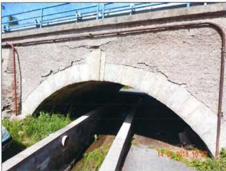
Pohled na pravý bok mostu.
