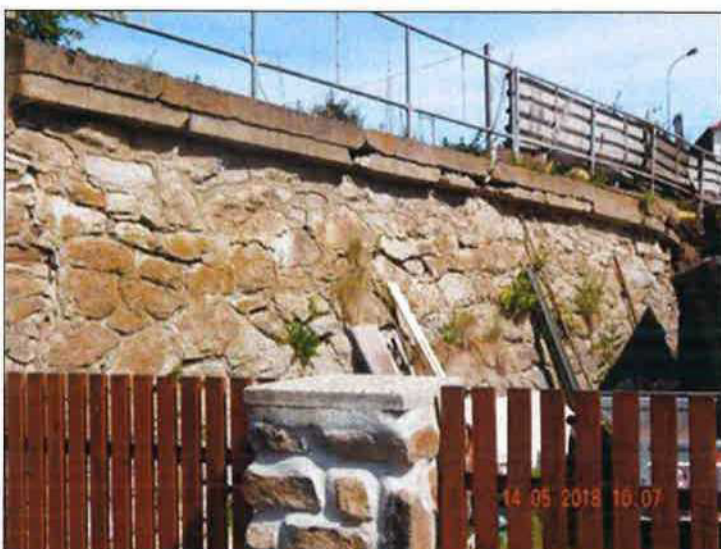
Pohled na navazující opěrnou zeď na pravé straně - část blíže mostu.
