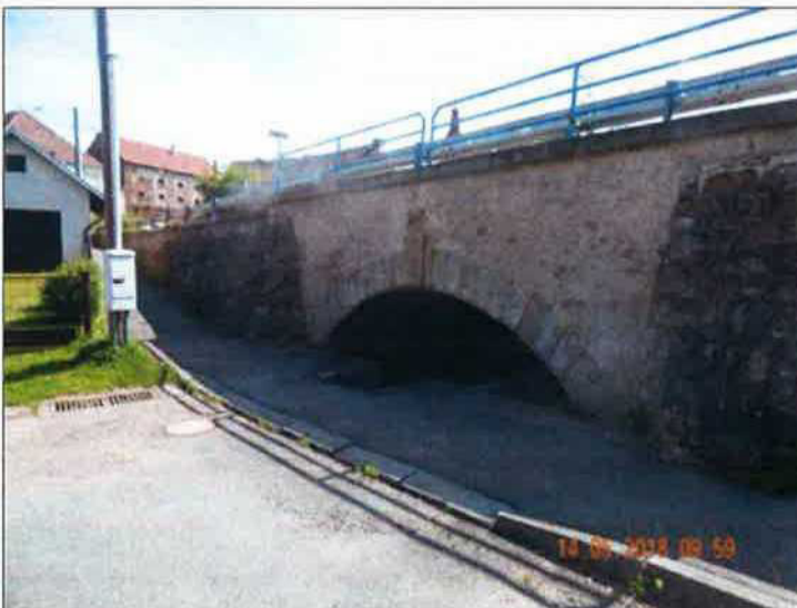
Pohled na levý bok mostu.
