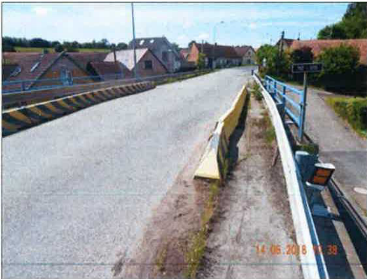
Pohled proti směru staničení.
