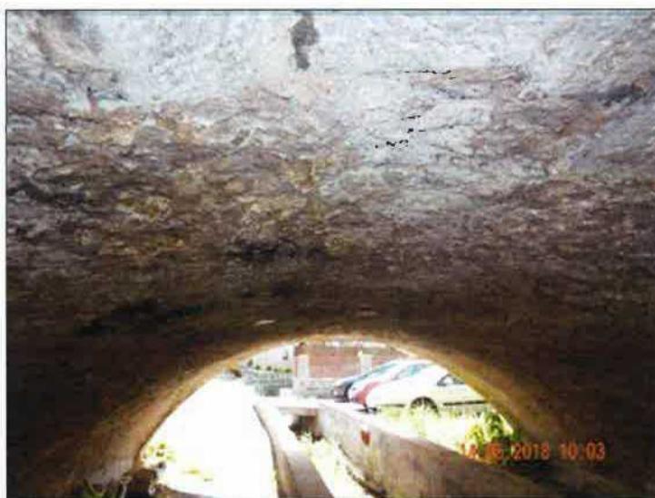
Spodní líc nosné konstrukce
