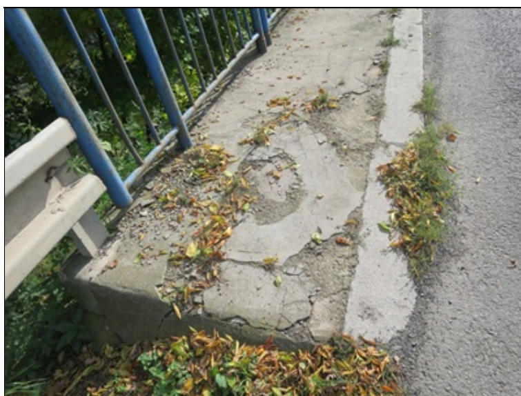
rozpad krytu pravého chodníku za O5
