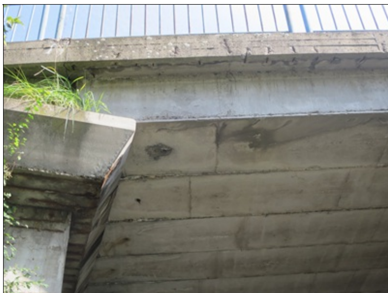
obnažená korodující výztuž na spodním líci levé konzoly P4, průsak z 1. nosníku ve 3. poli u P4
