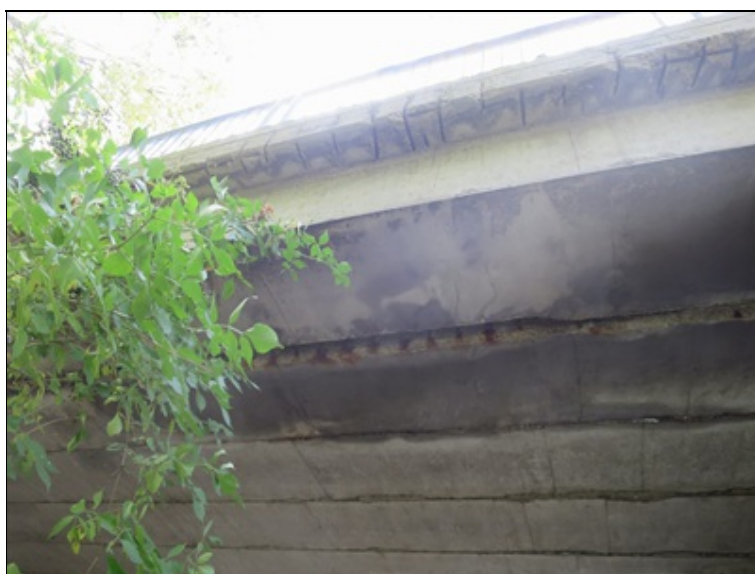
typická závada NK - odpadlá hrana nosníku nad korodující výztuží v místě prosakující podélné spáry mezi nosníky
