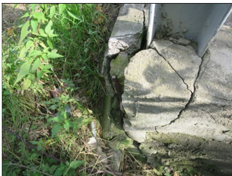
nefunkční ukotvení sloupku svodidla v rohu římsy
