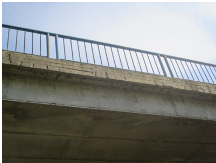
separace krycí vrstvy nad korodující výztuží na spodním líci římsy
