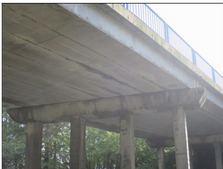
typická závada NK - intenzivní průsaky sparou mezi nosníky
