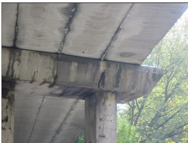
intenzivní průsaky dilatační sparou na levou část stativa P3
