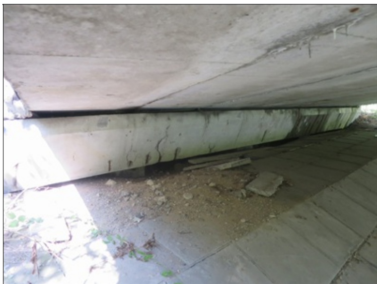
podemletý úložný práh opěry 5
