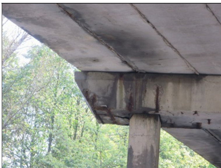
typická závada SS - v oblasti vody nasycené CHRL prosakující NK dochází k extrémnímu namáhání stojek pilířů (koroze výztuže, separace krycí vrstvy, degradace betonu, aj.)
