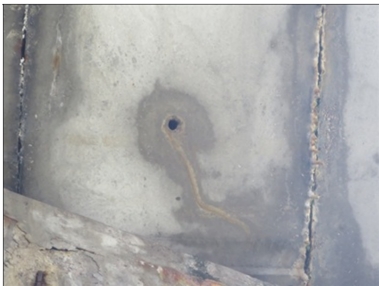
typická závada NK - prosáklá voda nasycená CHRL kontinuálně vytáka z dutiny nosníku dovodňovacím otvorem na jeho spodní líc
