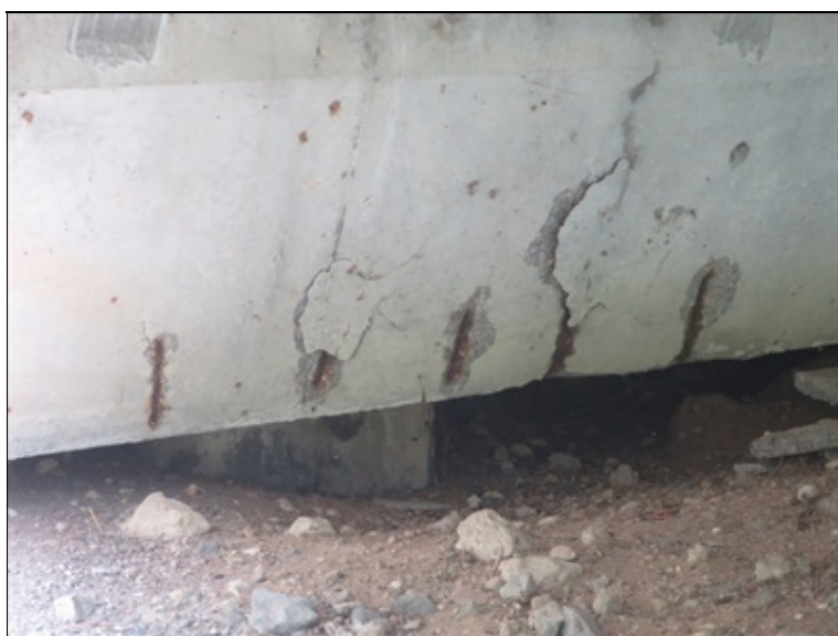
DTTO - separace krycí vrstvy nad korodující výztuží
