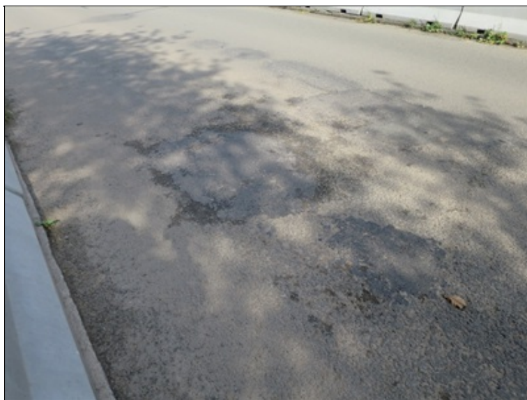
provizorní opravy krytu vozovky
