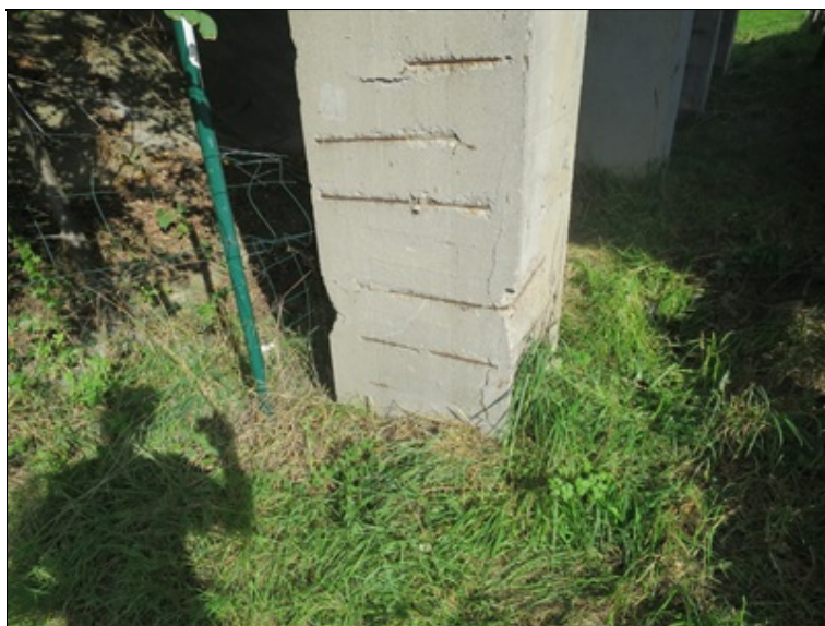
typická závada SS - obnažená korodující smyková výztuž v oblastech "nulové" krycí vrstvy u stojky pilíře
