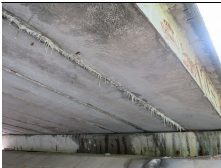
intenzivné průsaky na stativo opěry 5, intenzivní průsaky s výluhy pojiva sparou mezi krajními nosníky
