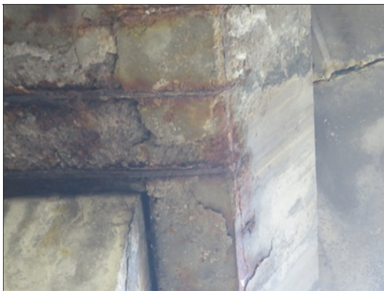
DTTO - detail - důsledkem je totální rozpad betonu a intenzivní koroze výztuže stativa spojená s významným oslabením krycí vrstvy
