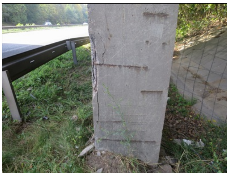
typická závada SS - rozsáhlá separace krycí vrstvy nad korodující výztuží u stojky pilíře, významné oslabení průřezových charakteristik
