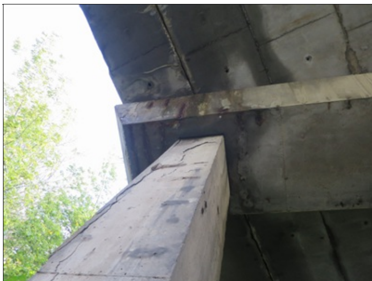
příčinou všech poruch jsou zejména průsaky nasycené CHRL a zcela nedostatečná tloušťka krycí vrstvy
