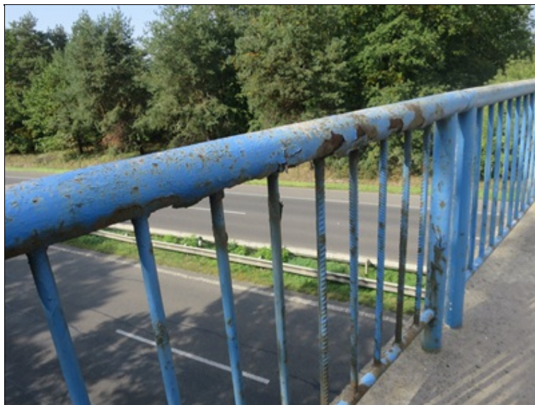
totální koroze madla levého zábradlí
