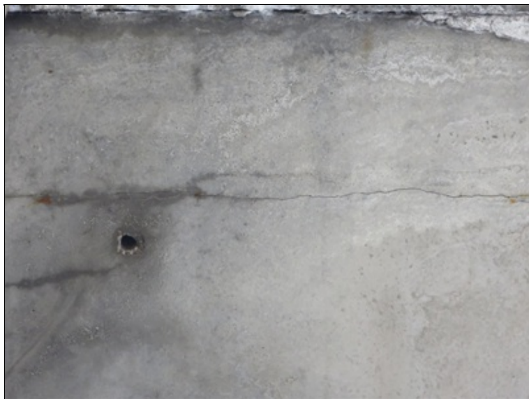
typická závada NK - podélná trhlinka na spodním líci nosníku kopíruje trajektorii předpínací výztuže prosakuje
