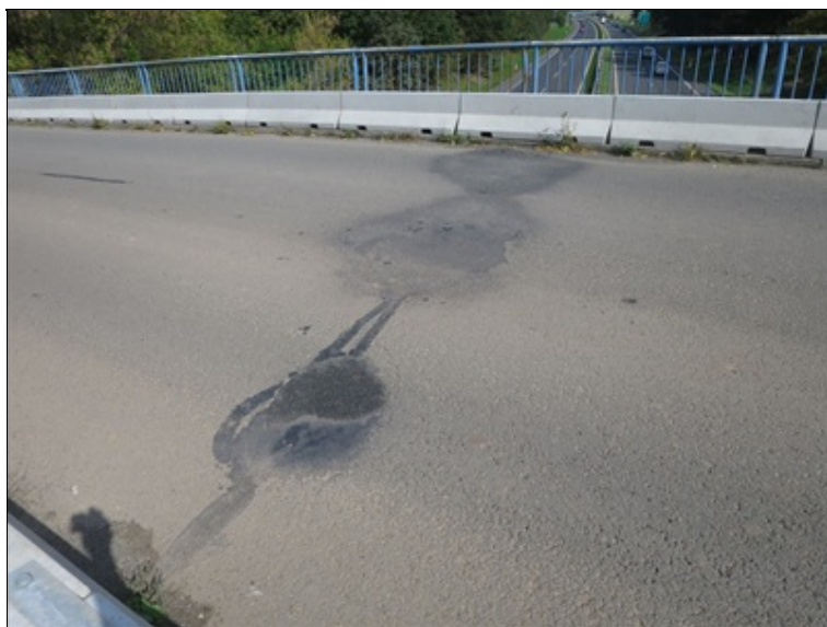
provizorní opravy nad idlatační sparou nad P3
