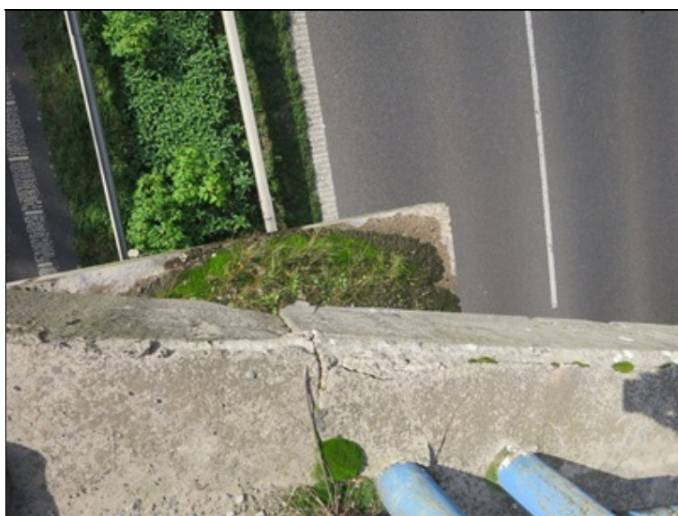
pohled na vyloženou část stativa P3 - uchycená vegetace, separace krycí vrstvy nad korodující výztuží na boku římsy, která může spadnout na podcházející komunikaci
