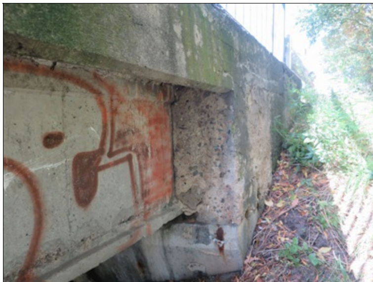
hloubková degradace betonu dobetonávky čel naonsíku na pravé straně nad O5
