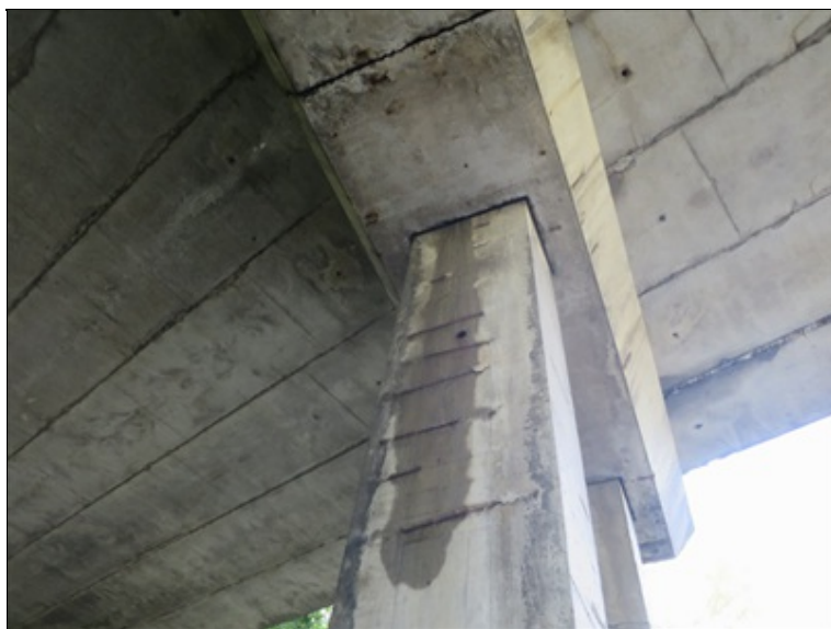
typická závada SS - voda prosakuje i stativem v místě vetknutí stojky
