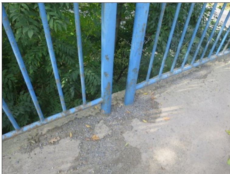
korozí zábradlí, degradace krytu chodníku
