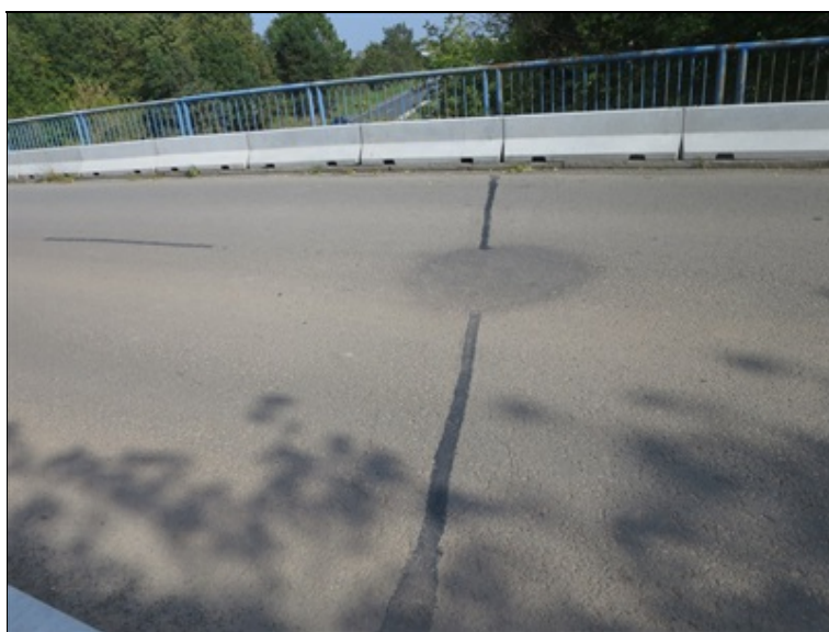
těsněná příčná spára nad dilatační sparou nad P2
