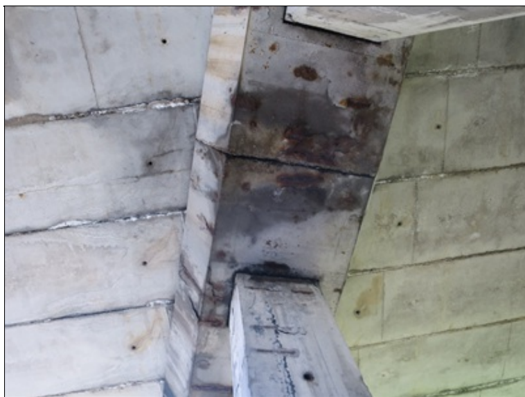
typická závada SS - intenzivní průsak příčnou pracovní sparou mezi dílci stativa pilíře
