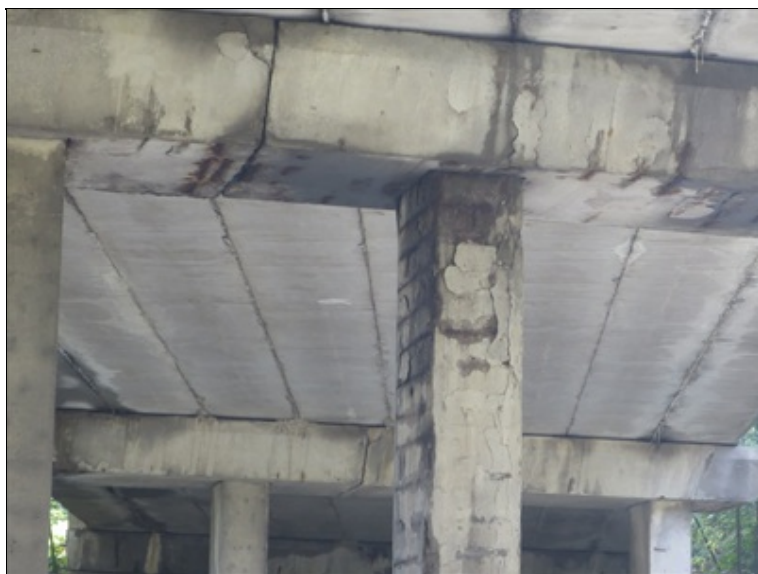
DTTO - průsaky jsou patrné i na horním líci 2. stojky P3
