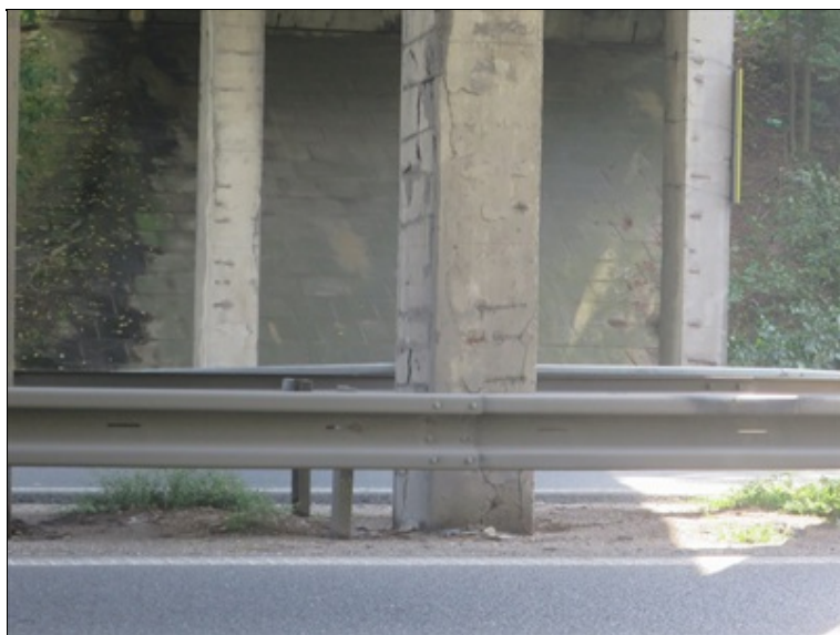
typická závada SS - v oblasti odstřiku vody nasycené CHRL z podcházející komunikace dochází k extrémnímu namáhání stojek pilířů (koroze výztuže, separace krycí vrstvy, degradace betonu, aj.)
