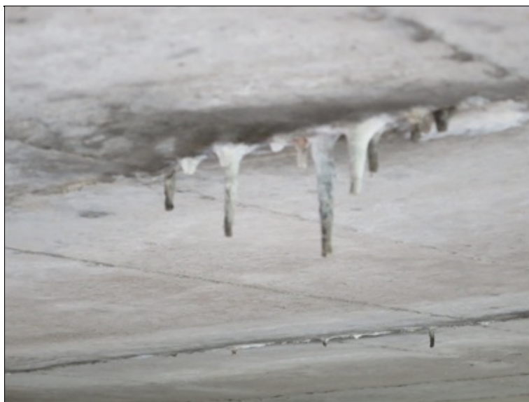
typická závada NK - stopy po průsaku sparou mezi nosníky s výraznými výluhy pojiva
