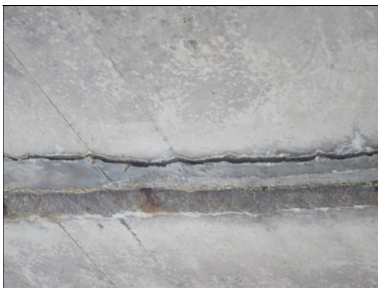
typická závada NK - sepaarce hrany nosníku v místě průsaku sparou mezi nosníky
