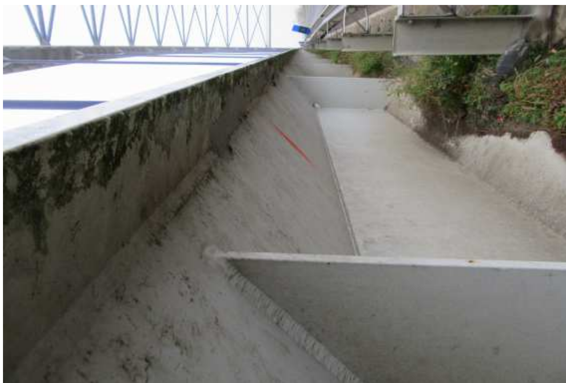
Odlupování vrchního nátěru zespodu pásnice hlavního nosníku v hlavním poli mostu
