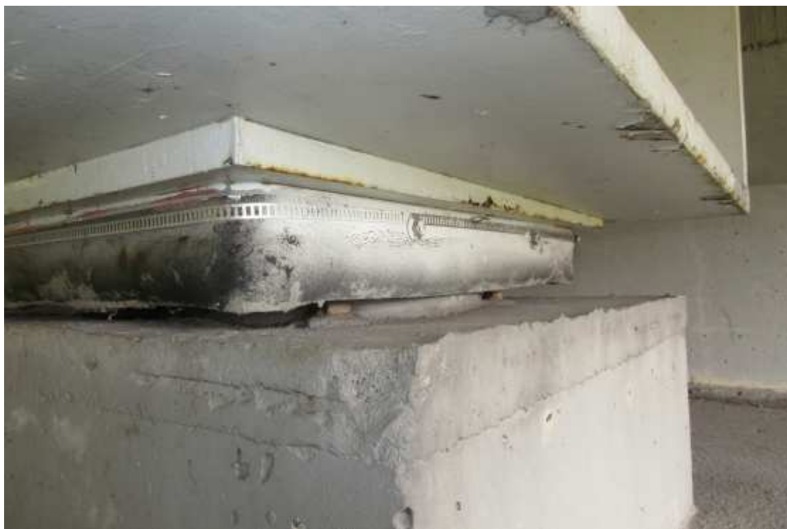
Pohled na ložisko mostu a prorezivění hran klínové desky
