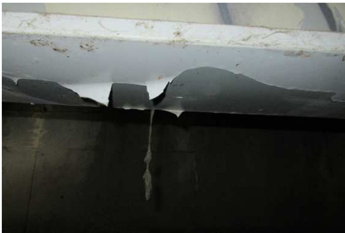
Odlupování vrchního nátěru u příčnicku O4
