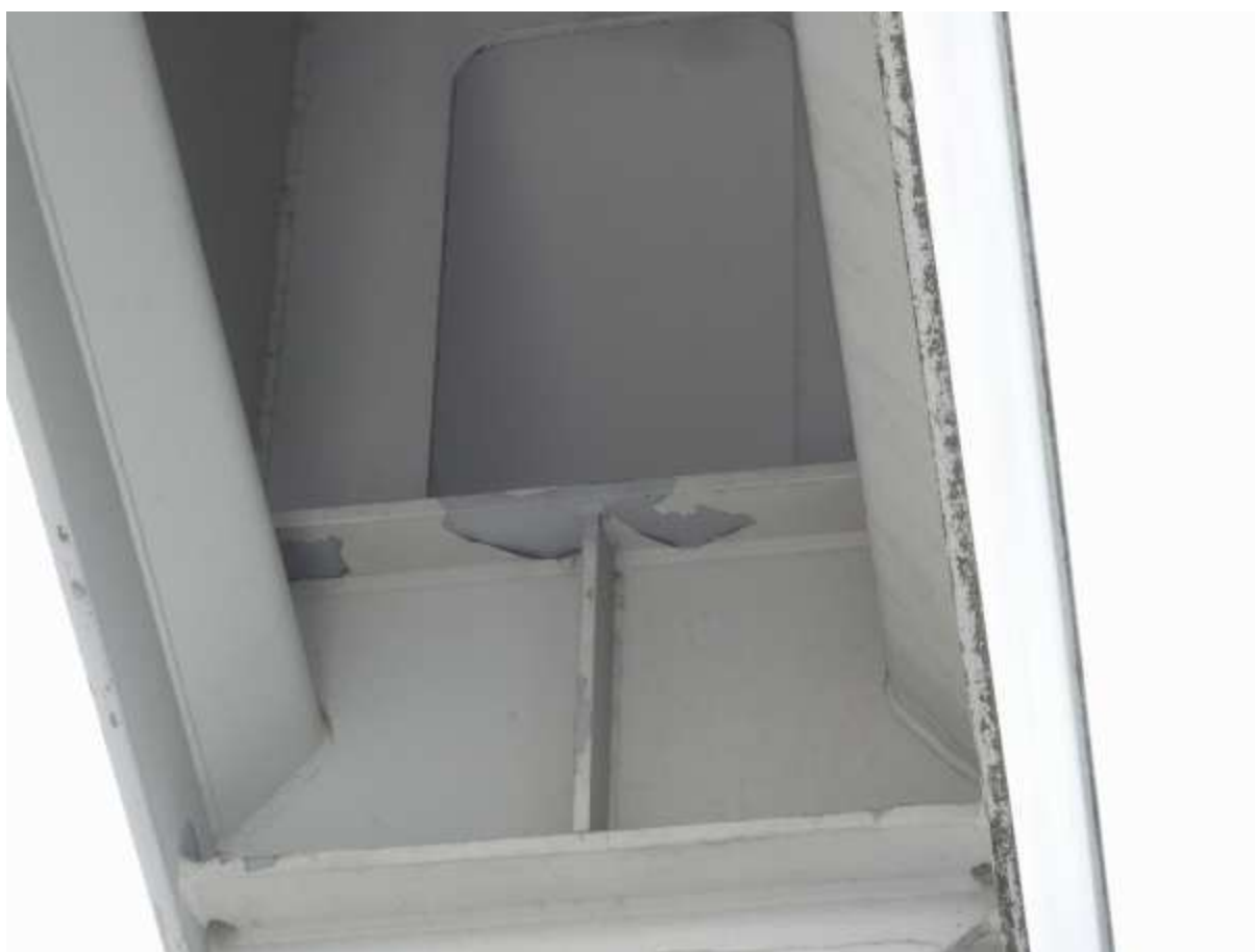
Často se vyskytující odlupování vrchního nátěru v místě uchycení závěsu mostu
