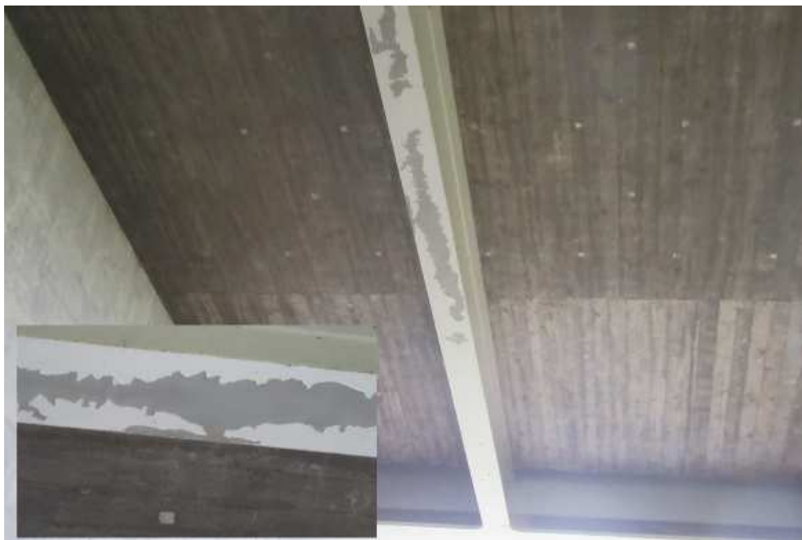
Odlupování vrchního nátěru na příčnicích v krajním poli mostu
