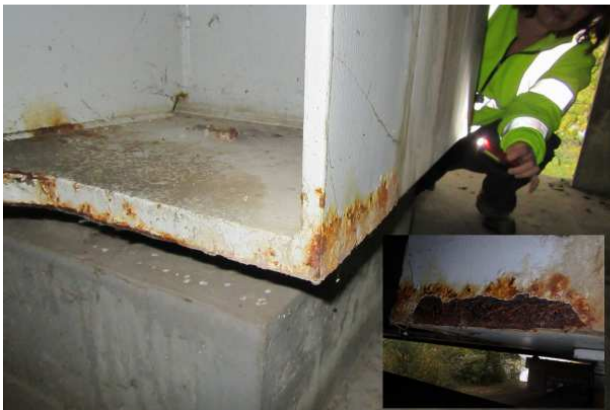
Prorezivění konce hlavního nosníku v místě uložení O4
