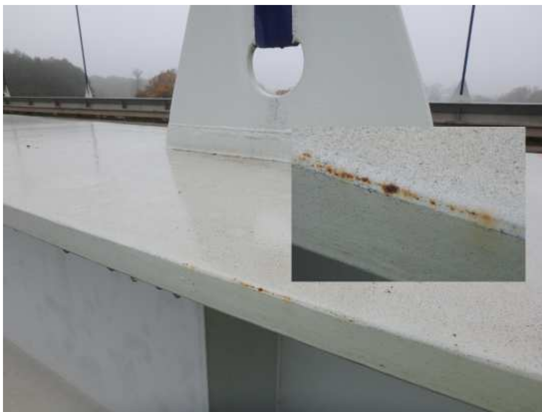
Prorezivění hrany hlavního parapetního nosníku v poli směrem do chodníku
