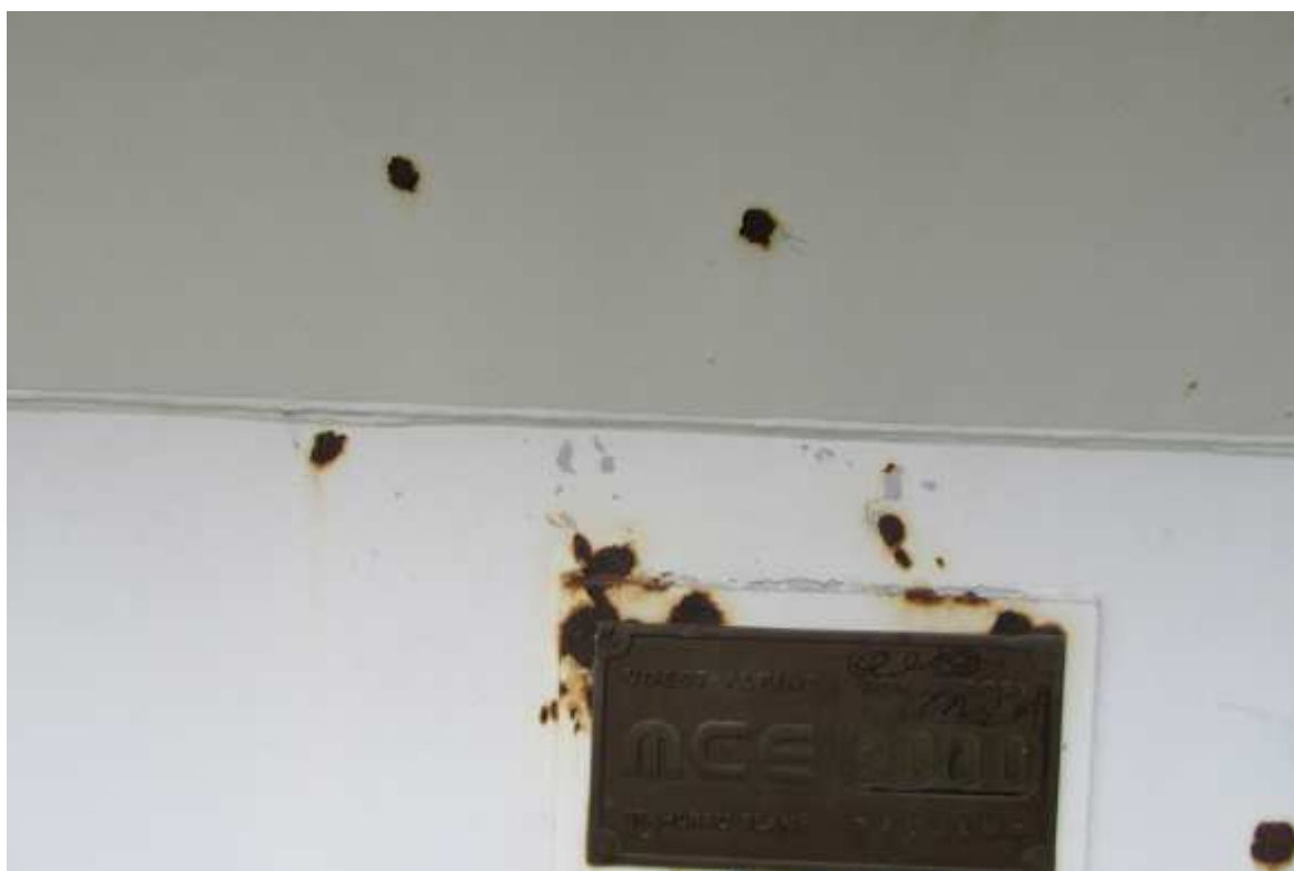
Prorozivění v oblasti štítu výrobce
