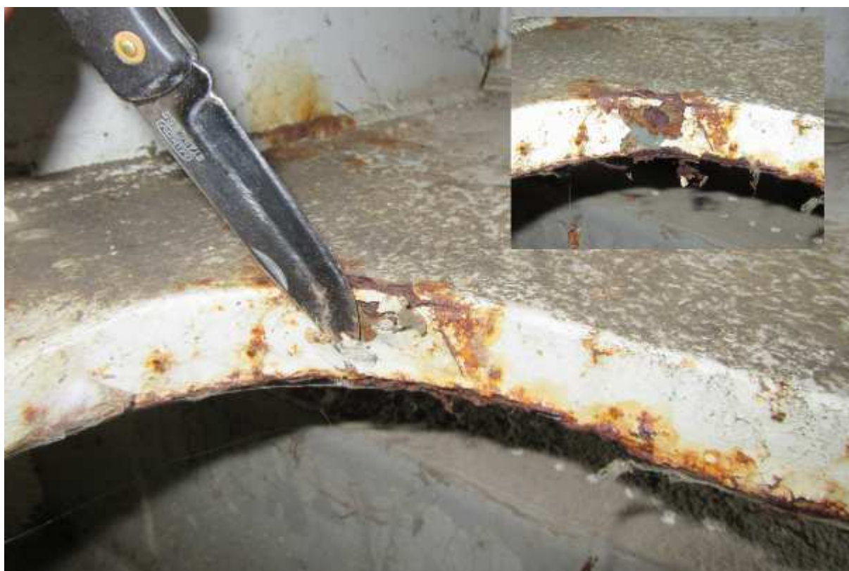
Prorezivění na hranách v napojení dolní pásnice hlavního nosníku a příčnicku u O4
