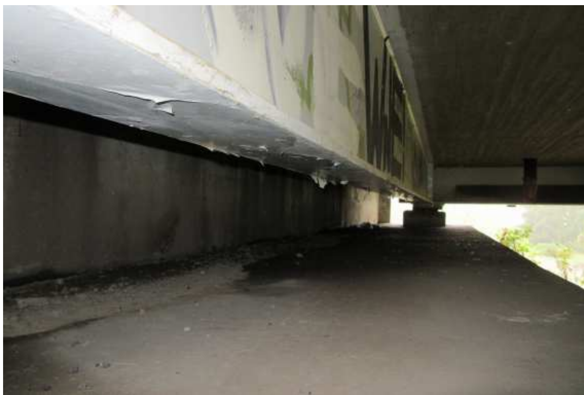
Odlupování vrchního nátěru u příčnicku O4
