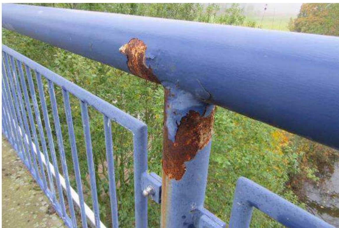
Prorezivění sloupku a madla zábradlí v krajním poli mostu
