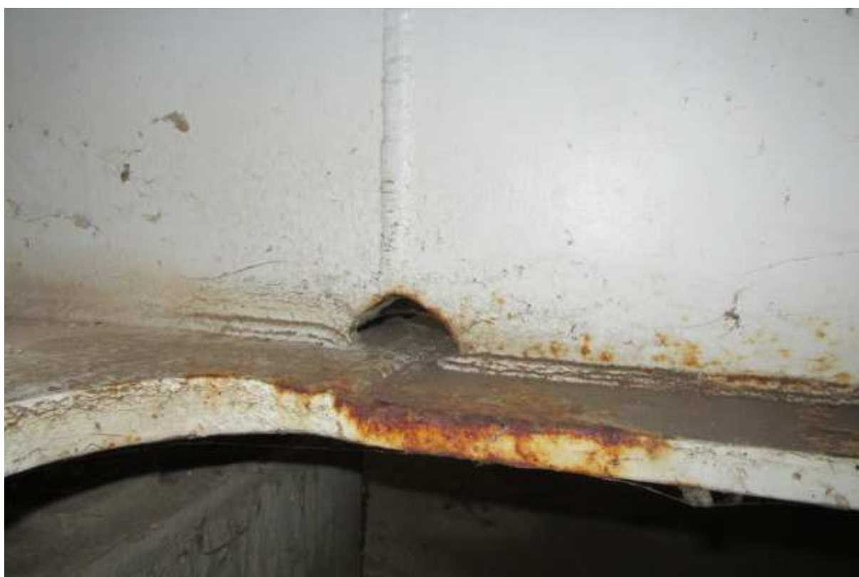
Prorezivění dolní pásnice příčnicku v místě styku s hlavním nosníkem u O4
