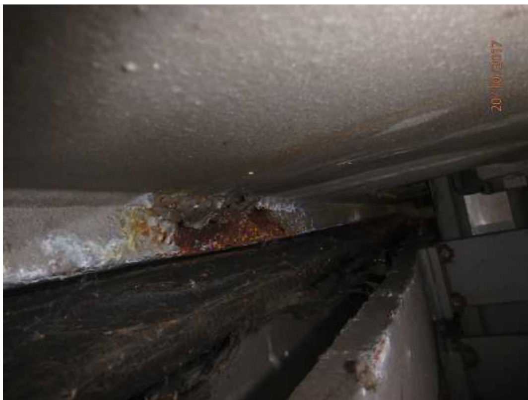
Pohled na krajní profil MZ zespodu. Prorezivění hran a počínající plošná koroze základního materiálu
