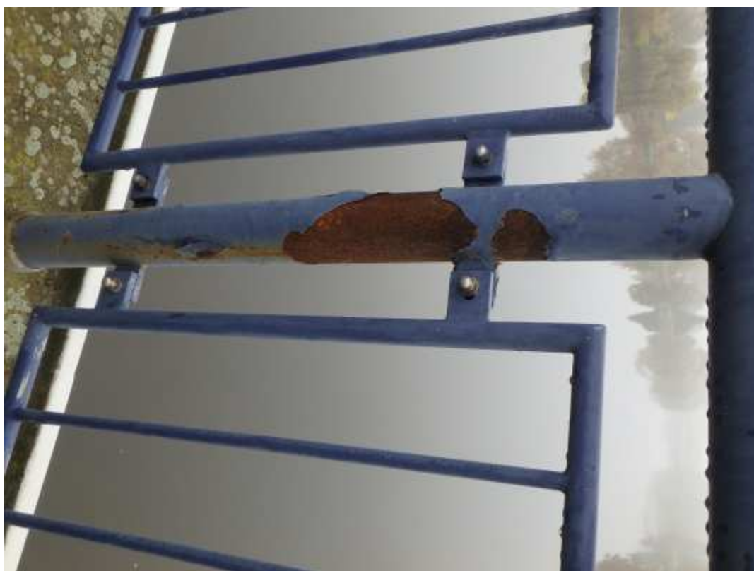
Pohled na sloupek zábradlí s podkorodováním OPS a plošnou korozi základního materiálu
