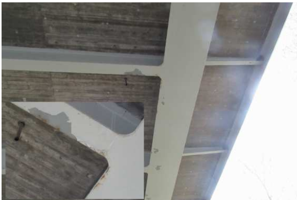
Odlupování vrchního nátěru a prorezivění hran na hlavních nosnících a příčnicích v krajním poli mostu
