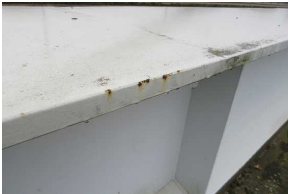
Prorezivění hrany hlavního parapetního nosníku v poli směrem do chodníku
