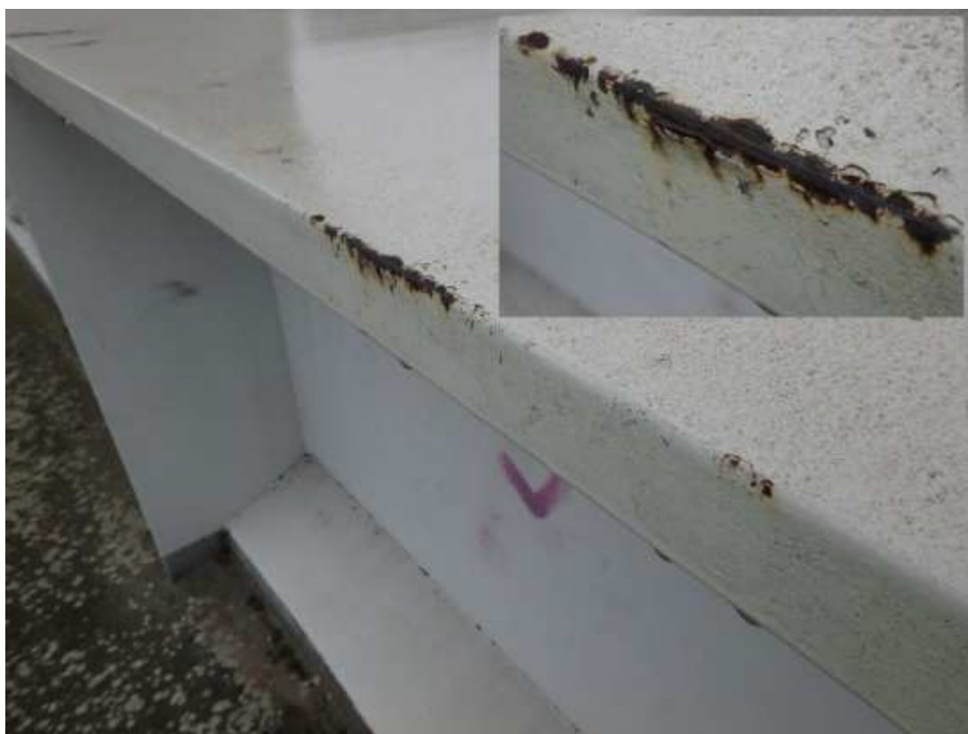
Prorezivění hrany hlavního parapetního nosníku v poli směrem do chodníku
