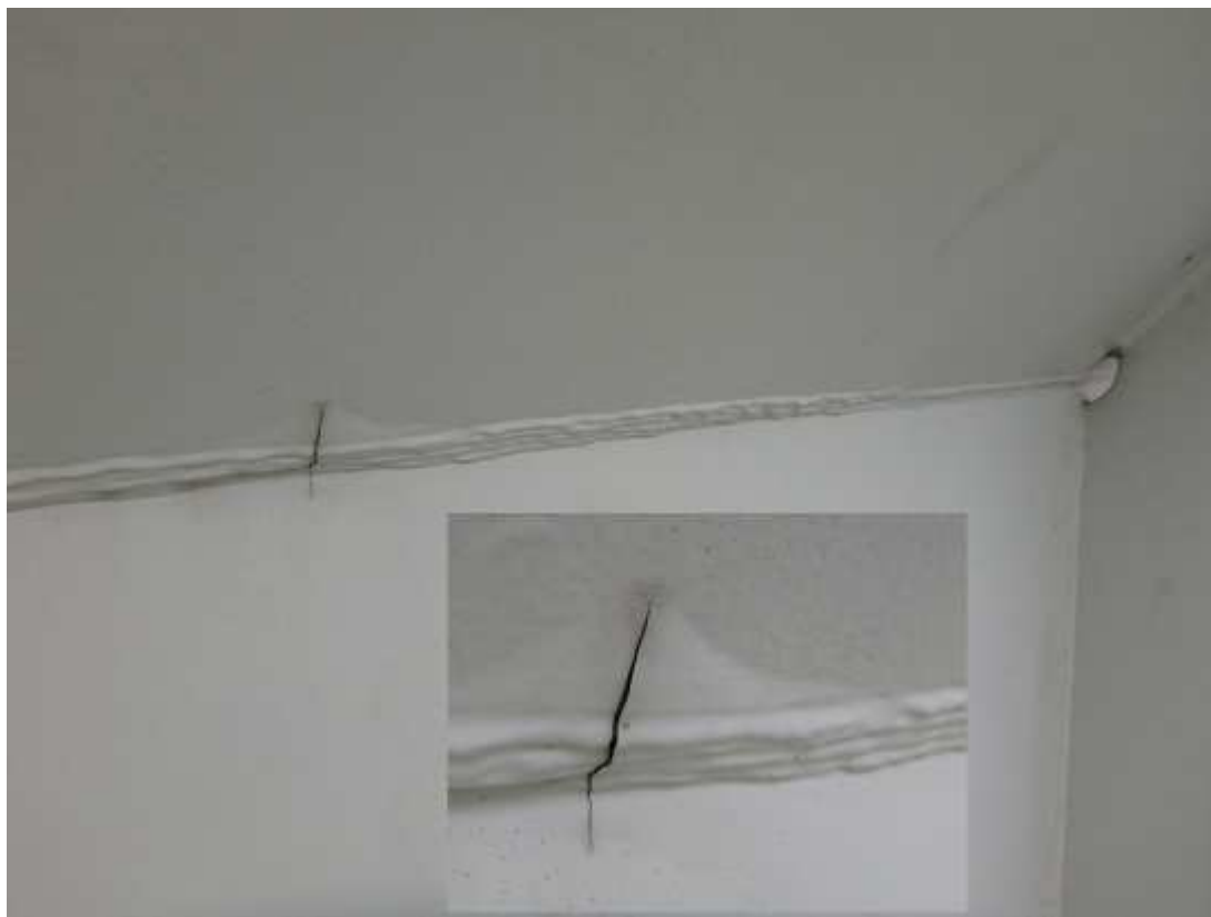
Trhlina ve vrchním nátěru v krajním poli mostu
