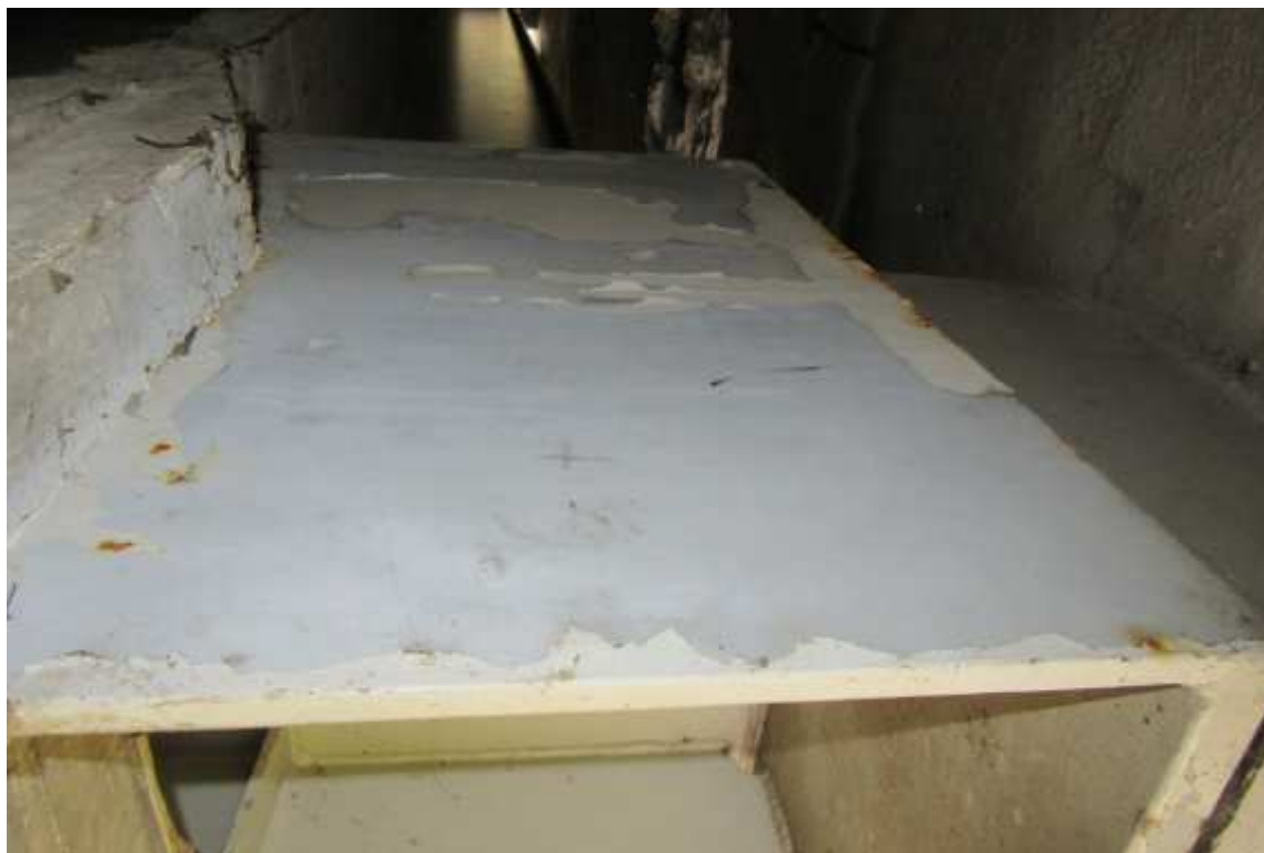
Zcela chybějící vrchní nátěr na konci hlavního parapetního nosníku u O1
