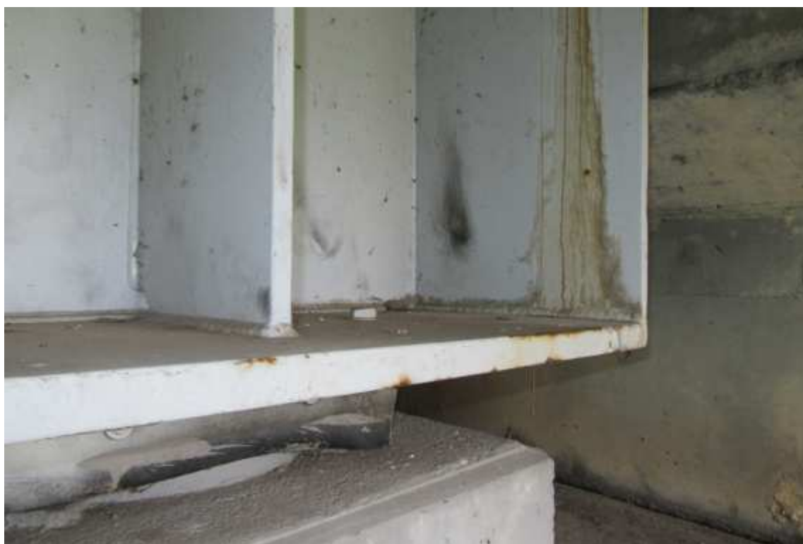
Prorezivění hran dolní pásnice hlavního nosníku u O1
