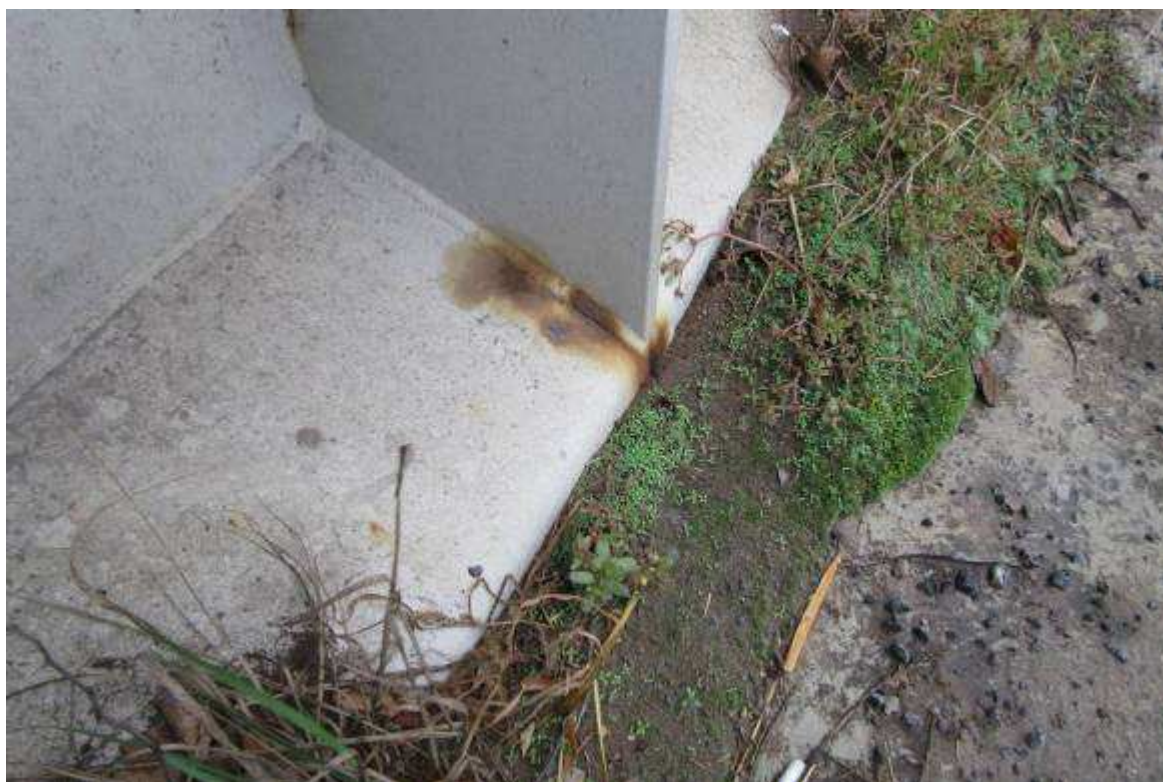
Prorozivění v místě krycího plechu směrem do vozovky, velké nánosy úsad pod kterými bude na mnoha místech porušena PKO a bude docházet k prorozivění
