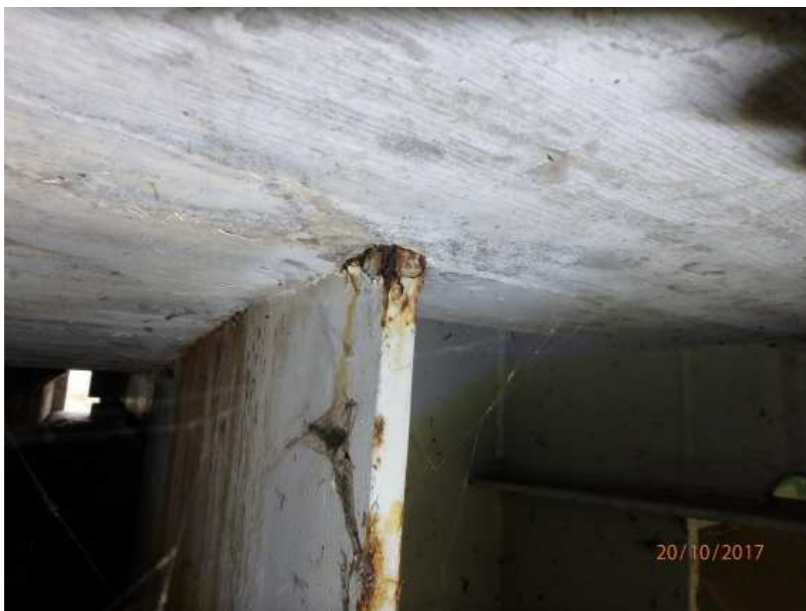
Prorezivění na hraně koncového plechu hlavního parapetního nosníku u O4
