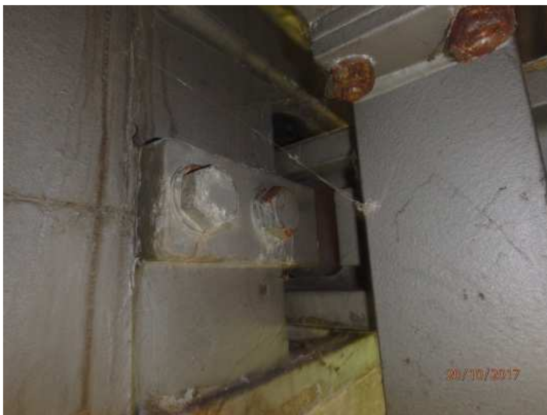
Pohled na MZ zespodu a korozi spojovacího materiálu
