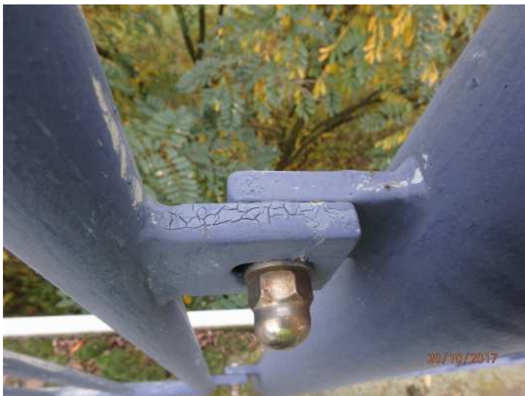
Pohled na uchycení výplně zábradlí ke sloupku a praskání OPS
