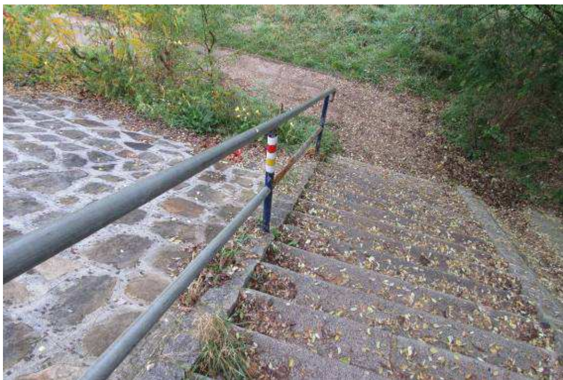
Pohled na trubkové zábradlí schodiště. Nátěr na většině ploch chybí, zůstává pouze žárový Zn nebo dochází k plošné korozi
