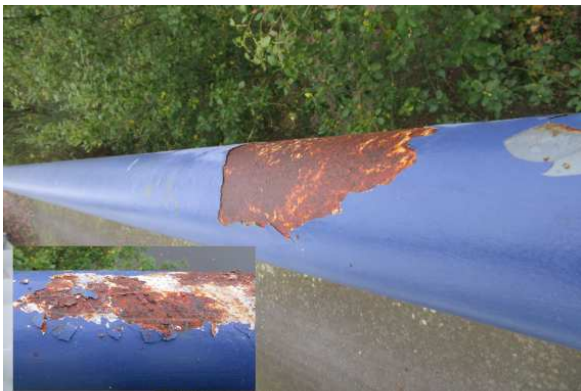
Prorezivění madla zábradlí a pohled na korozní produkty po odstranění nesoudržné vrstvy PKO
