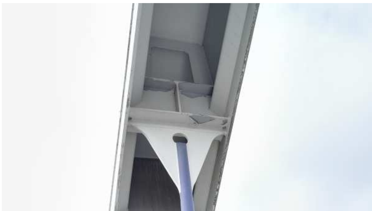
Odlupování vrchního nátěru v místě uchycení závěsu mostu
