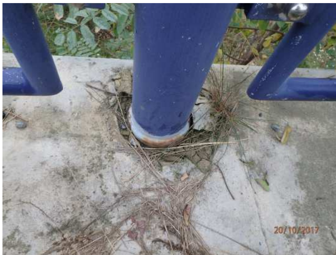
Pohled na patku sloupku zábradlí. Patrné podkorodování nátěru v patě sloupku
