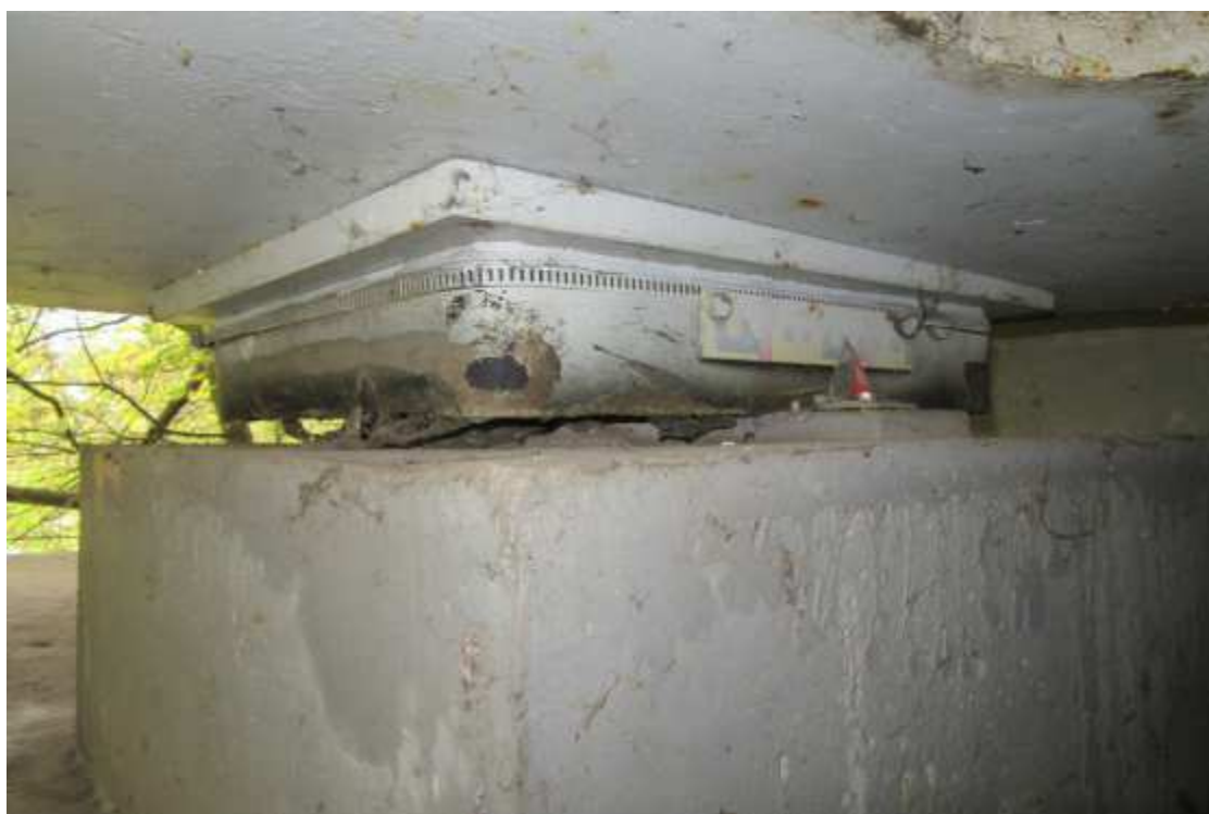
Pohled na ložisko mostu a prorezivění hran klínové desky
