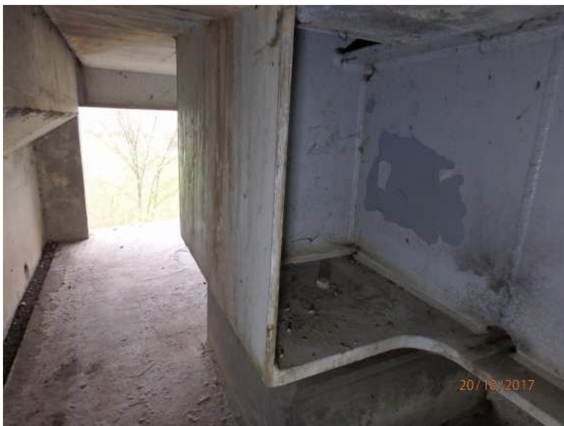
Odlupování vrchního nátěru na styku hlavního nosníku a příčnicku u O4
