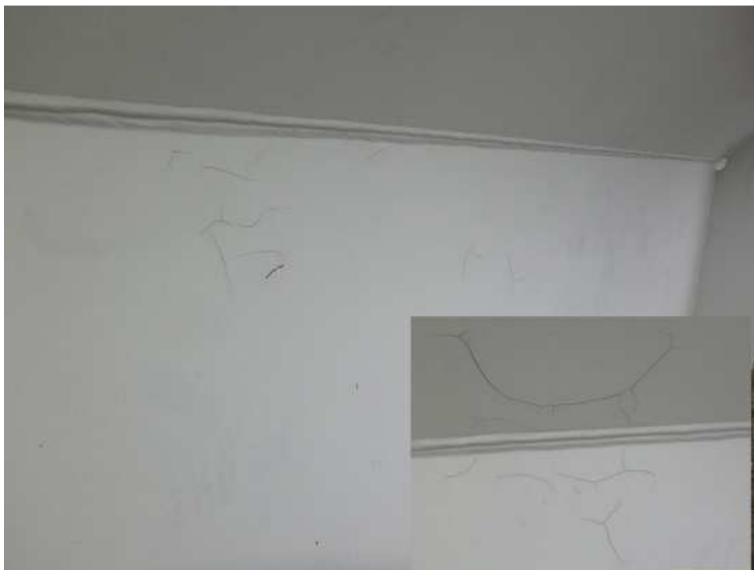
Praskání vrchního nátěru v poli mezi výztuhami (výskyt v omezené míře)
