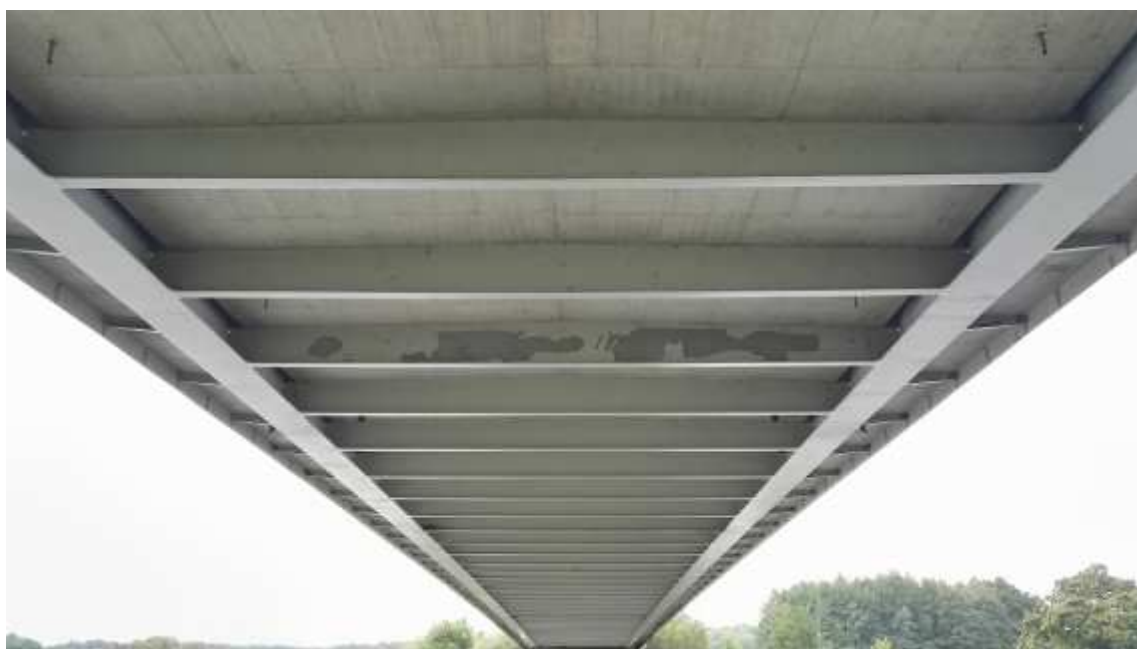
Odlupování vrchního nátěru na příčnicích v hlavním poli mostu z podhledu (nad řekou)
