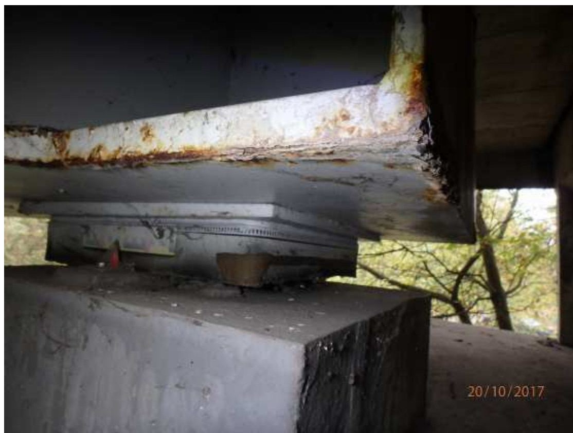
Prorezivění dolní pásnice hlavního nosníku u opěry O4
