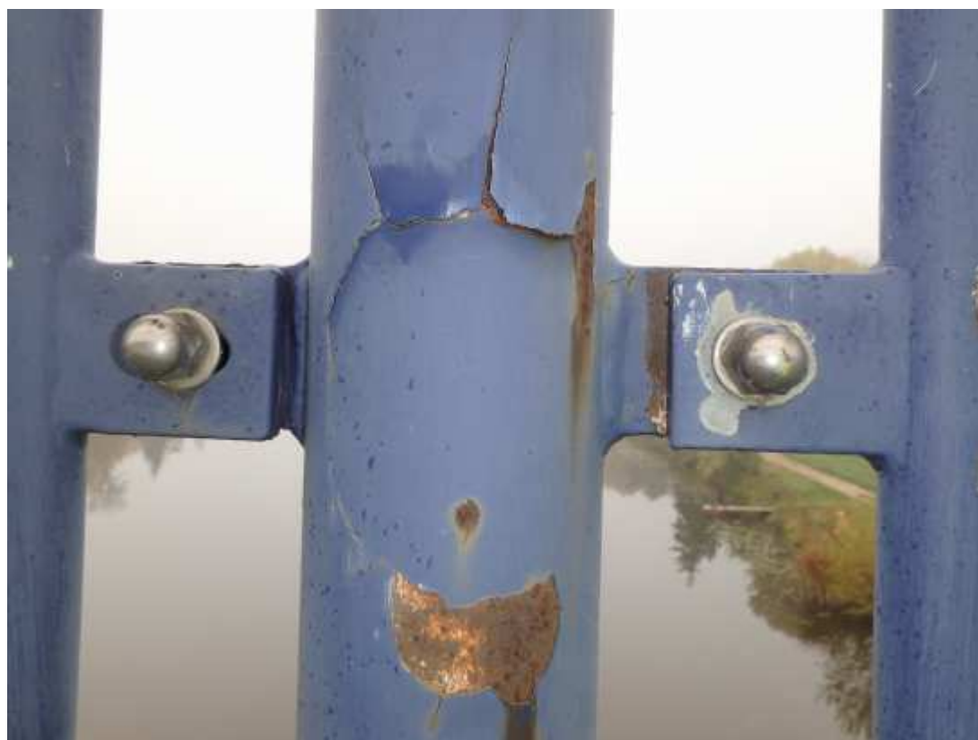
Pohled na sloupek zábradlí se zcela se odlupujícím souvrstvím OPS
