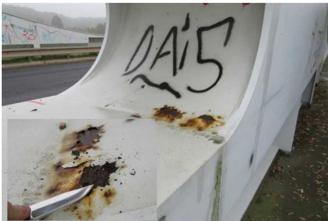
Prorézivění v místě napojení hlavního nosníku na oblouk mostu. OPS v oblasti výskytu těchto korozních projevů je podkorodován.
