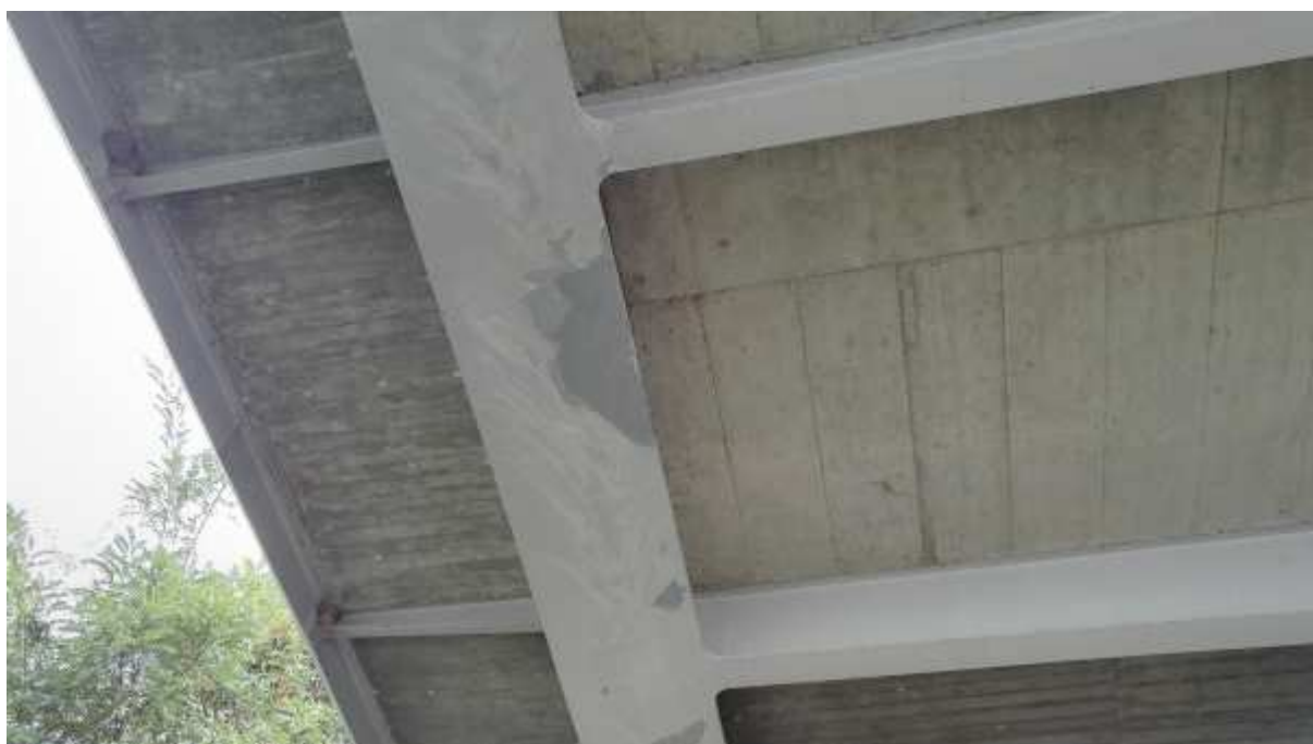
Odlupování vrchního nátěru na hlavním nosníku v krajním poli mostu
