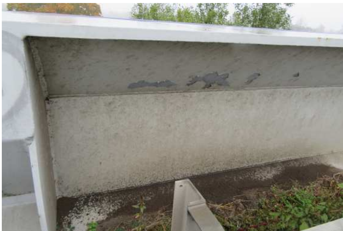
Odlupování vrchního nátěru zespodu výztuhy hlavního nosníku v krajním poli mostu
