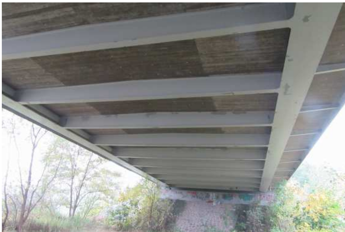
Odlupování vrchního nátěru na hlavních nosnících a příčnících v poli 1 z pohledu
