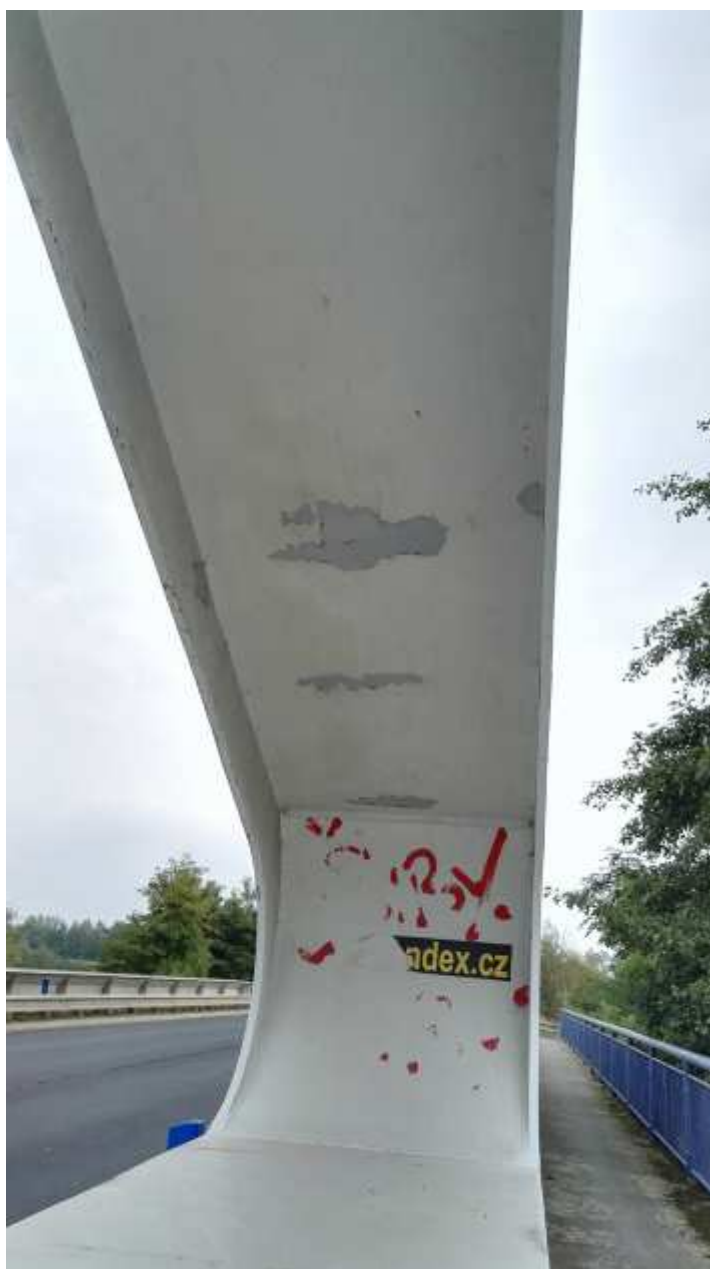
Odlupování vrchního nátěru z pohledu oblouku mostu
