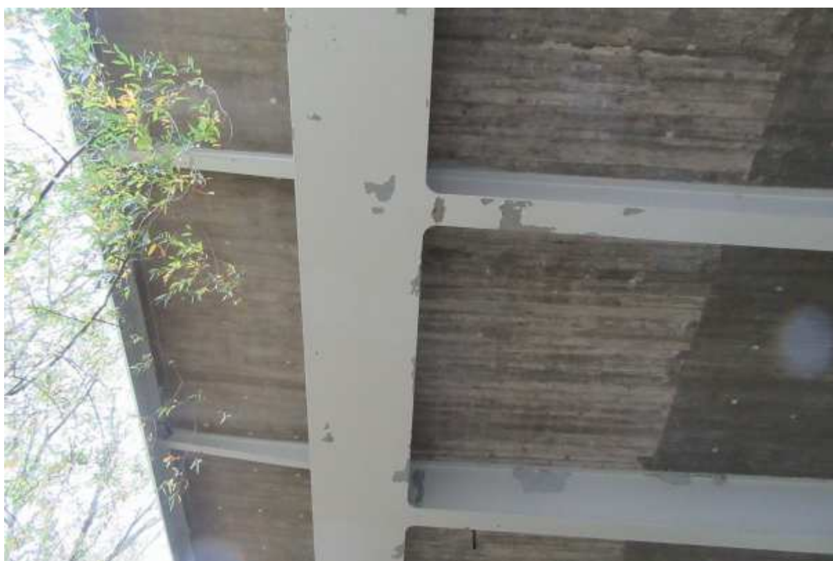
Odlupování vrchního nátěru na hlavních nosnících a příčnicích v krajním poli mostu
