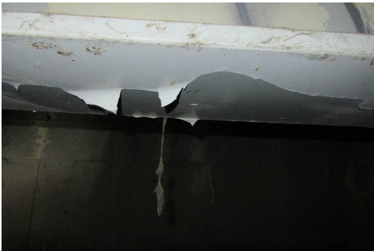
Obrázek č.2 – Odlupující se vrchní nátěr, typické plochy pro odstranění vrchního nátěru a případných dalších nesoudržných vrstev
