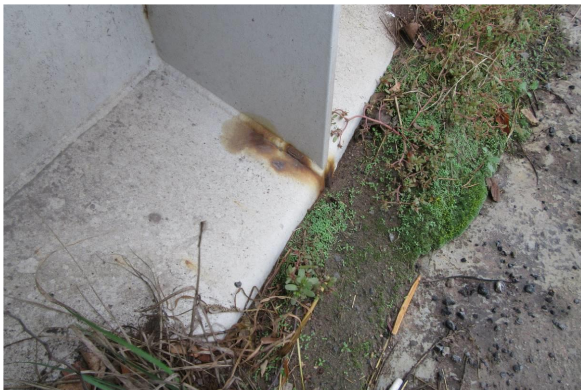
Obrázek č.6 – Porušený OPS až na podkladový kov, typická plocha pro suché abrazivní přetřeskání na až na základní materiál
