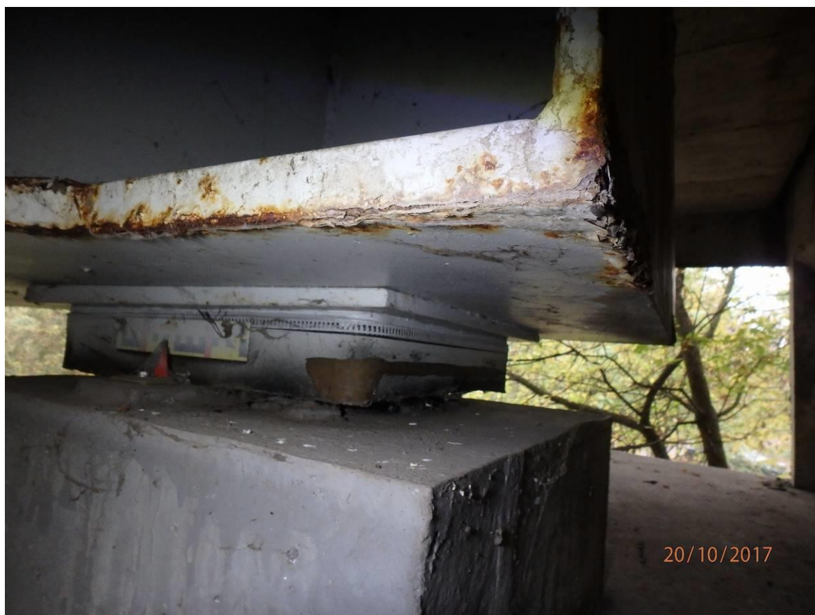
Obrázek č.5 - Porušený OPS až na podkladový kov, typická plocha pro suché abrazivní přetřeskání na až na základní materiál
