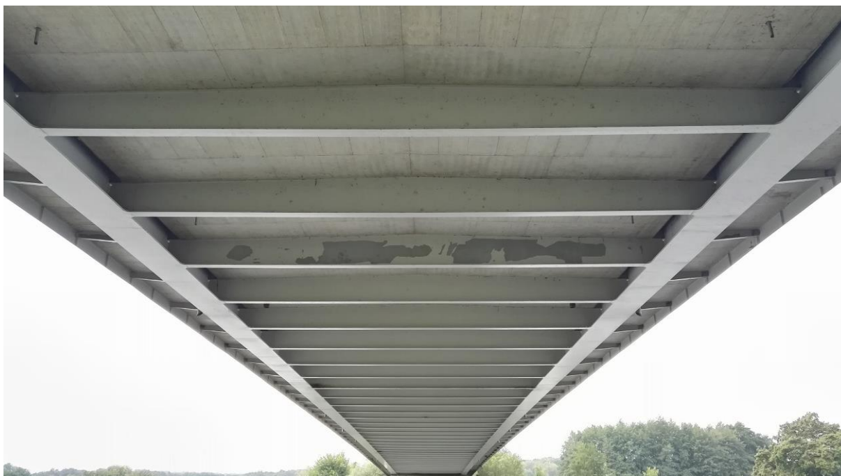
Obrázek č.3 - Odlupující se vrchní nátěr, typické plochy pro odstranění vrchního nátěru a případných nesoudržných dalších vrstev
