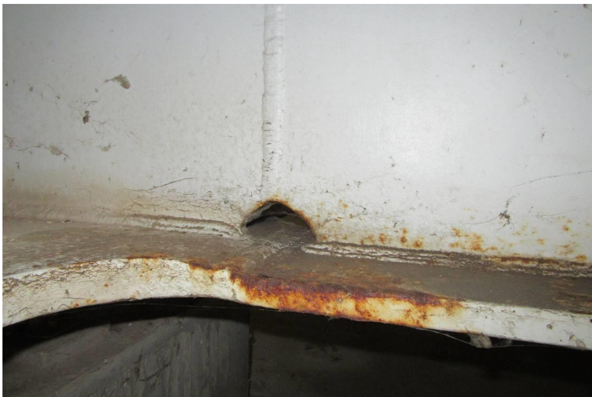
Obrázek č.4 – Porušený OPS až na podkladový kov, typická plocha pro suché abrazivní přetřeskání až na základní materiál
