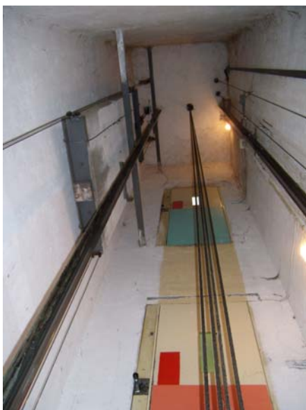
Vrchní část šachty
