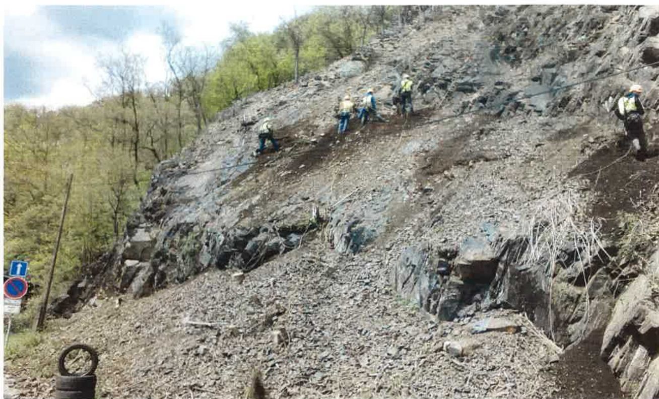
foto 1, SO 101, Očistenie skalnej steny, květen 2017
