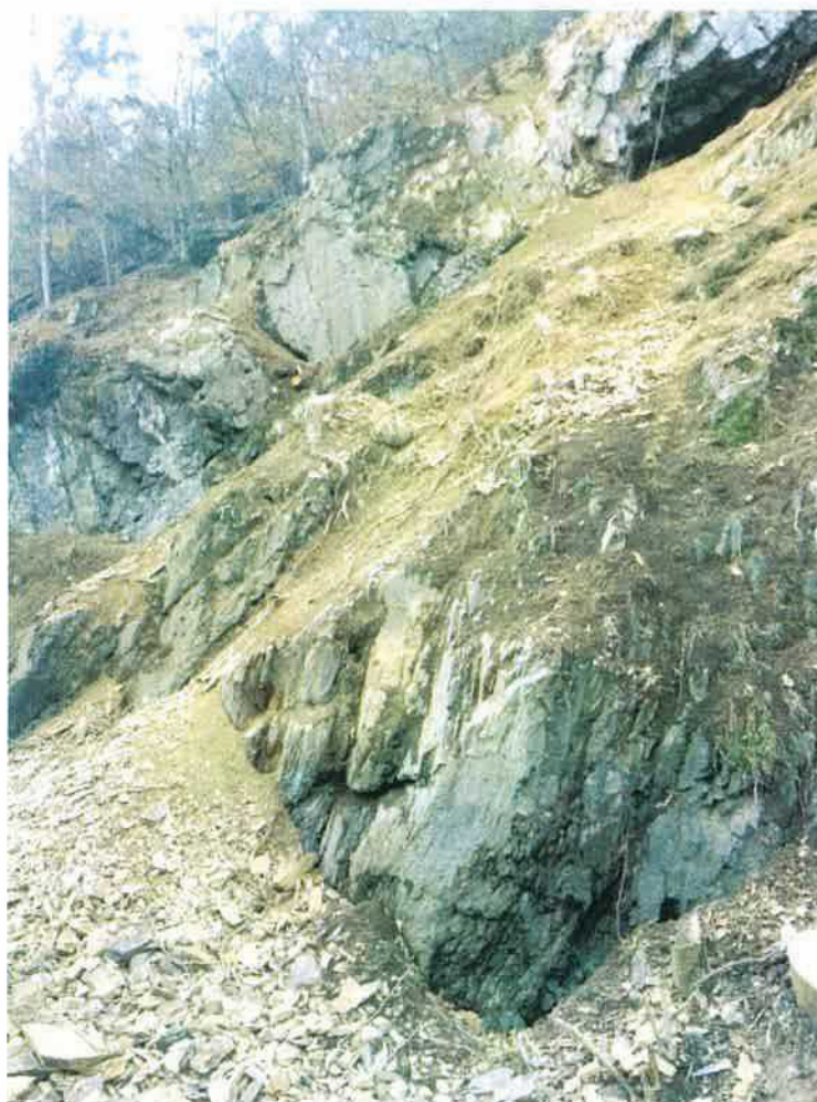
foto 2, SO 106, čištění skalní stěny, říjen / listopad 2017
