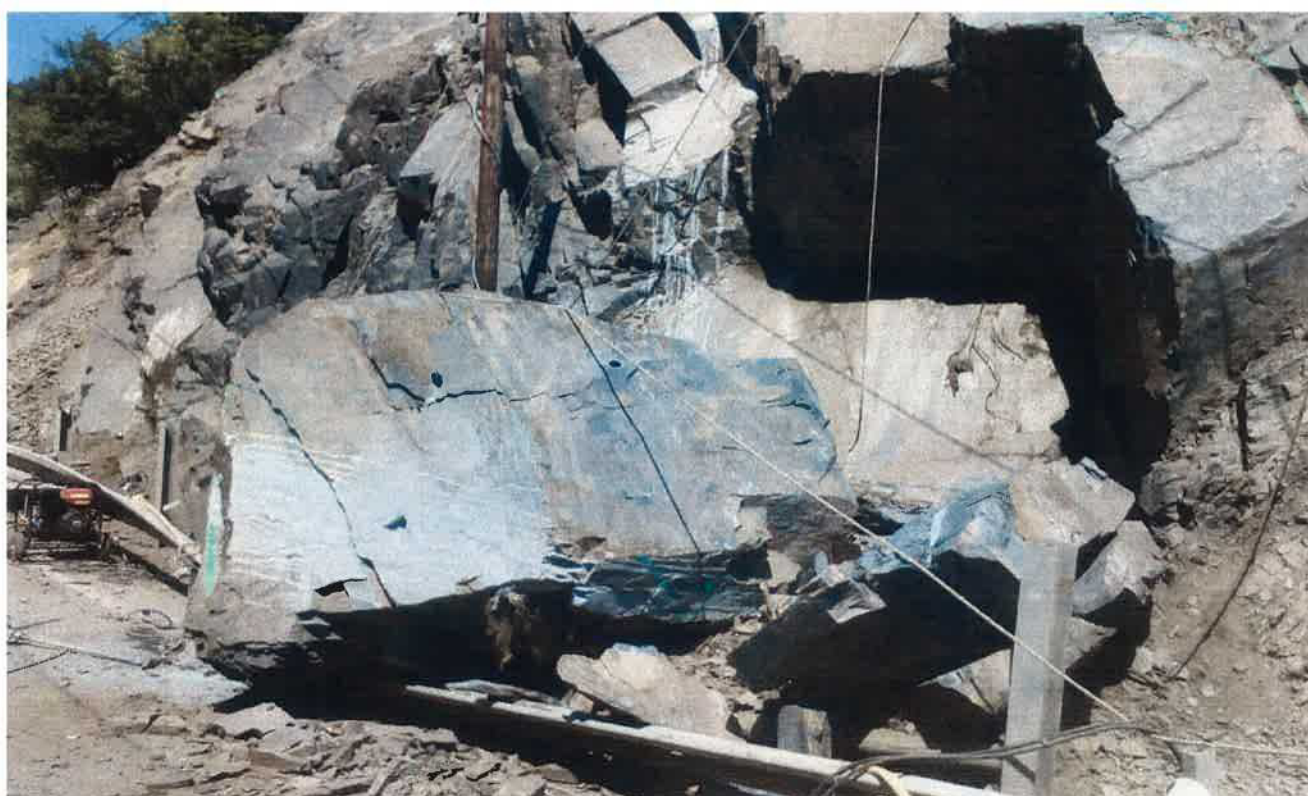
foto 2, SO 101, Dolam skal , květen 2017
