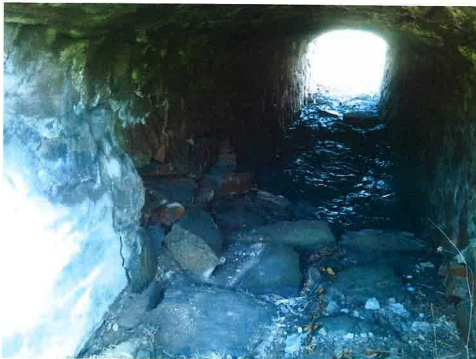
Stávající stav propustku na II/112 v km cca 3,80
