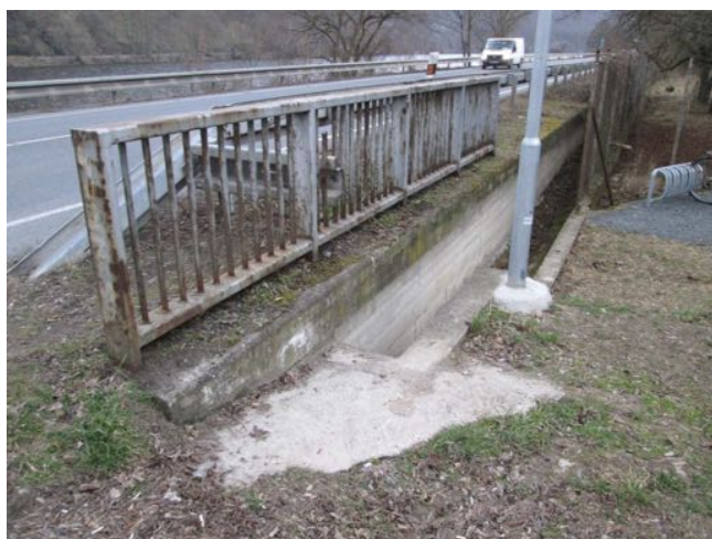
Koroze zábradlí.
