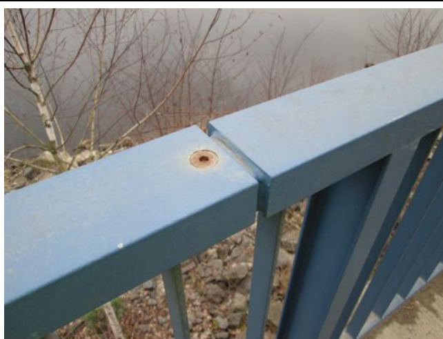
Zábradlí. Povrchová koroze šroubů. Nátěr matovatí.
