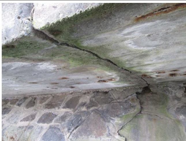
Trhlina, nebo otevřená dilatační spára. Průsaky. Bionapadení.
