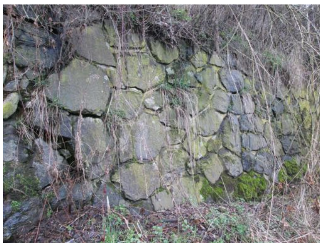
Ojedinělé poškození spárování.
