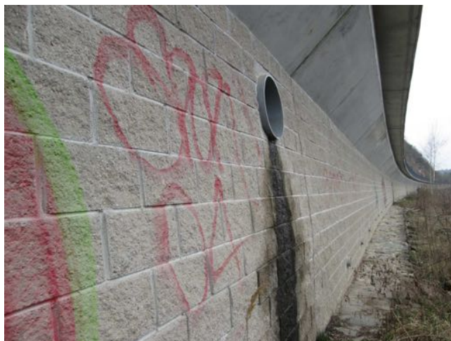
Přetoky vody z kanalizace na líc zdi. Povrch znečištěn. Posprejováno.
