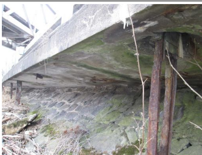
Dtto. Stopy zatékání. Bionapadení.
