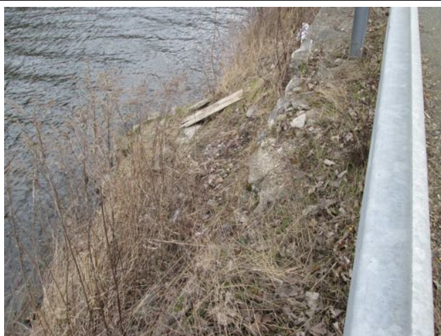
Masivní degradace betonu římsy, lokální rozpad.
