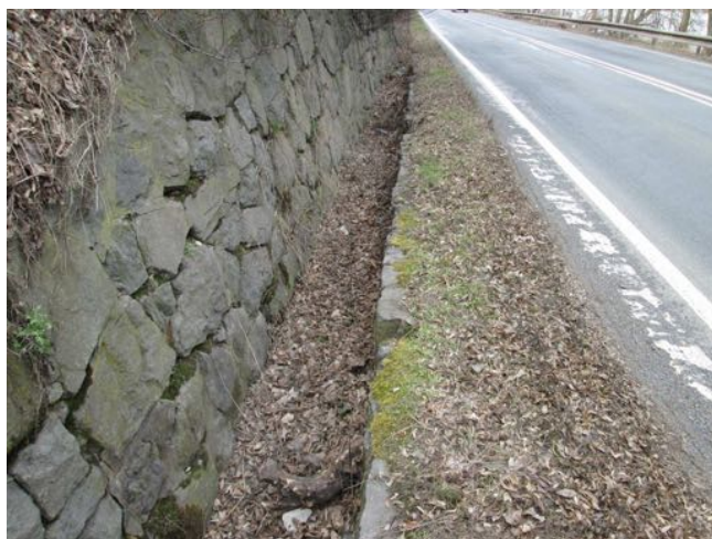
Příkop částečně zanesený.
