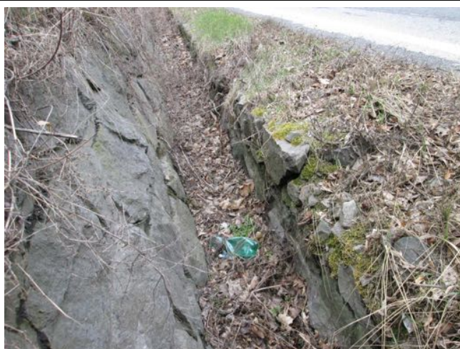
Lokálně vydrolené spáry.
