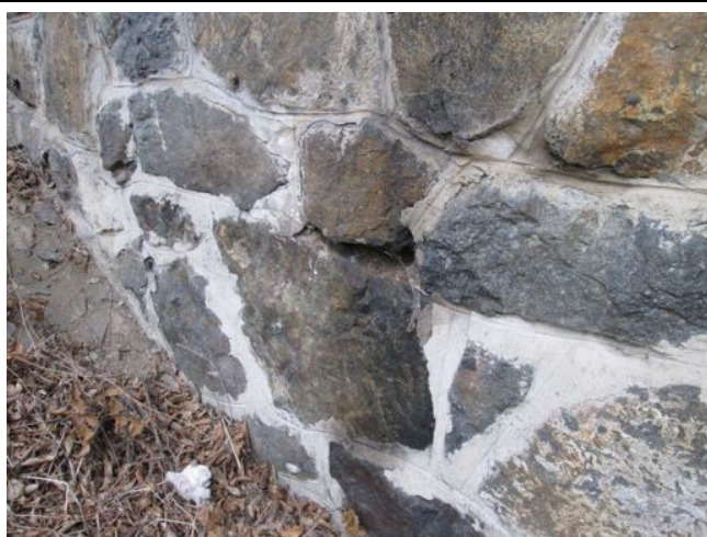
Detail zdiva. Lokálně poškozené spáry.
