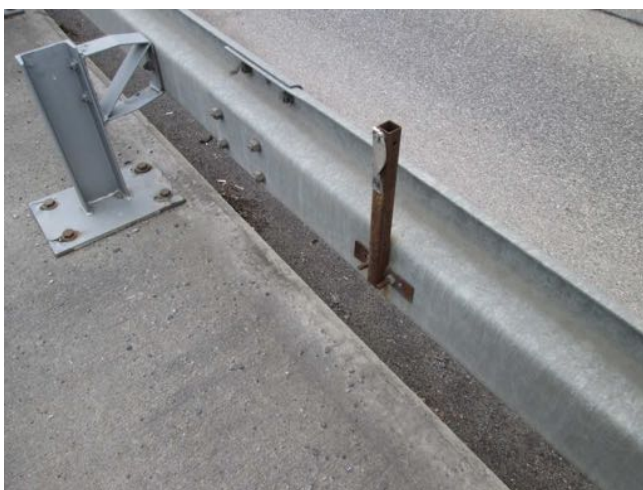
Poškozené směrové sloupky.
