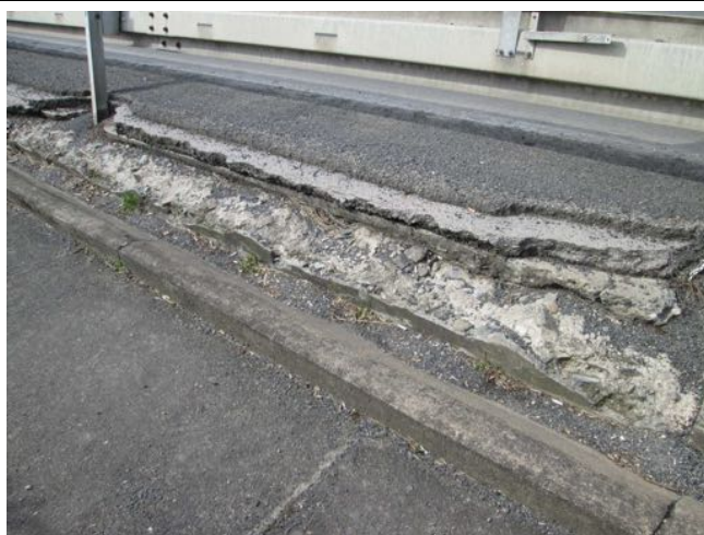
Masivní degradace betonu, rozpad. Část zdi chybí.
