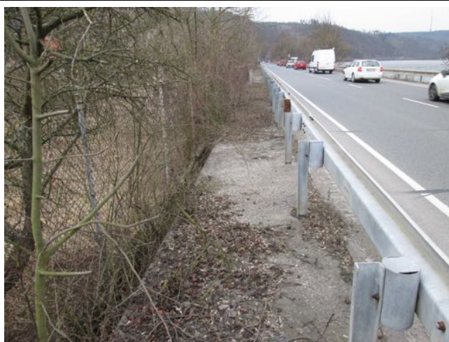
Nánosy, nečistoty na římse.
