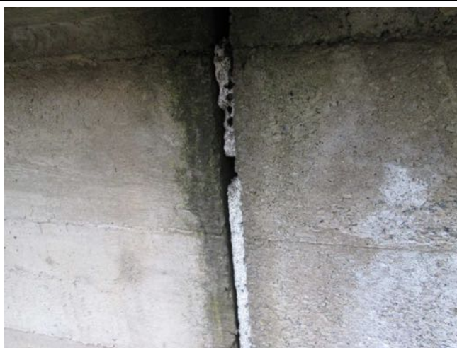
Poškozené těsnění dilatační spáry. Stopy průsaků. Nazelenalý povlak, biologické napadení.
