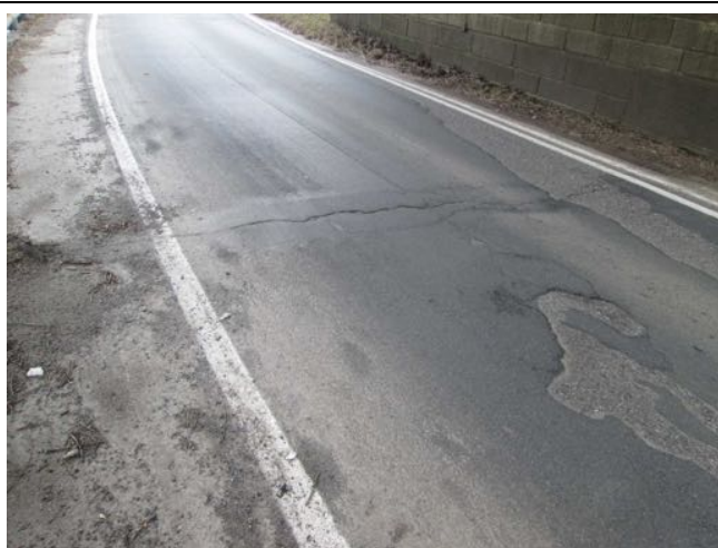
Dilatační spáry prokreslené do vozovky.
