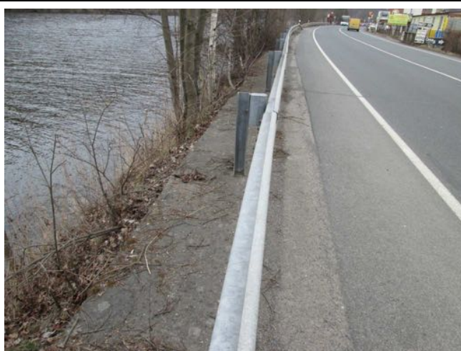
Povrchová degradace betonu.
