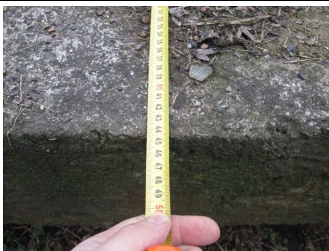
Římsa vpravo. Povrchová degradace.
