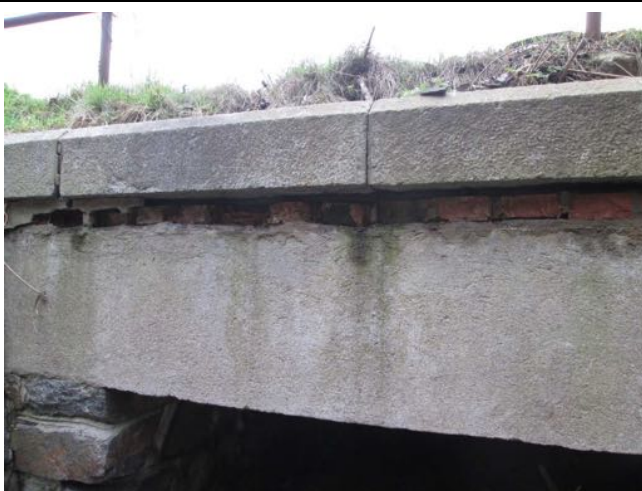
Rozpad cihel pod římsou vpravo.
