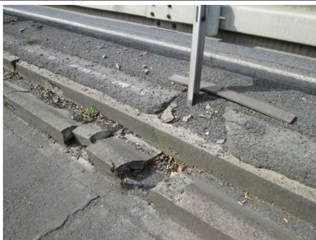
Rozpad předsazeného řlabu.
