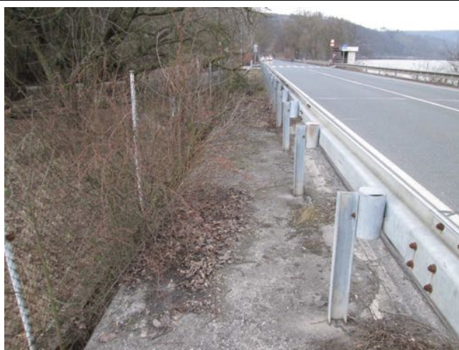
Nánosy, nečistoty na římse.
