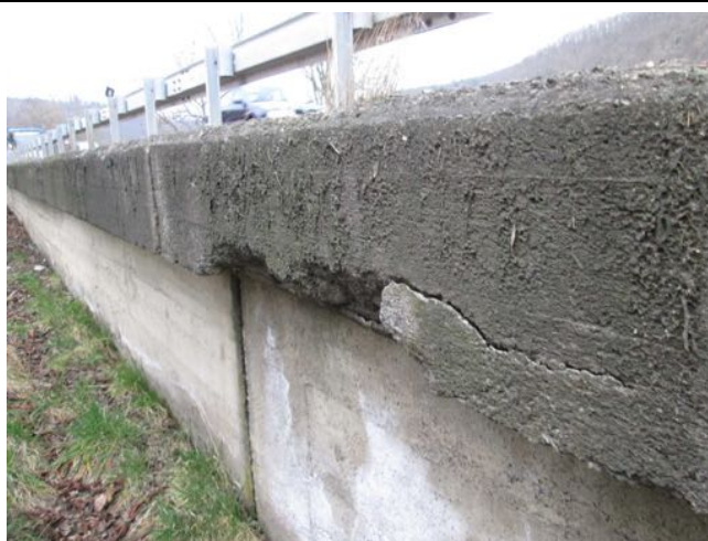
Odpadlá krycí vrstva, koroze obnažené výztuže.
