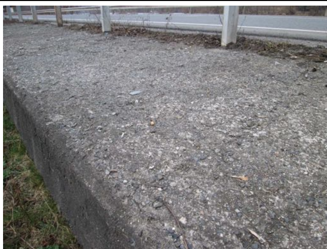
Degradace betonu římsy.
