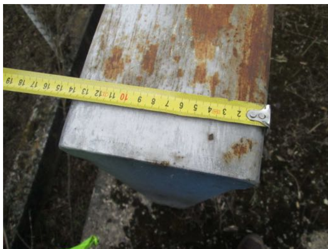
Koroze zábradlí.
