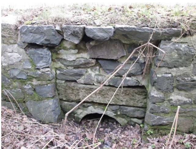
Vydrolené spáry. Částečně zanesený propust.
