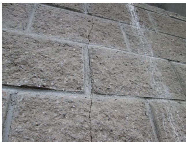
Trhlina v obkladu v místě dilatační spáry. Šířka do 2 mm.
