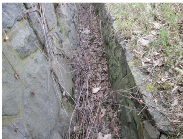
Příkop částečně zanesený.
