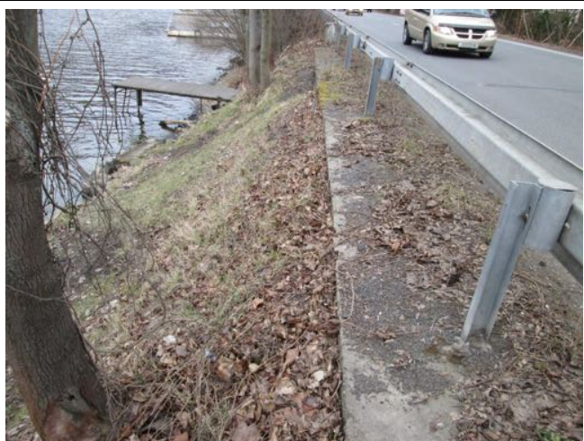
Nečistoty, nánosy na římse.
