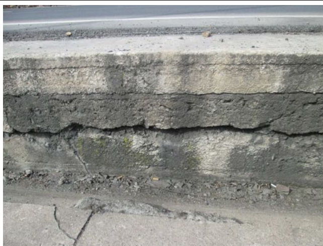
Vodorovná trhлина nebo otevřená pracovní spára. Masivní degradace betonu.
