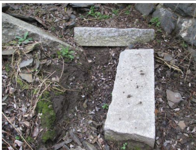
Kamenné bloky římsy shozené do koryta.
