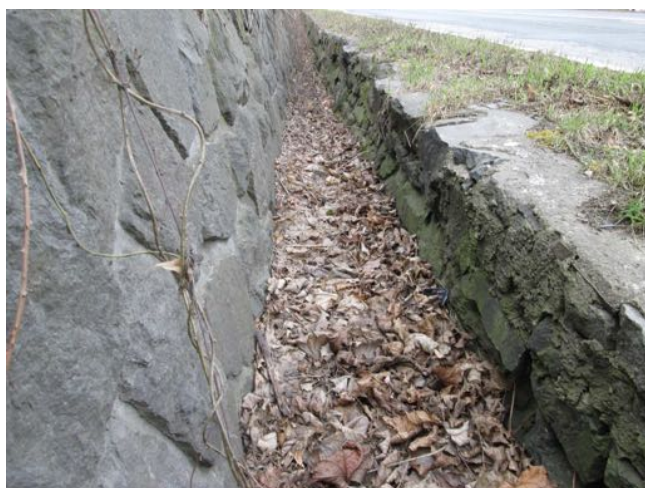
Lokálně vydrolené spáry.
