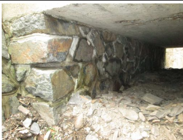
Opěra 1. Lokálně poškozené spárování.
