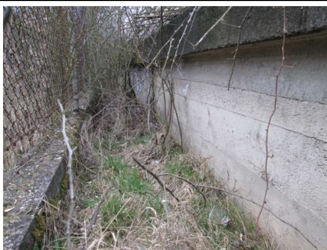
Pohled proti směru staničení. Ojedinělé výkvěty solí.
