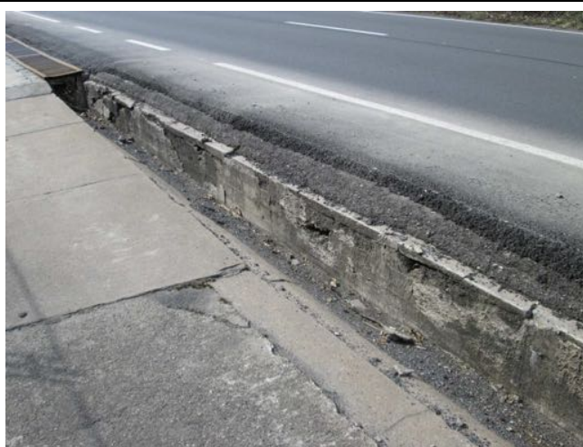
Výrazně převýšená vozovka. Masivní degradace betonu.
