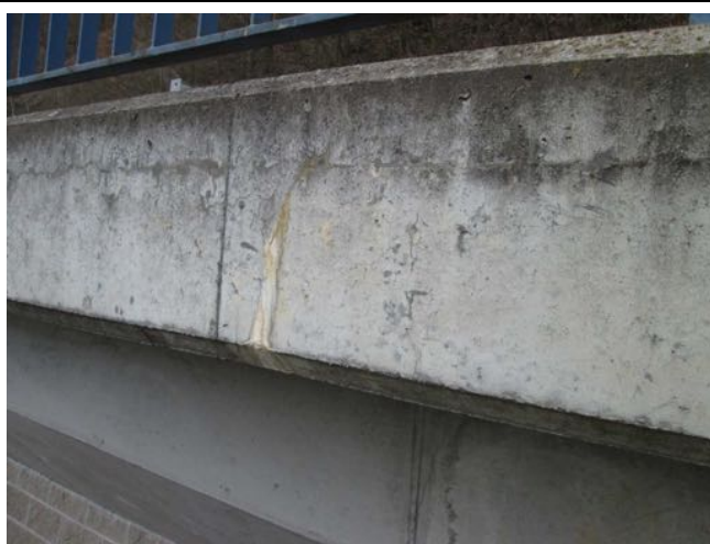
Bok římsy. Ojedinelé stopy průsaků trhlinami. Povrch znečištěn.
