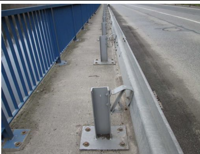
Svodidlo vlevo. Lokální deformace svodnice a distančních podložek.
