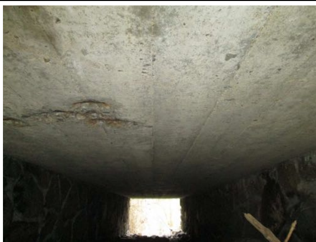
Podhled nosné konstrukce zprava. Ojediněle odpadlá krycí vrstva, koroze obnažené výztuže.
