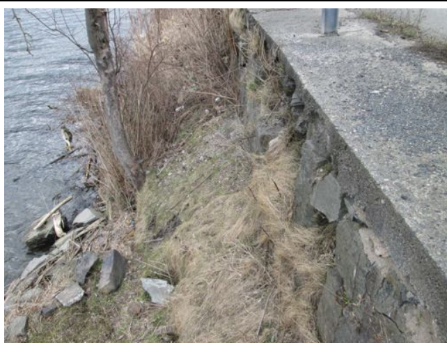
Masivně vydrolené spáry, zdivo rozvolněné.
