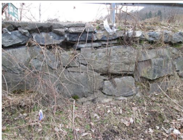
Masivně vydrolené spáry.
