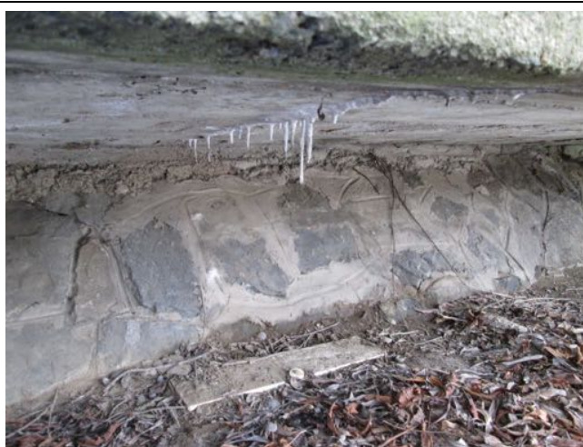
Konzola. Trhlina, silné průsaky, výluhy, krápníky.
