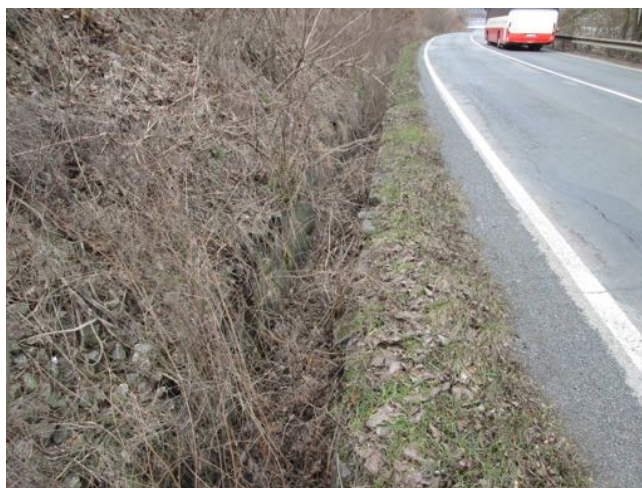
Částečně zanesený příkop.
