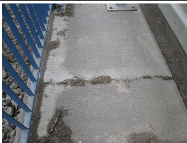
Poškozené těsnění dilatační nebo smršťovací spáry. Uchycená vegetace.
