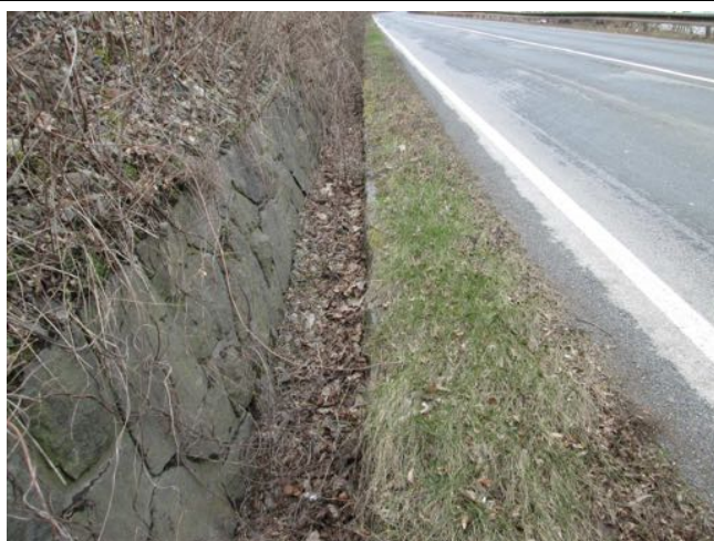
Příkop částečně zanesený.
