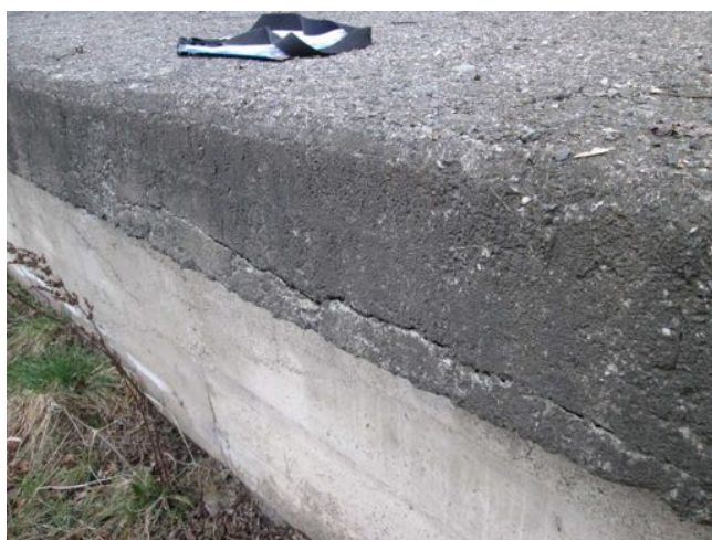
Separovaná krycí vrstva na ozubu římsy.
