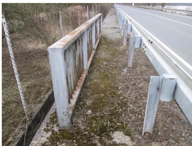
Nánosy, nečistoty na římse.
