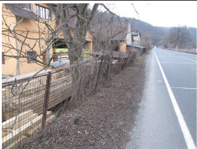
Zřícené oplocení upevněné do zdi.
