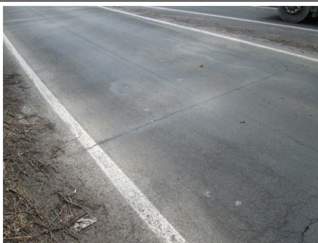
Dilatační spáry prokreslené do vozovky.
