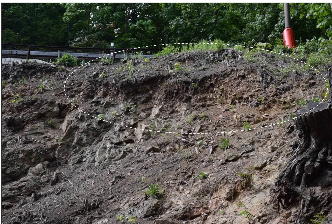
Foto 8 Částečně převíslá partie tvořená hlinitokamenitými zeminami, hrozící do budoucna pádem (zvýrazněno bílou elipsou ).
