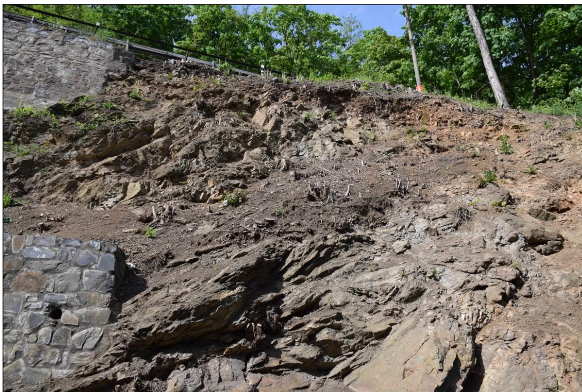
Foto 3 Silné rozpukání a rozvolnění horninového masivu v lici předmětného skalního svahu – celkový pohled.
