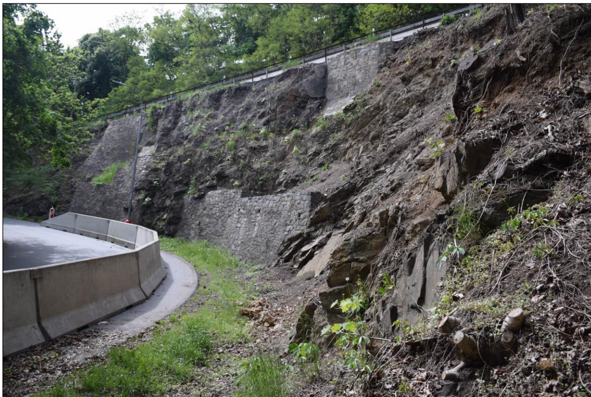
Foto 11 Značný akumulací prostor mezi patou skalního svahu a zábranou z betonových svodidel NEW JERSEY.
