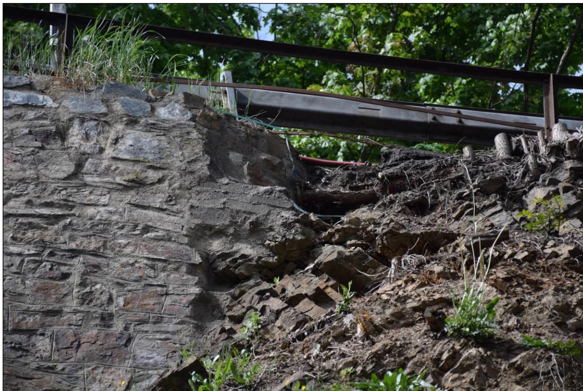
Foto 9 Erozí porušená horní hrana svahu na jeho kontaktu s opěrnou zdí.
