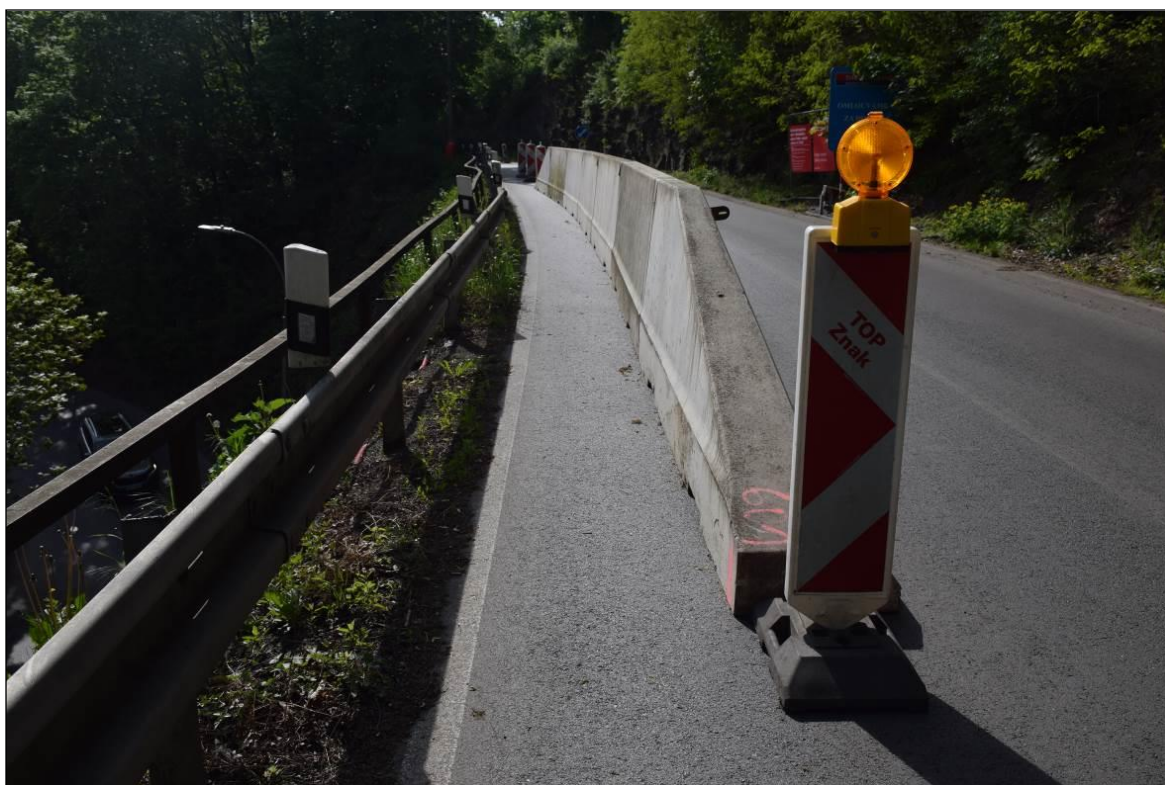
Foto 10 V asfaltovém krytu silnice nad horní hranou svahu nebyly v době rekognoskace ČGS patrné žádné trhliny, které by signalizovaly hlubší deformace skalního svahu.
