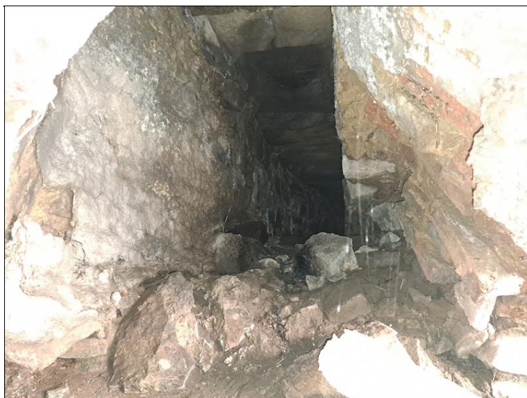
Vyústění kanalizace do mostního otvoru skrze OP1 vlevo.
