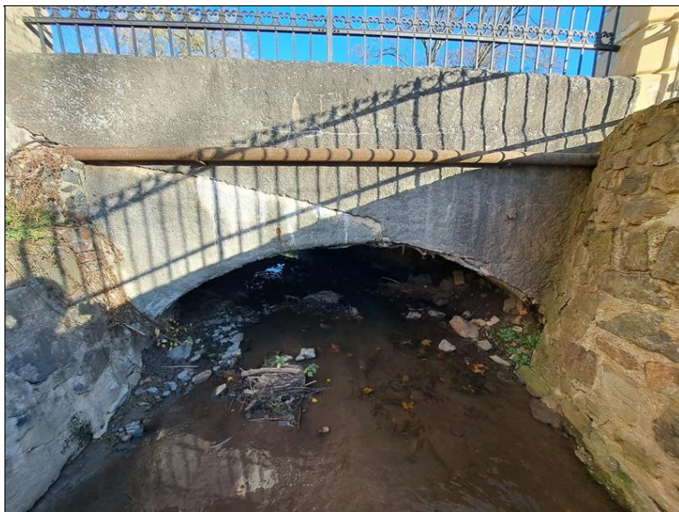
Pohled na levou stranu mostu.
