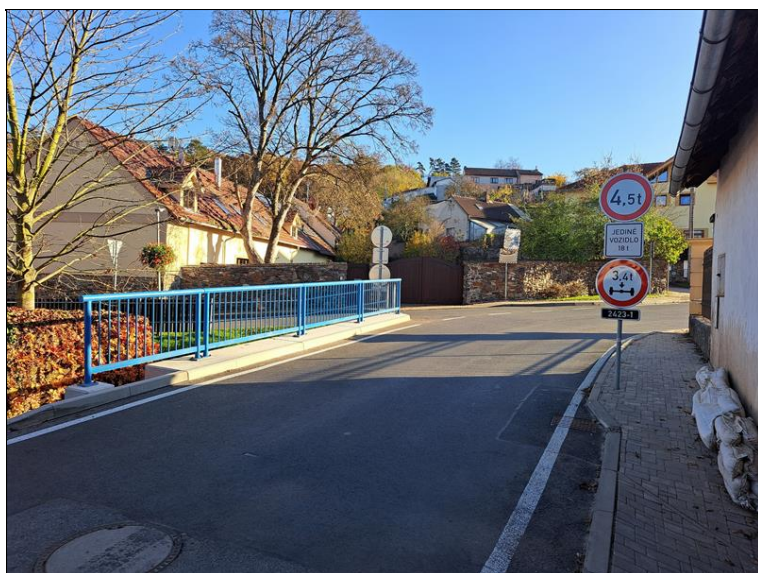
Pohled proti směru staničení.
