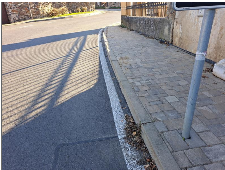
Krajnice a chodník na levé straně mostu.
