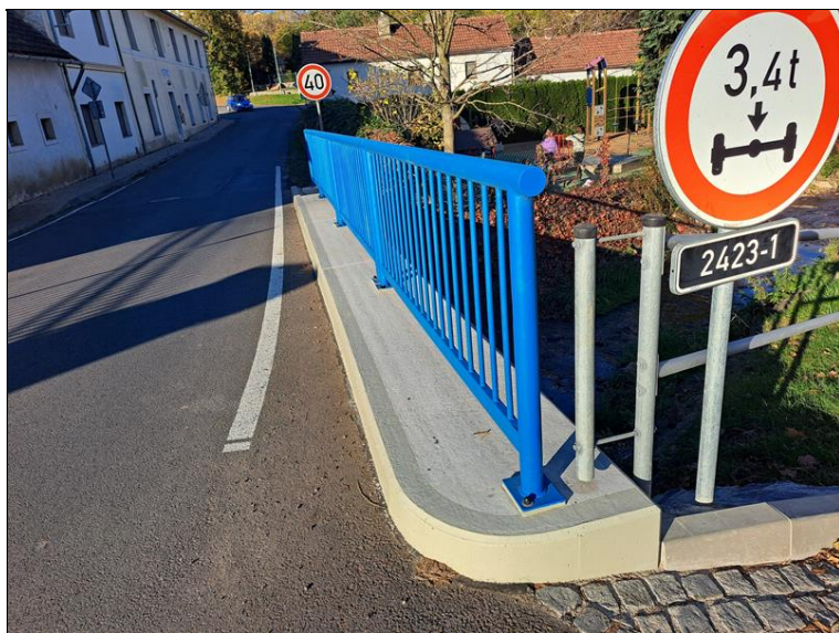
Pravá římsa na mostě.
