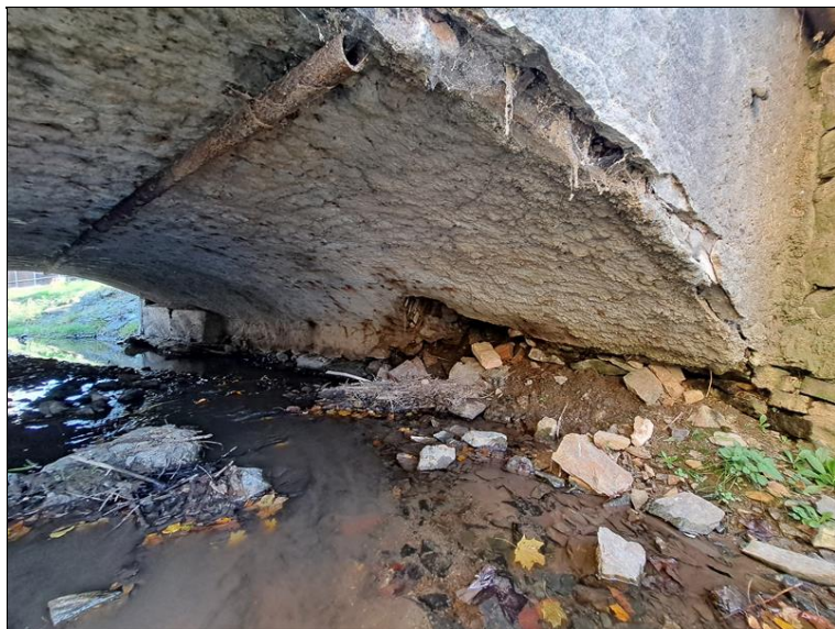
Pohled na OP1 z levé strany.
