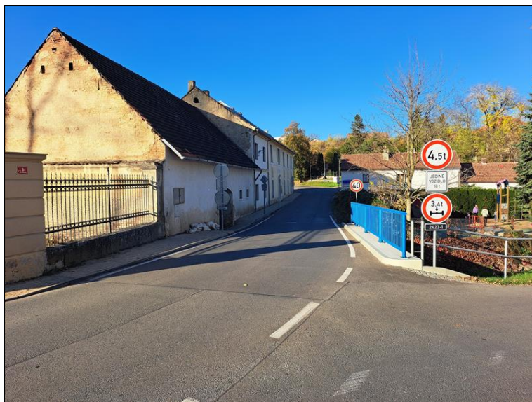
Pohled ve směru staničení.
