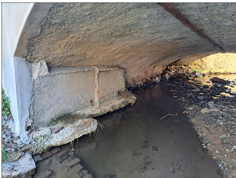
Pohled na OP1.
