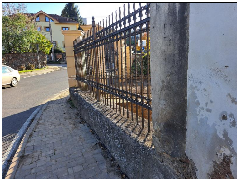
Plot na levé straně mostu.
