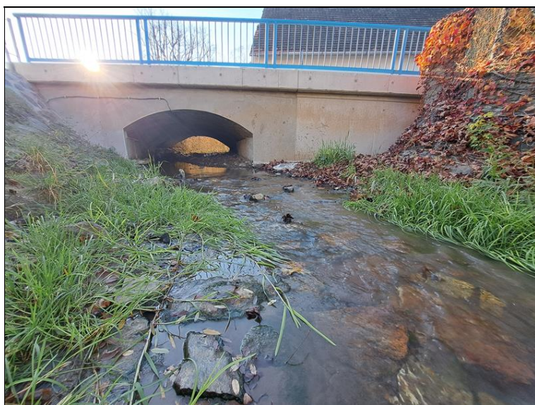
Pohled na pravou stranu mostu.
