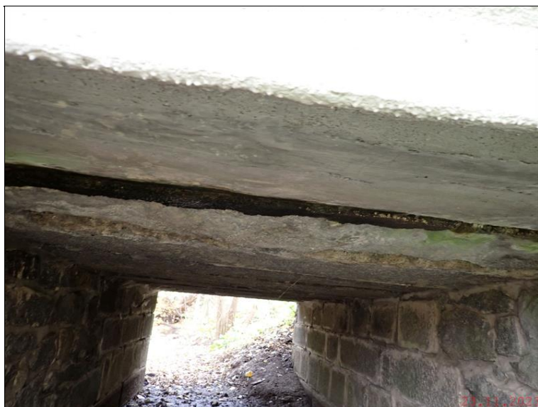
2.1 Nosná konstrukce v 1. poli.JPG
