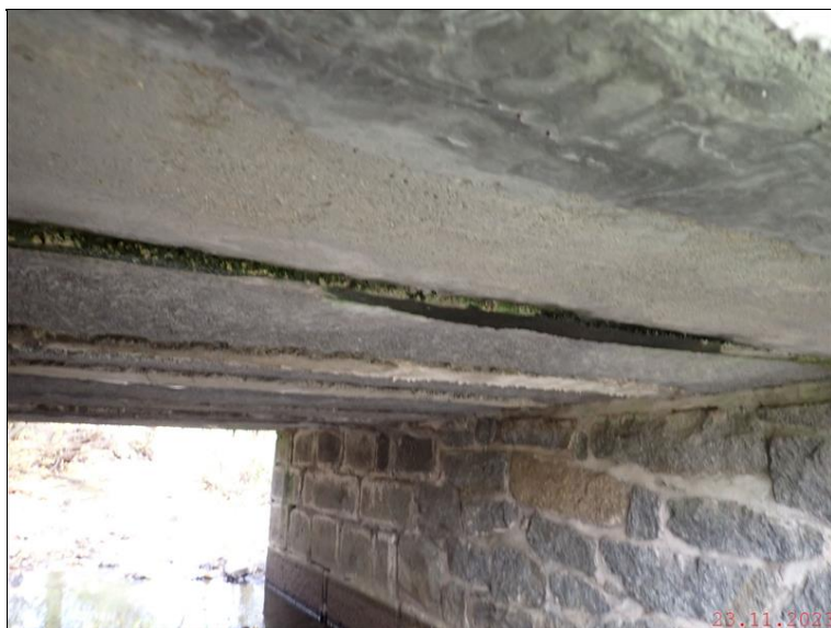
2.1 Nosná konstrukce ve 2. poli.JPG
