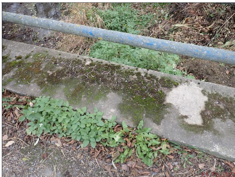
3.1 Vegetace v krajnici vlevo.JPG
