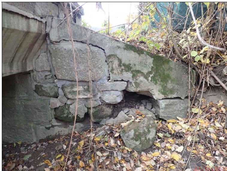
1.2 Opěra O4 vpravo - rozvolněné zdivo křídla.JPG
