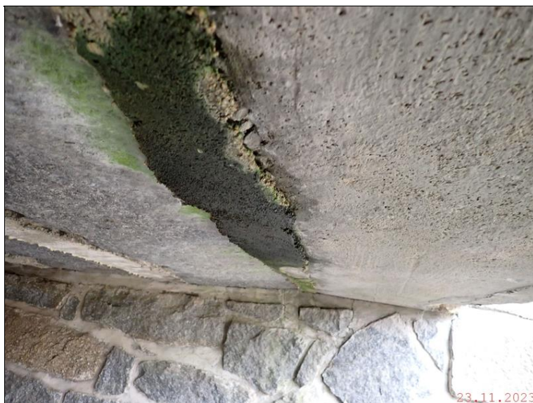
2.1 Nosná konstrukce ve 2. poli - řasy uchycené ve spárách.JPG
