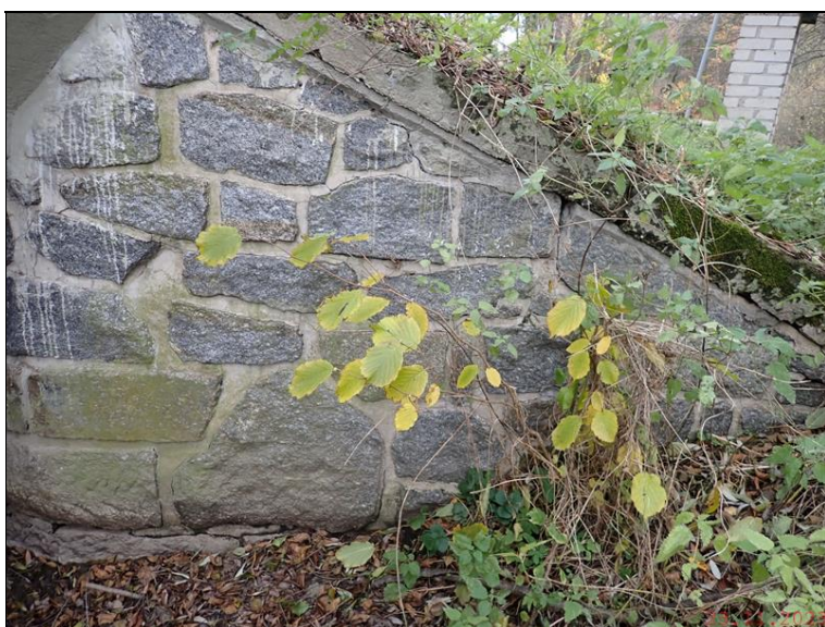
1.2 Opěra O1 vlevo.JPG
