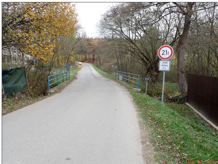
0.2 Pohled proti směru staničení.JPG
