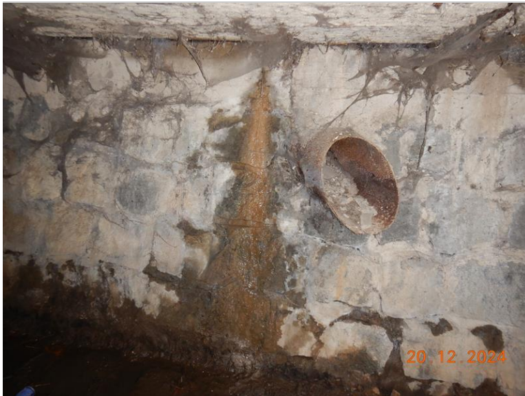
012_OP1, detail. Průsaky
