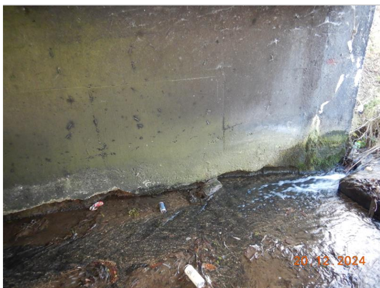
025_OP2 vpravo. Podzemní opěry v úrovni kolísání hladiny vody
