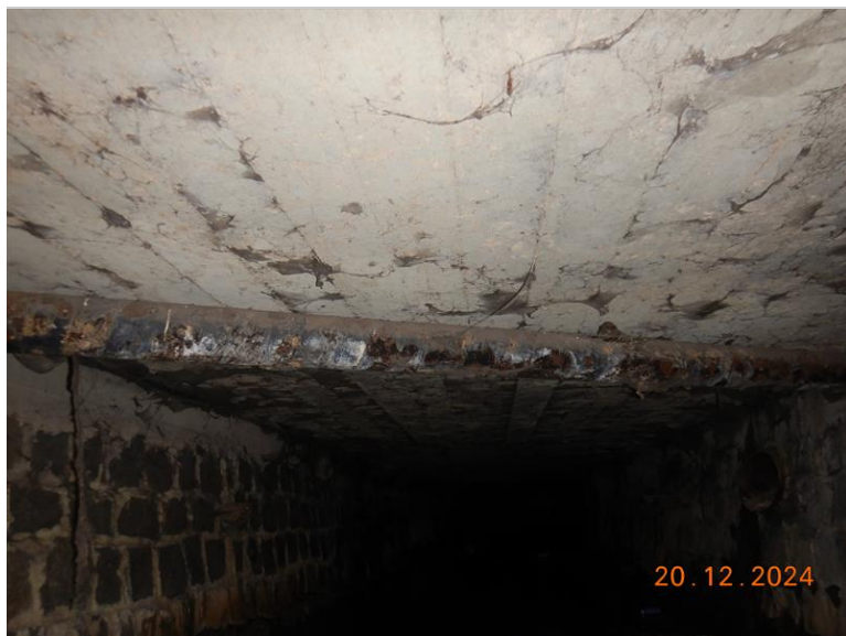
009_Podhled nosné konstrukce vlevo
