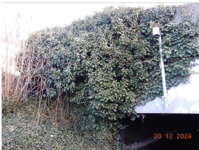
004_Pravé křídlo OP1
