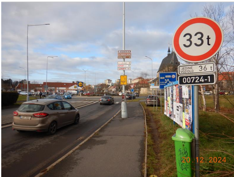
001_Šířkové uspořádání na mostě, pohled proti směru staničení
