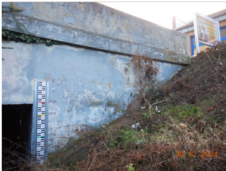
005_Pravé křídlo OP2
