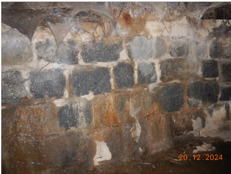
013_OP2, detail. Průsaky
