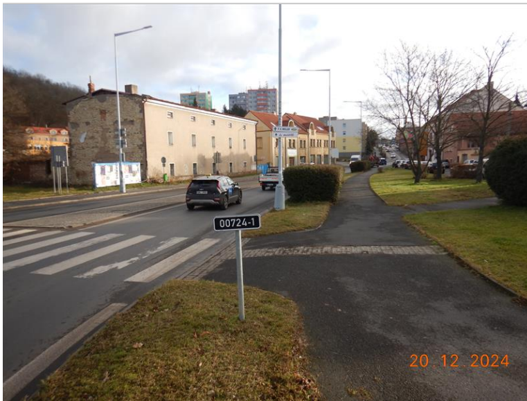
000_Šířkové uspořádání na mostě, pohled ve směru staničení
