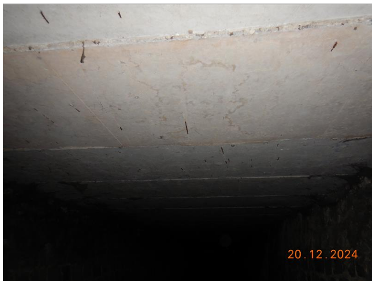
020_Podhled nosné konstrukce cca uprostřed
