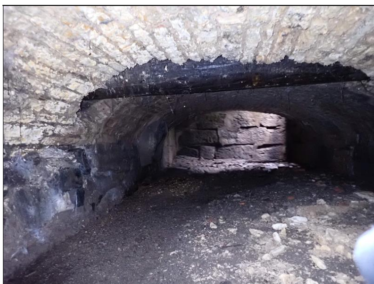
Kanalizace prochází klenbou - klenba lokálně demolována pro prostup kanalizace (cca pod levým chodníkem).
