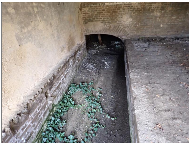
Pravé čelo objektu.
