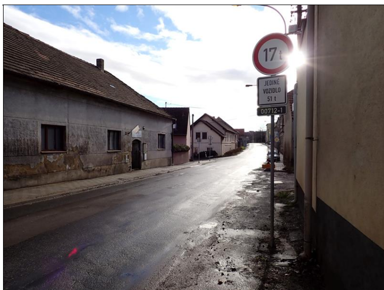
Pohled na most proti směru staničení.
