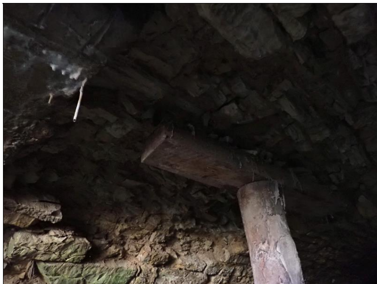
Rozpad klenby - prostor stále pod objektem rodinného domu.
