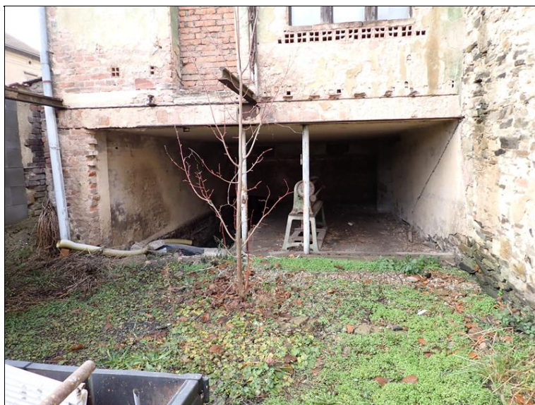
Pohled na přístup k mostu zprava ze dvora objektu.
