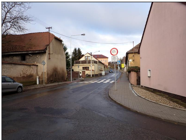
Pohled na most po směru staničení.
