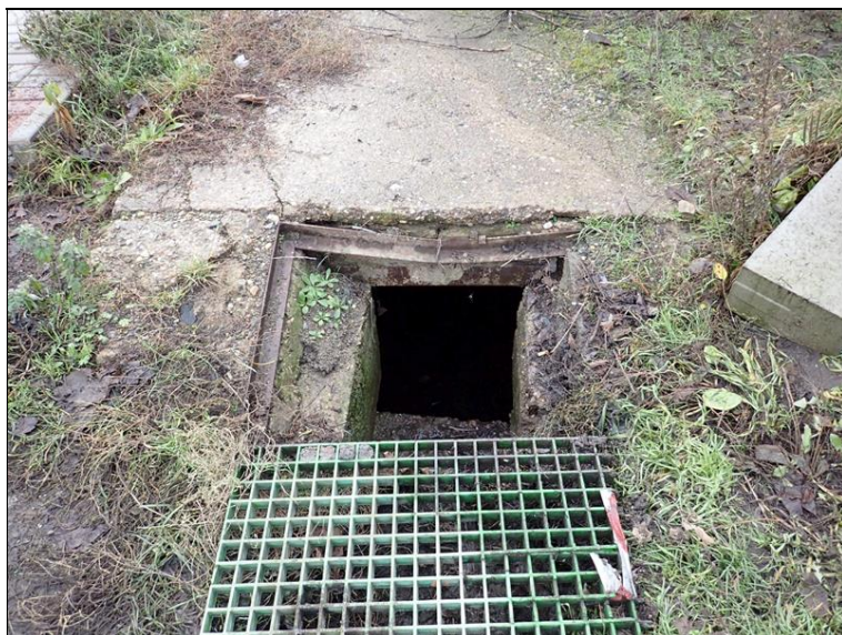
Kontrolní šachta vlevo, pod betonovou deskou je šachta.
