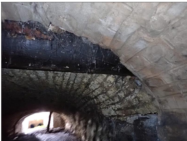
Prostup kanalizace klenbou.
