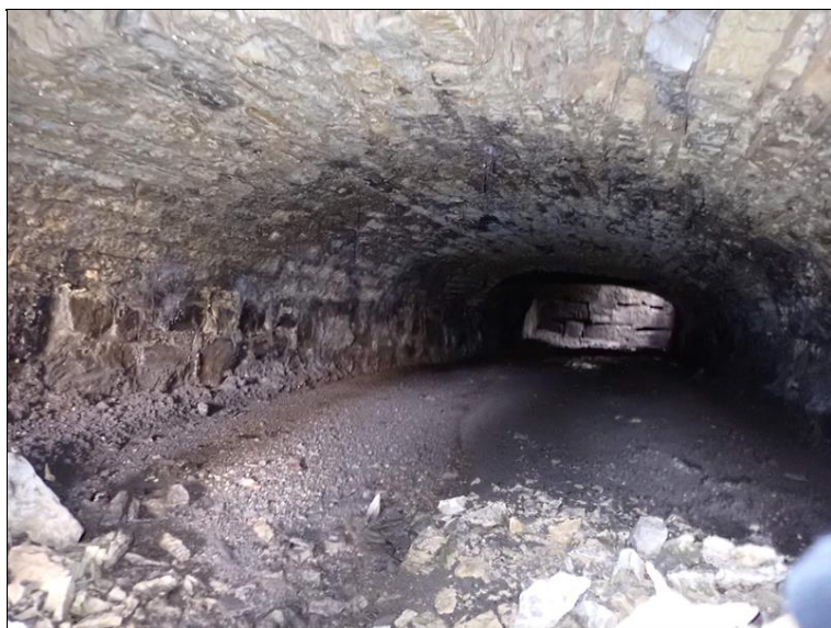
Stav mostu pod vozovkou.
