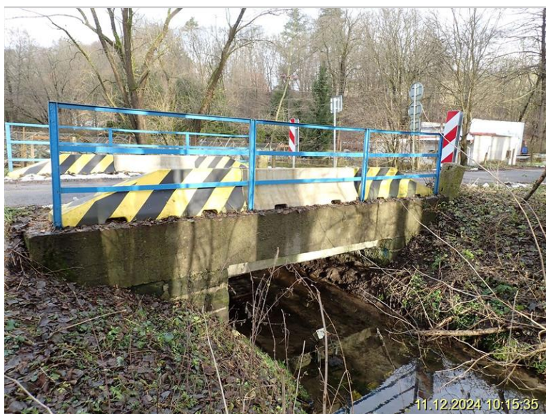
14 - pohled na most zprava.JPG
