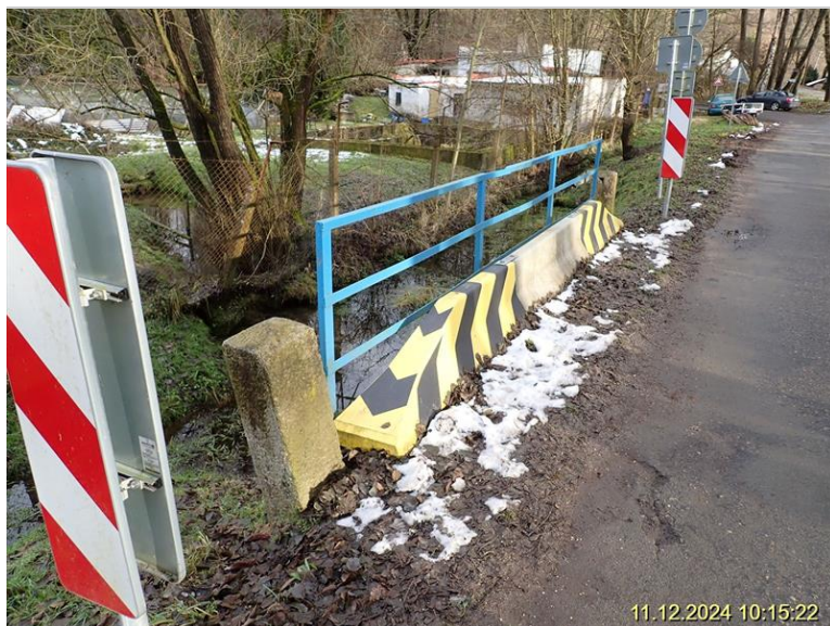
13 - levý okraj mostu.JPG
