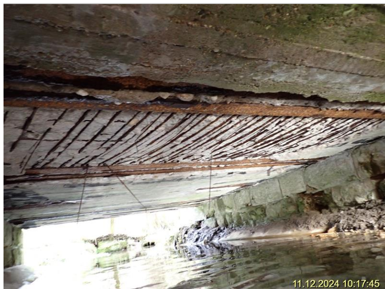
28 - podhled NK střed.JPG
