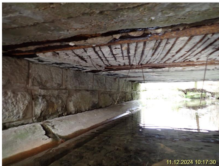
27 - podhled NK střed.JPG
