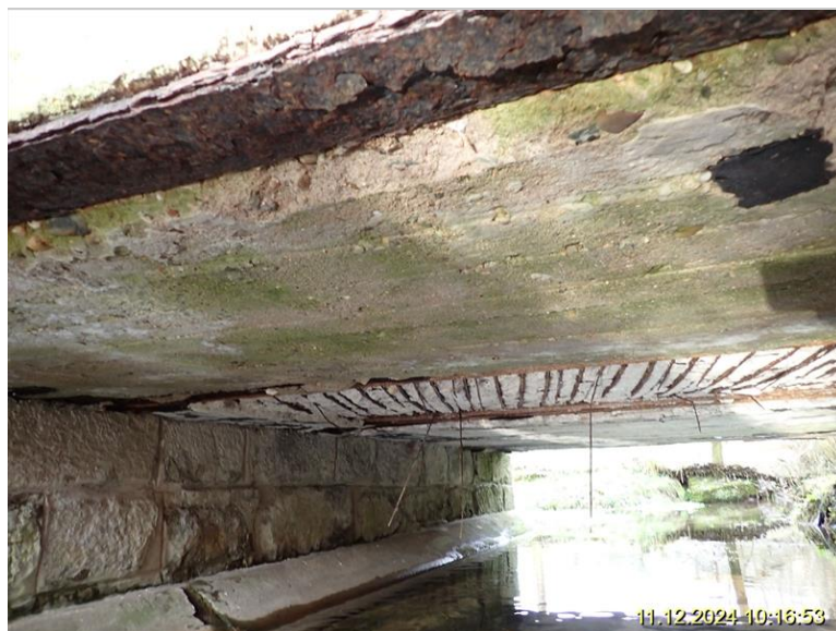
21 - pohled Nk zprava.JPG
