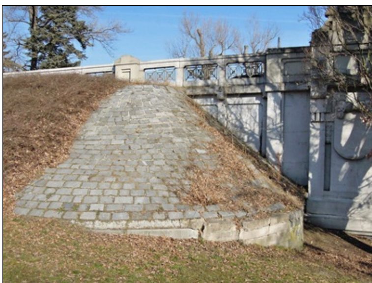
v patě deformované zdivo opevnění kužele vpravo u OP1
