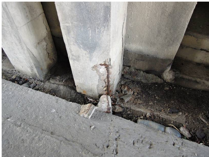
BV – sloup mostovky - porucha v patě sloupu u dilatační spáry u podpěry
