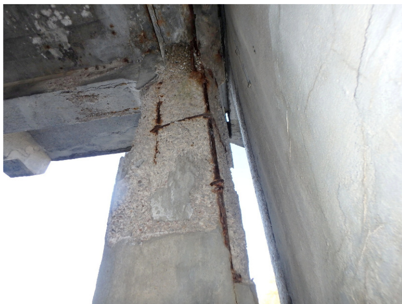
BV – sloup mostovky - výrazná porucha u dilatační spáry
