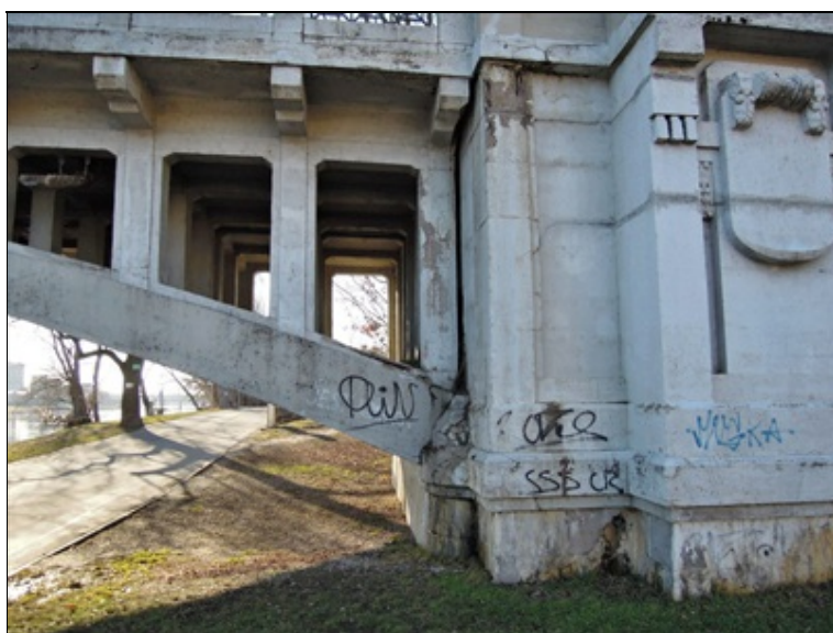
OP1 levý bok - poruchy konstrukcí v místě zatékání dilatační spárou
