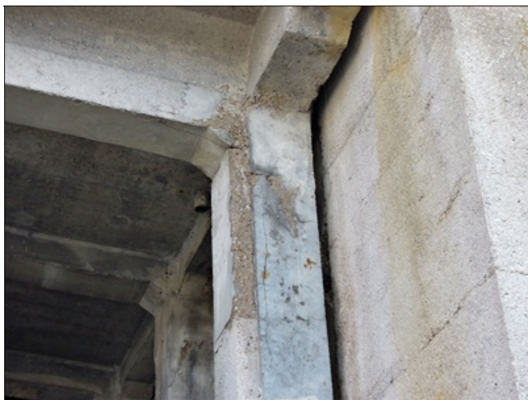
degradace betonu mostovkové části v místě zatékání dilatační sparou (opakující se závada)
