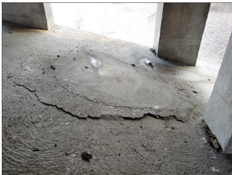
porucha na horním líci oblouku v místě zatékání (obvykle pod nefunkčním odvodňovačem) - odtržená krycí vrstva v místě koroze výztuže (opakující se závada)
