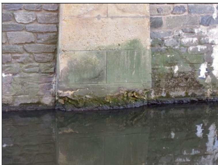
dtto - detail degradace zdi a pilířku v úrovni kolísání hladiny
