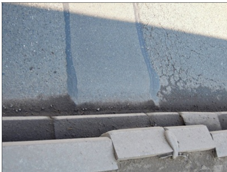
porucha chodníku u dilatačního závěru, trhliny ve vozovce u závěru (opakující se závada)
