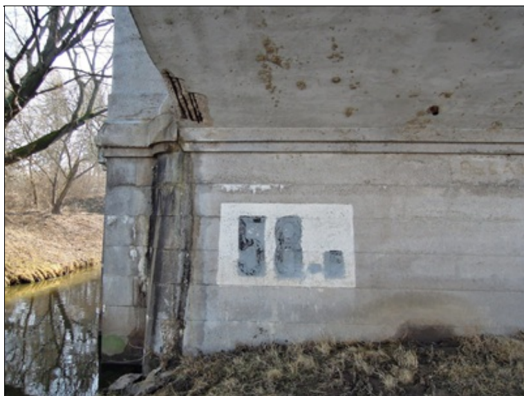
OP4 - průsaky, obnažená korodující výztuž oblouku
