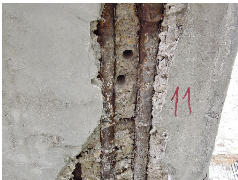
BV – oblouk - porucha na spodním líci oblouku u opěry
