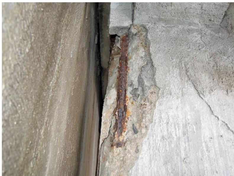
BV – sloup mostovky - obdobná porucha
