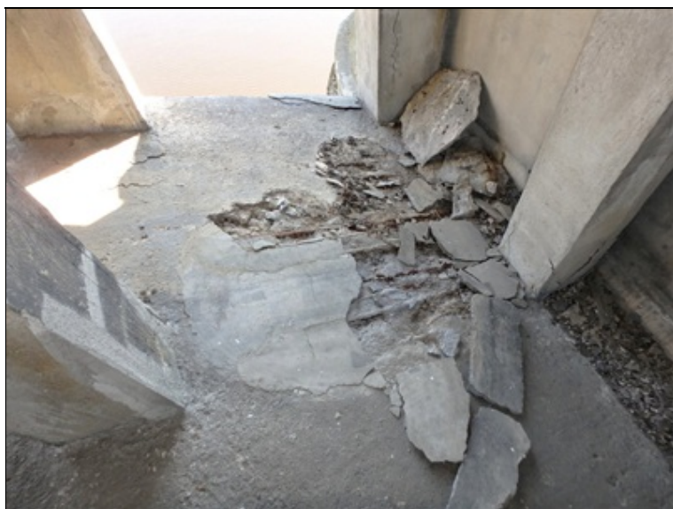
obdobná porucha po odstranění odfouké krycí vrstvy - zde v minulosti sanováno
