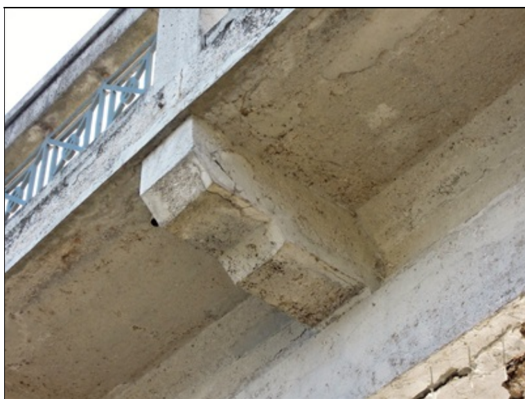
obnovená porucha sanované hrany chodníkového krakorce (opakující se závada)
