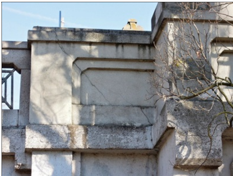
šikmá trhlina ve stěnovém zábradlí u podpěry (opakující se závada)
