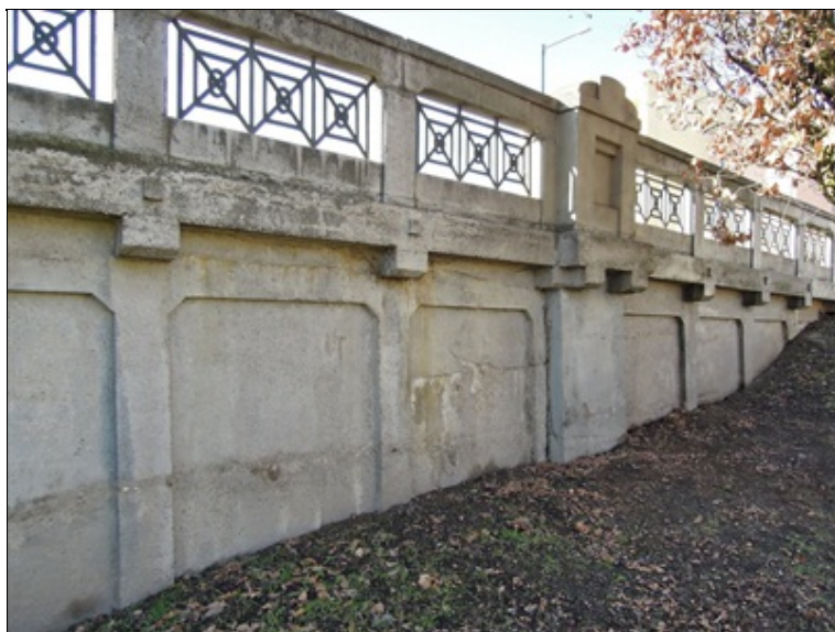
trhliny s výluhy na levé zdi před OP1
