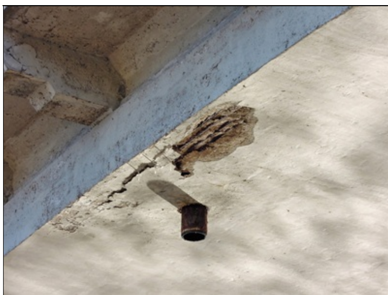
lokální porucha na spodním líci oblouku u odvodňovače - odtržená či odpadlá krycí vrstva, koroze výztuže (opakující se závada)
