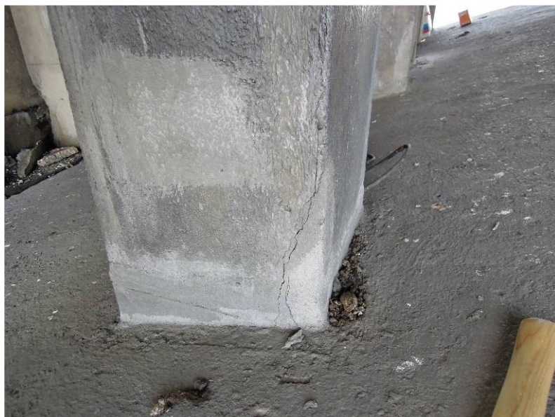
BV – sloup mostovky - obdobná porucha menšího rozsahu v poli
