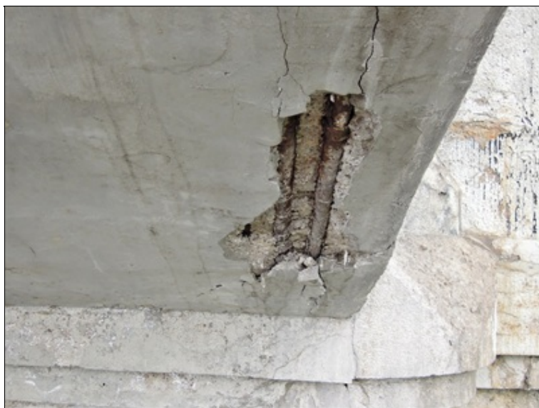
lokální porucha krycí vrstvy a obnažená korodující výztuž na spodním líci oblouku u OP1
