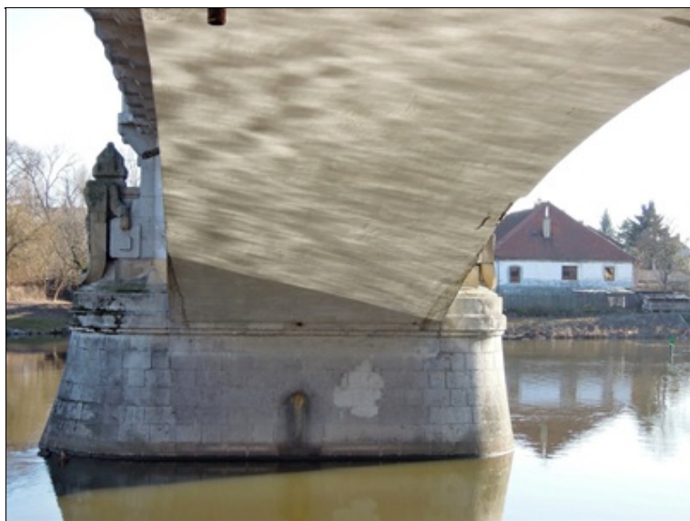
P2 z 1.pole - průsak v dříku pilíře
