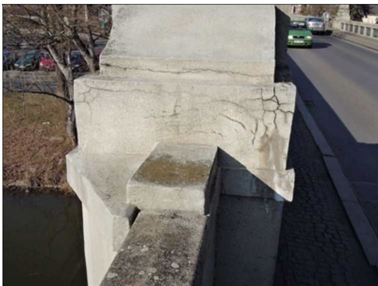
trhlinami porušená zídka u pilíře (opakující se závada)
