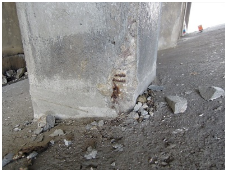
lokální porucha sloupku v hraně (opakující se závada)
