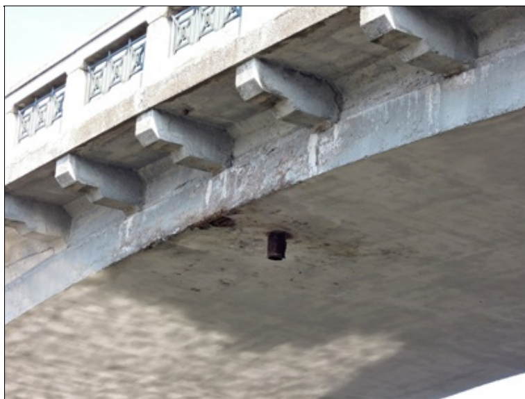
průsaky ve vrcholové části oblouku kolem odvodnění (opakující se závada)
