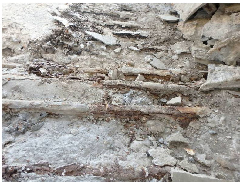
BV – oblouk - dtto – detail silně korodující výztuže
