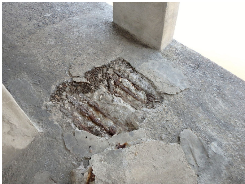
BV – oblouk - porucha na horním líci v místě odvodňovače s chrličem
