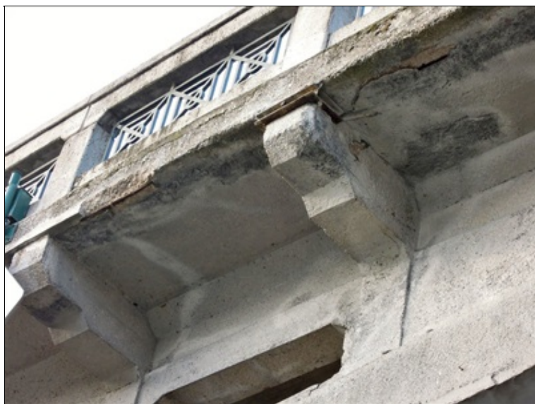
lokální porucha na chodníkové konzole - degradace betonu, koroze obnažené výztuže (opakující se závada)
