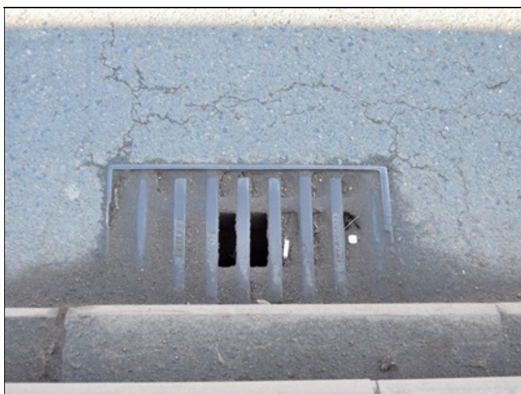
částečně zanesený odvodňovač, trhliny ve vozovce (opakující se závada)
