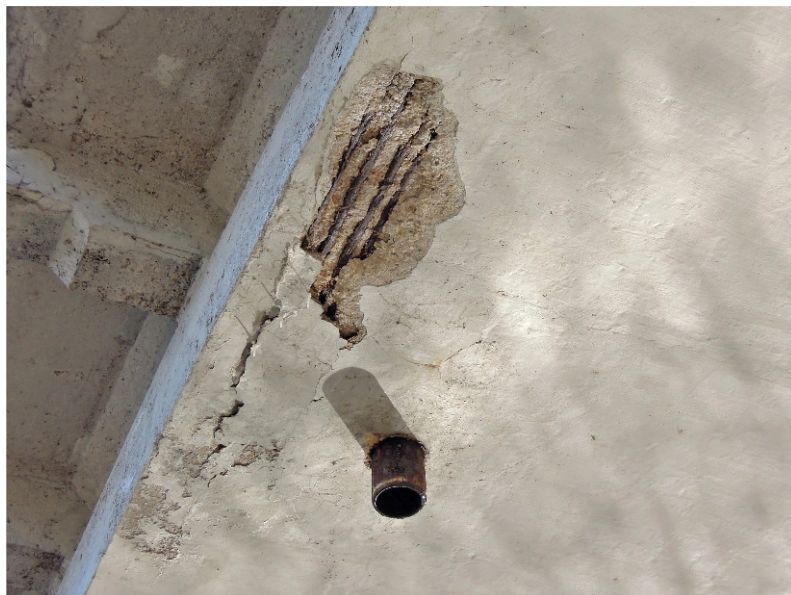
BV – oblouk - porucha v místě odvodňovače ve vrcholu
