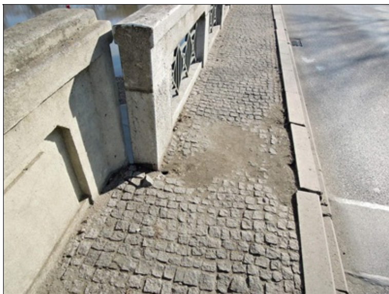
porucha dlažby chodníku v místě dilatační spáry (opakující se závada)
