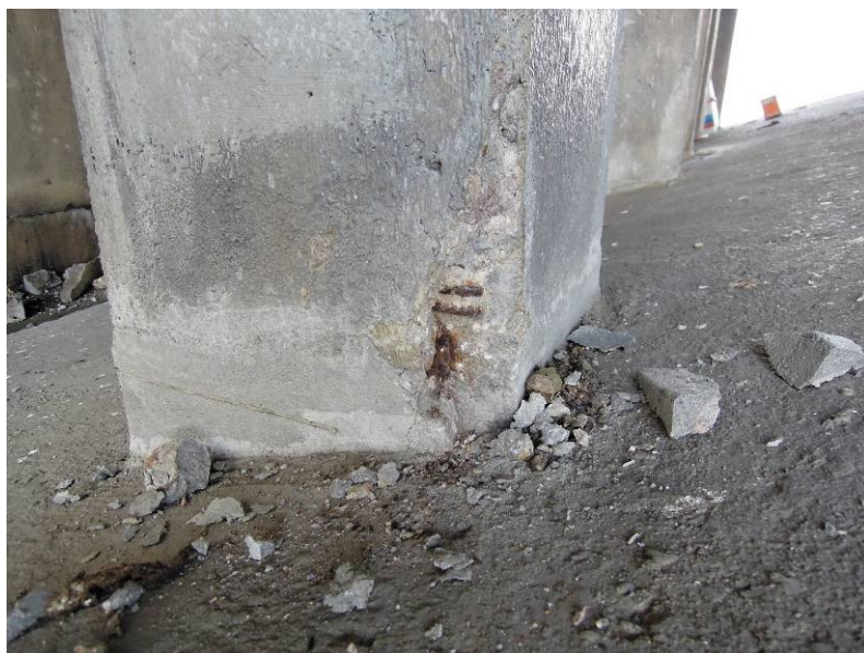
BV – sloup mostovky - dtto po odstranění separované hrany
