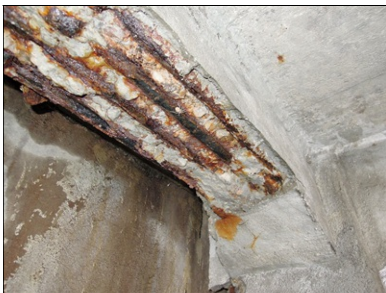
výrazná porucha příčnicku v 1.řadě u dilatační spáry - silně korodující obnažená výztuž (typická závada konstrukcí mostovkové části u dilatačních spar)
