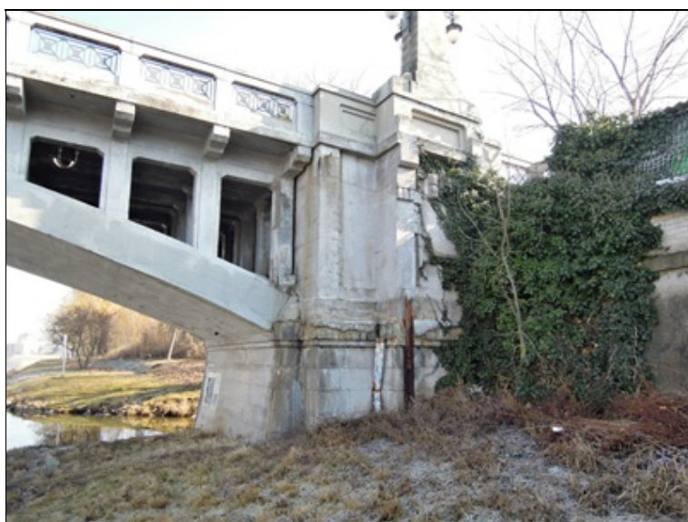
OP4 pravá strana - výrazná degradace bočního soklu v úrovni vetkuntí oblouku
