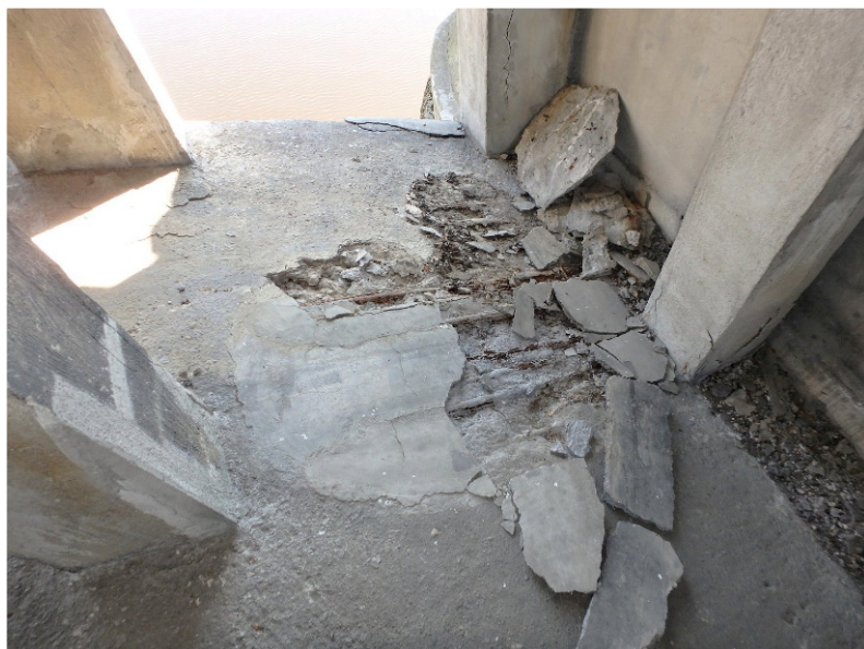
BV – oblouk - porucha na horním líci u podpěry
