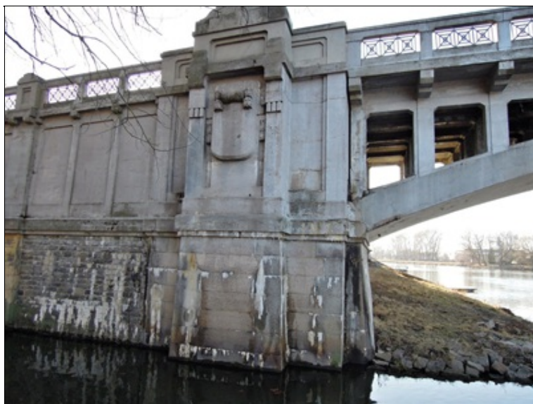
OP4 - silné výluhy na boku opěry i navazující zdi
