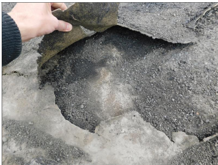
Porušená hydroizolace ve vozovce nad pilířem P2, odhalený horní líc nosné konstrukce.
