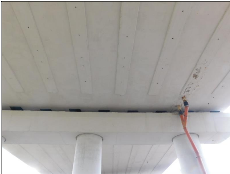
Spodní líc nosné konstrukce pod poškozeným místem nad pilířem P2 - bez stop po průsacích.
