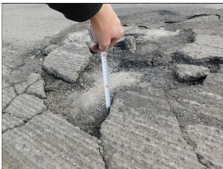
Detail poruchy ve vozovce nad pilířem P2.
