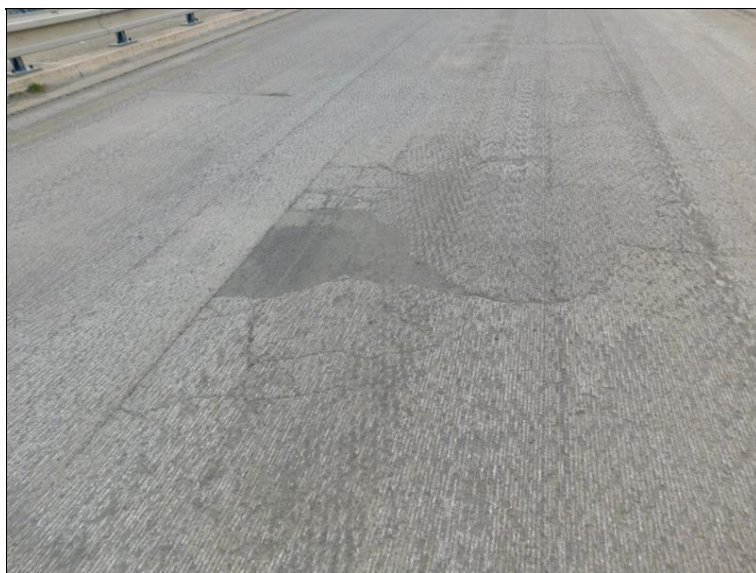
Charakterem podobná porucha vozovky nad pilířem P3 prozatím v menším rozsahu než u pilíře P2.
