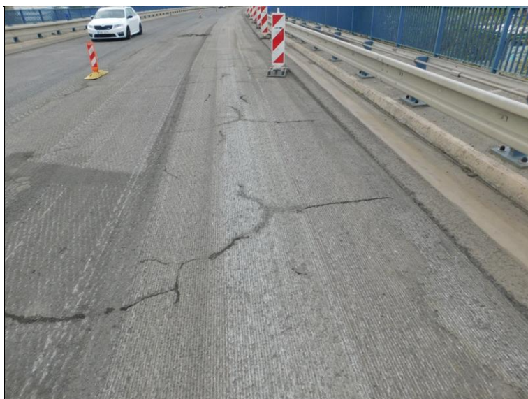
Trhliny ve vrstvě litého asfaltu v poli 1 v pravé polovině vozovky, v trhlínách vlhkost.
