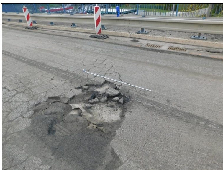
Celkový pohled na poruchu vozovky na pilířem P2 v pravé polovině vozovky - kerný rozpad ochrany izolace z litého asfaltu, porušená hydroizolace.
