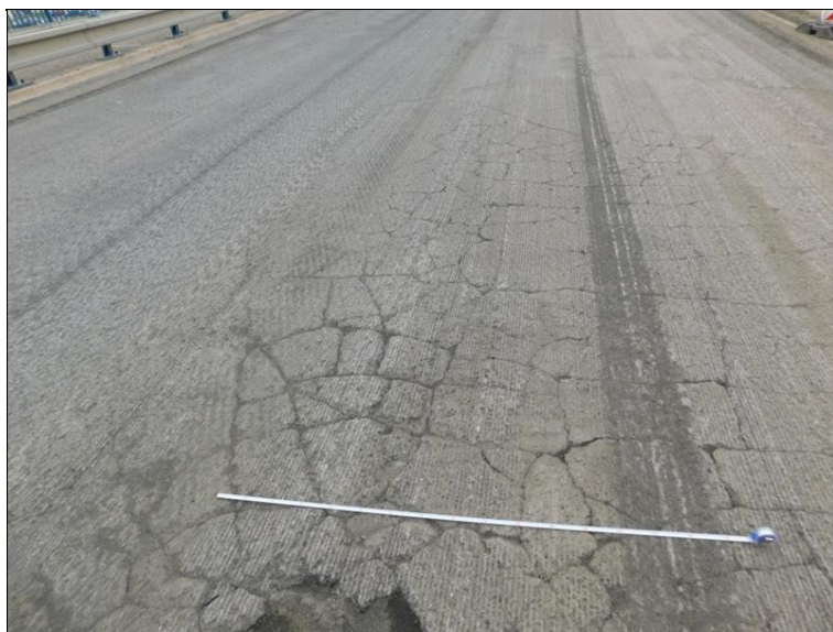
Kerný rozpad ochrany izolace z litého asfaltu v poli 2 navazující na poruchu nad pilířem P2.
