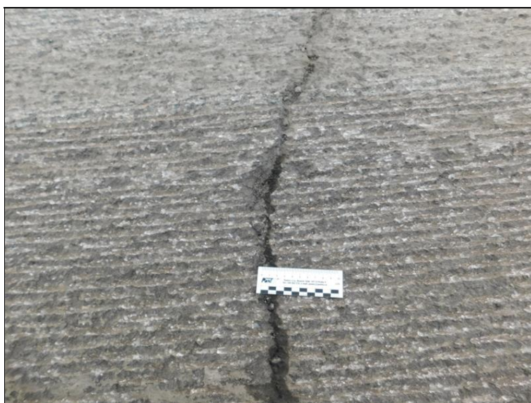
Trhliny ve vrstvě litého asfaltu v poli 1 v pravé polovině vozovky, v trhlínách vlhkost, detail.
