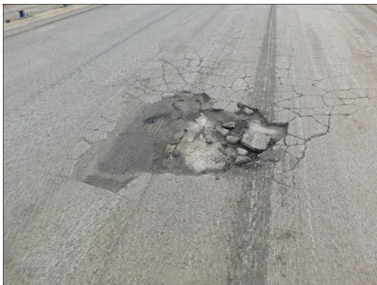
Celkový pohled na poruchu vozovky na pilířem P2 v pravé polovině vozovky - kerný rozpad ochrany izolace z litého asfaltu, porušená hydroizolace.
