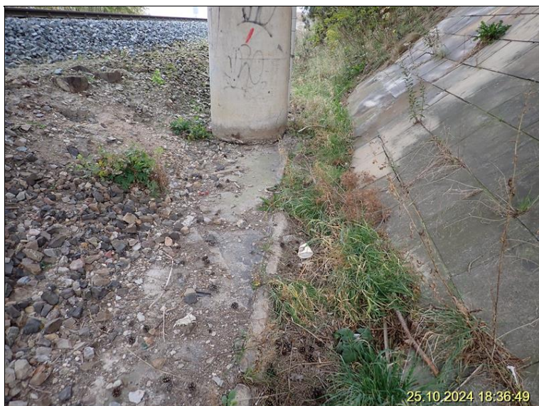
4.6 Zanesený příkop podél trati u pilířů P3.JPG
