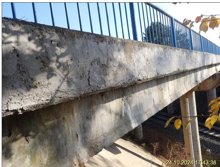
3.3 Římsa pravá - separovaná sanace.JPG
