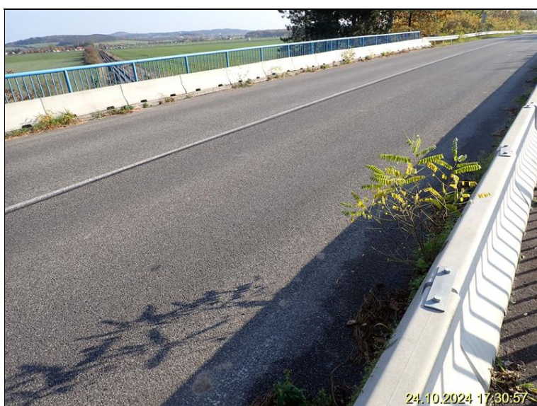
3.1 Vozovka na mostě.JPG
