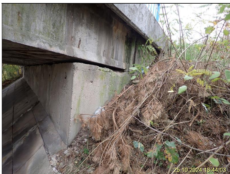
1.2 Opěra O4 - křídlo pravé.JPG
