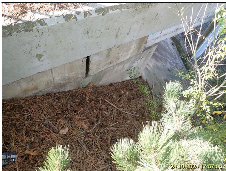
1.2 Opěra O4 - křídlo levé.JPG
