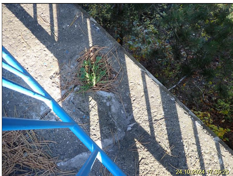
3.3 Vegetace uchycená v příčných spárách říms.JPG
