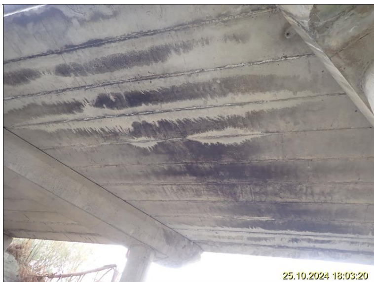
2.1 NK ve 2. poli - černé zbarvení podhledu od kouřových plynů.JPG
