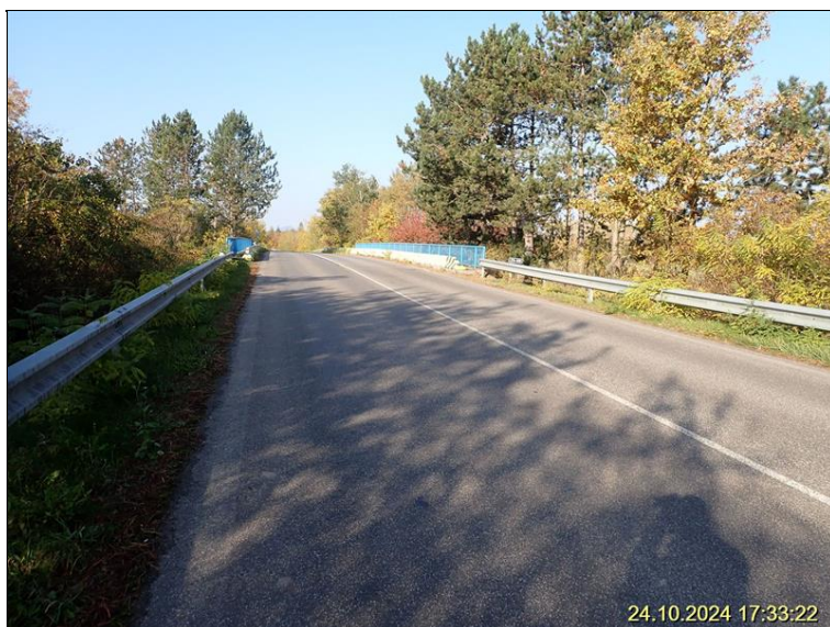
0.2 Pohled proti směru staničení.JPG
