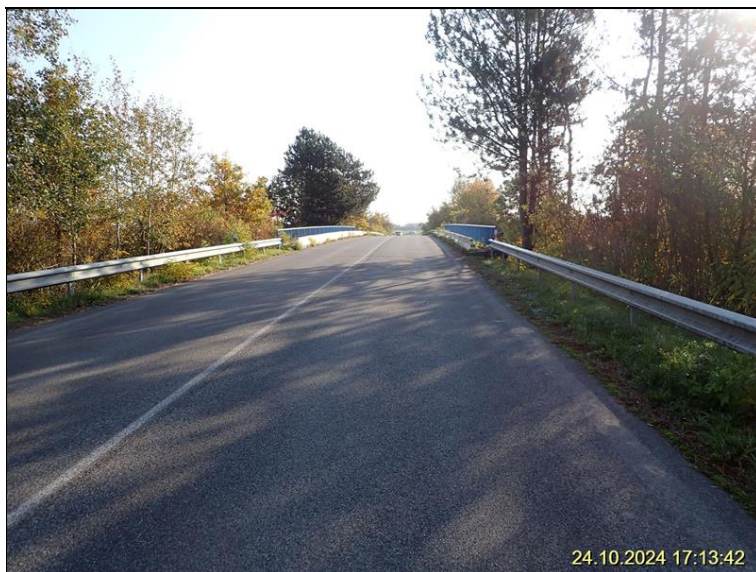
0.1 Pohled ve směru staničení.JPG
