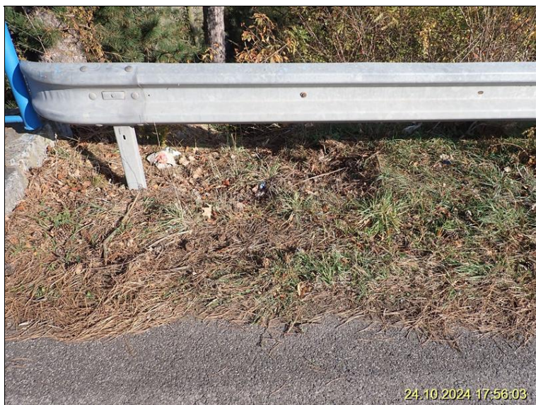
4.8 Zanesené nátoky do skluzů.JPG
