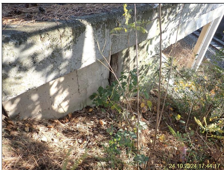
1.2 Opěra O1 - křídlo pravé.JPG
