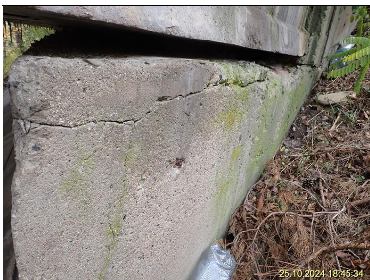
1.2 Opěra O4 vpravo - separovaná horní část úložného prahu na kraji.JPG
