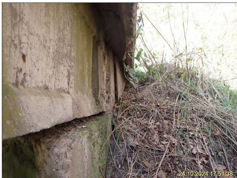
1.2 Opěra O1 - křídlo levé.JPG
