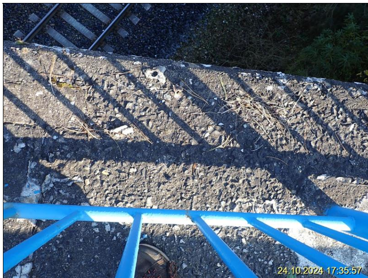
3.3 Degradace povrchu říms.JPG
