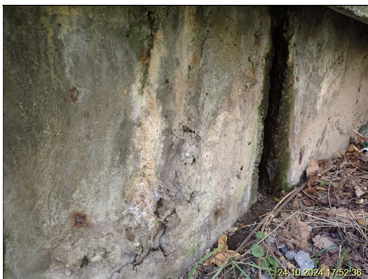
2.1 NK nad O1 vlevo - výluhy pojiva pod římsou.JPG
