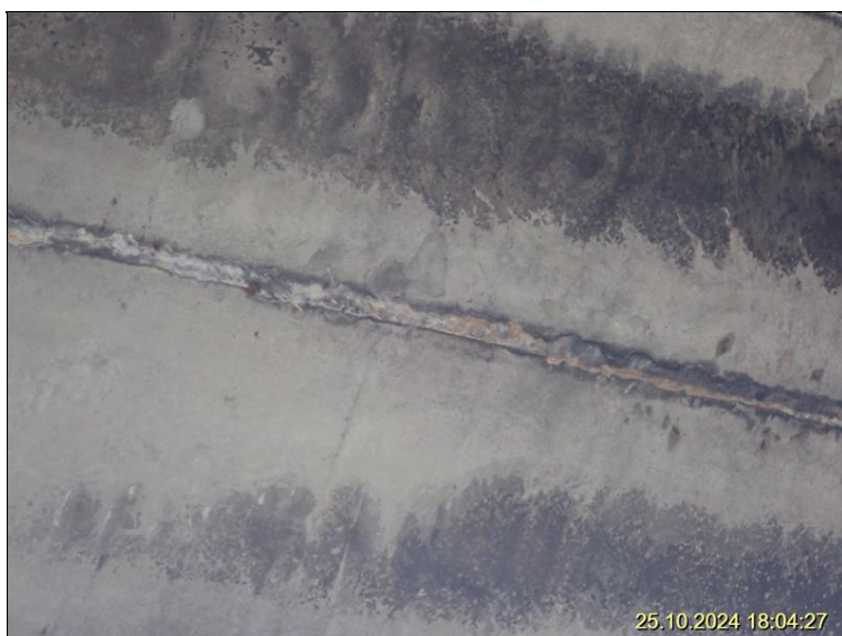
2.1 NK ve 2. poli - lokálně ve spáře mezi nosníky krápníky a výluhy koroze.JPG
