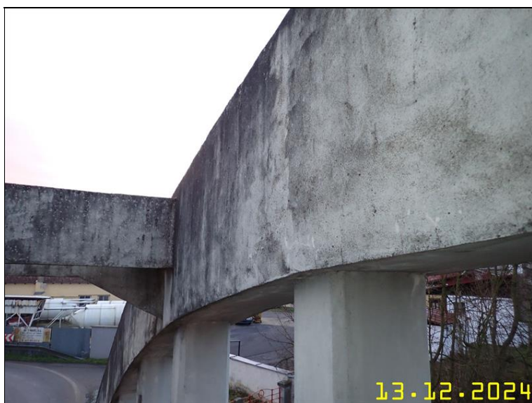
165 NOSNÁ KONSTRUKCE Z PLOŠINY.JPG
