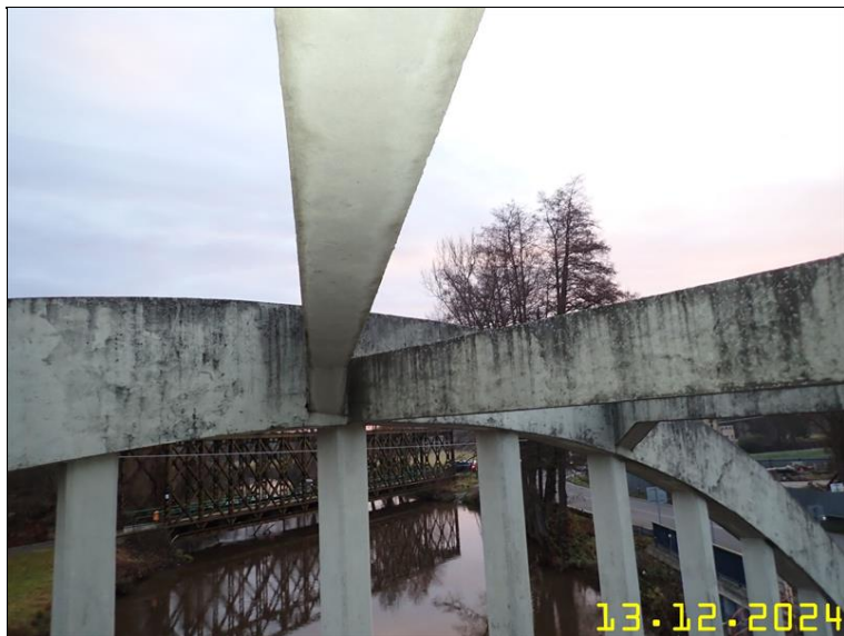
166 NOSNÁ KONSTRUKCE Z PLOŠINY.JPG
