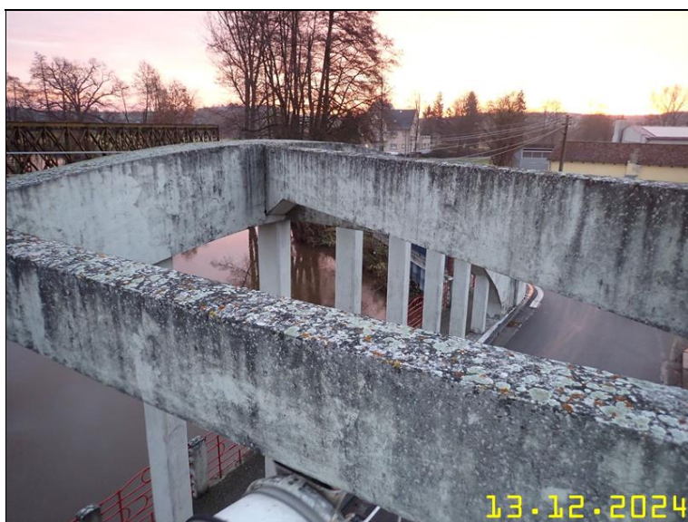
132 NOSNÁ KONSTRUKCE Z PLOŠINY.JPG
