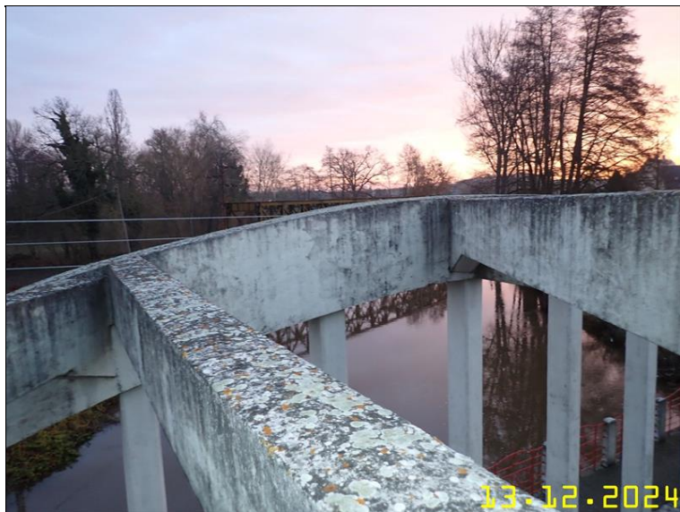
145 NOSNÁ KONSTRUKCE Z PLOŠINY.JPG
