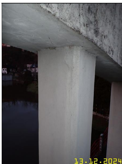
150 NOSNÁ KONSTRUKCE Z PLOŠINY.JPG
