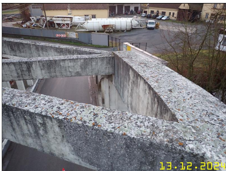
141 NOSNÁ KONSTRUKCE Z PLOŠINY.JPG
