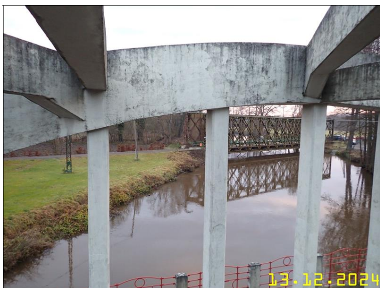
170 NOSNÁ KONSTRUKCE Z PLOŠINY.JPG
