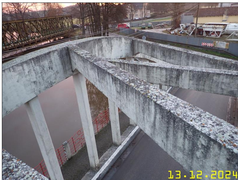
142 NOSNÁ KONSTRUKCE Z PLOŠINY.JPG
