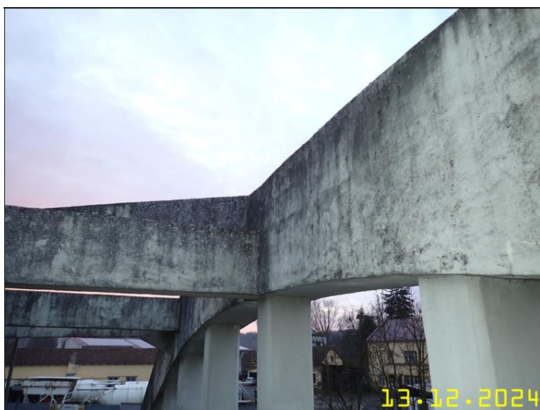
120 NOSNÁ KONSTRUKCE Z PLOŠINY.JPG
