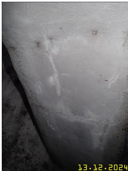
121 NOSNÁ KONSTRUKCE Z PLOŠINY.JPG
