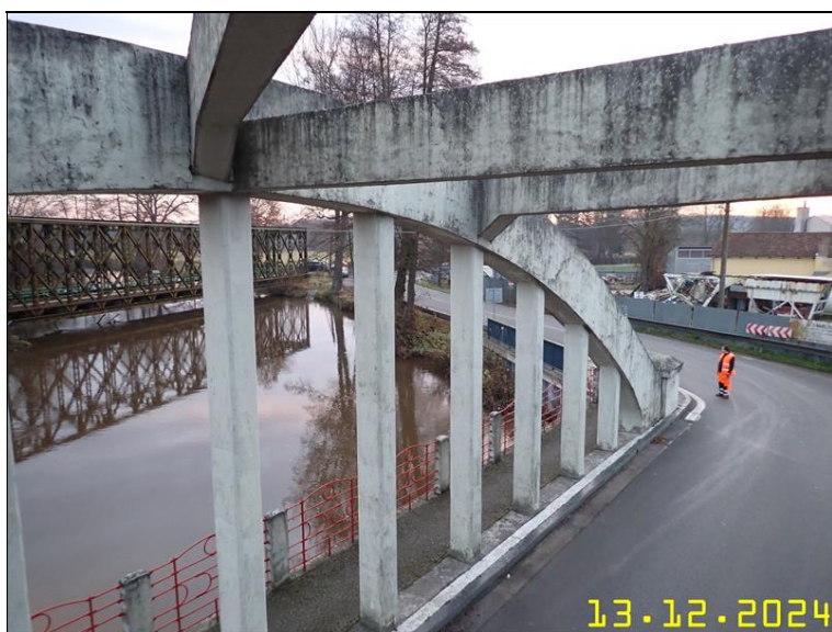
171 NOSNÁ KONSTRUKCE Z PLOŠINY.JPG
