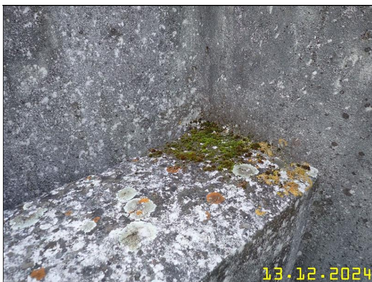
144 NOSNÁ KONSTRUKCE Z PLOŠINY.JPG
