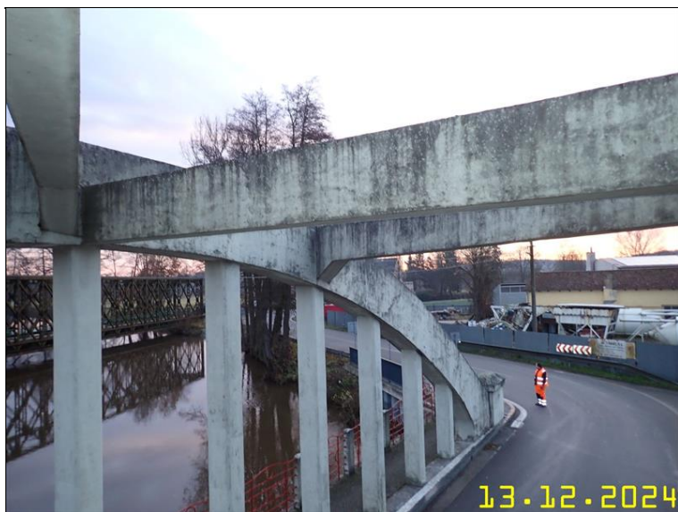
167 NOSNÁ KONSTRUKCE Z PLOŠINY.JPG
