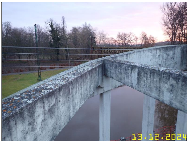
125 NOSNÁ KONSTRUKCE Z PLOŠINY.JPG
