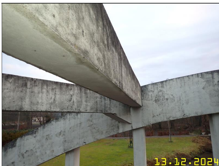
168 NOSNÁ KONSTRUKCE Z PLOŠINY.JPG
