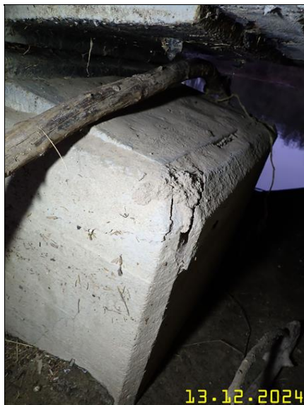
082 NEČISTOTY NA ULOŽENÍ O1.JPG
