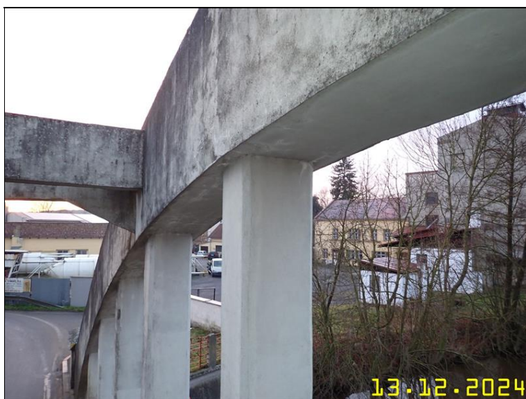
156 NOSNÁ KONSTRUKCE Z PLOŠINY.JPG
