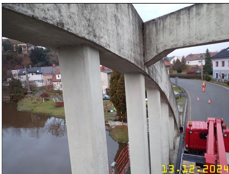
174 NOSNÁ KONSTRUKCE Z PLOŠINY.JPG
