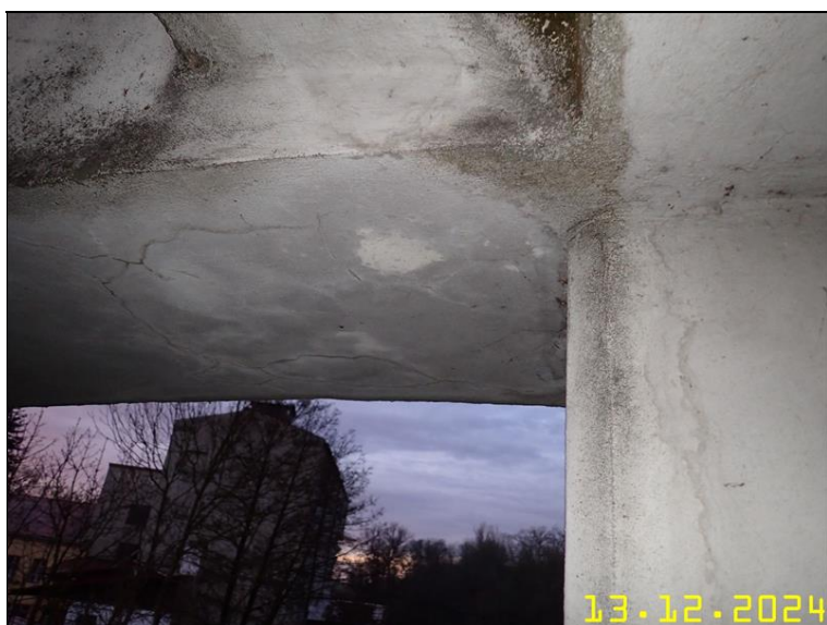
159 NOSNÁ KONSTRUKCE Z PLOŠINY.JPG
