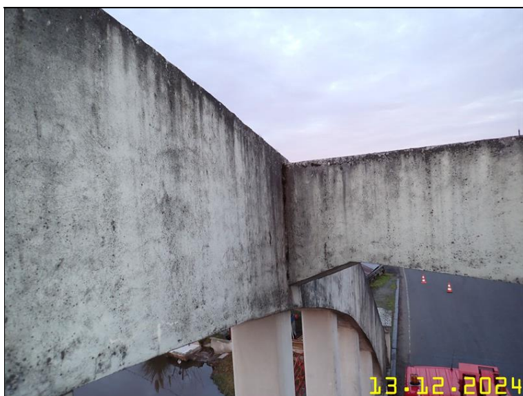
147 NOSNÁ KONSTRUKCE Z PLOŠINY.JPG
