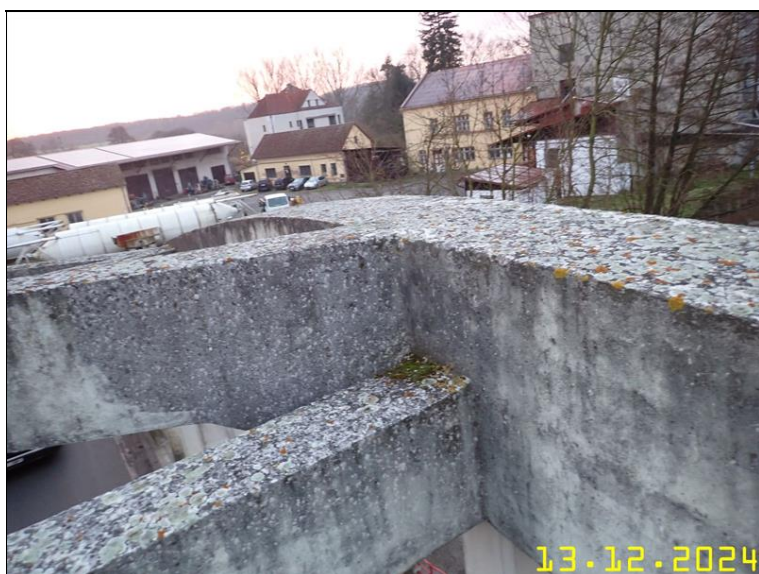
129 NOSNÁ KONSTRUKCE Z PLOŠINY.JPG
