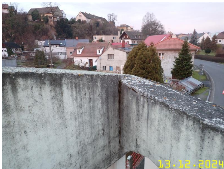
124 NOSNÁ KONSTRUKCE Z PLOŠINY.JPG
