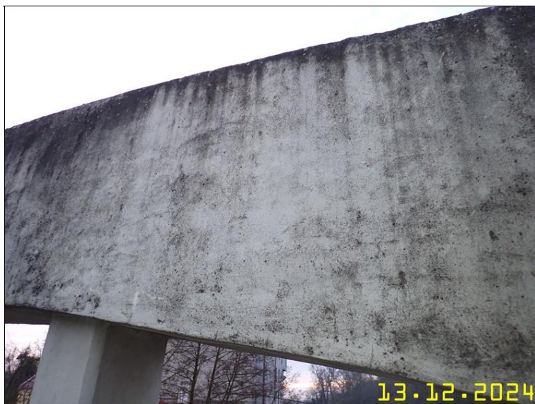
119 NOSNÁ KONSTRUKCE Z PLOŠINY.JPG
