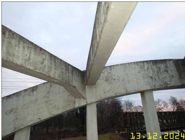
175 NOSNÁ KONSTRUKCE Z PLOŠINY.JPG
