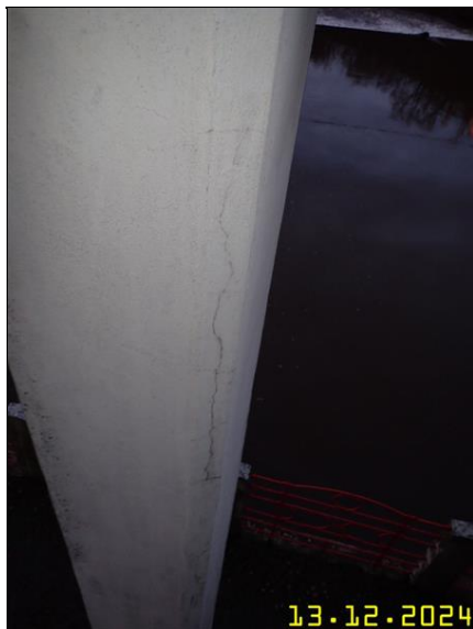
157 NOSNÁ KONSTRUKCE Z PLOŠINY.JPG
