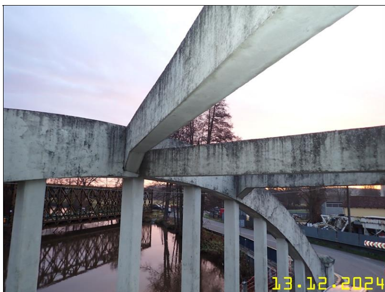
155 NOSNÁ KONSTRUKCE Z PLOŠINY.JPG
