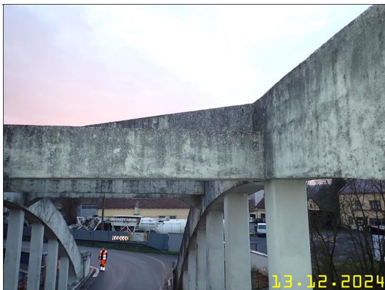
122 NOSNÁ KONSTRUKCE Z PLOŠINY.JPG
