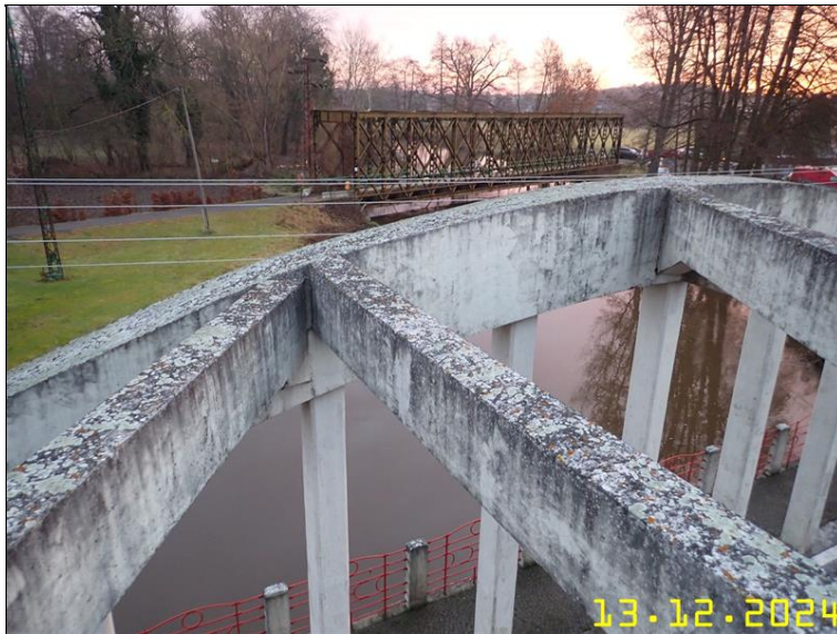
136 NOSNÁ KONSTRUKCE Z PLOŠINY.JPG
