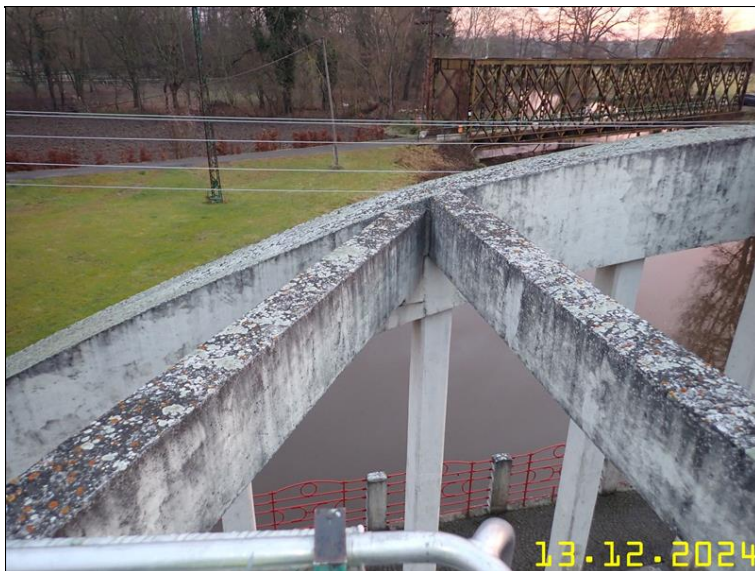
137 NOSNÁ KONSTRUKCE Z PLOŠINY.JPG
