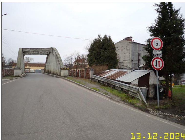
001 PROSTOROVÉ USPOŘÁDÁNÍ NA MOSTU V POHLEDU PO SMĚRU STANIČENÍ.JPG
