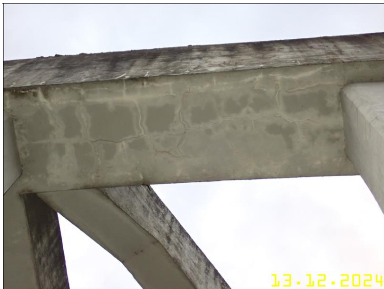
181 NOSNÁ KONSTRUKCE Z PLOŠINY.JPG
