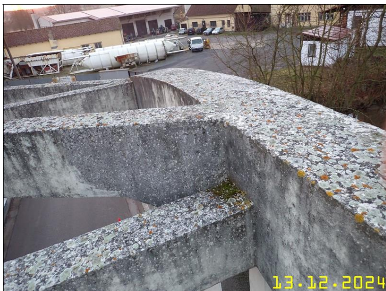
134 NOSNÁ KONSTRUKCE Z PLOŠINY.JPG
