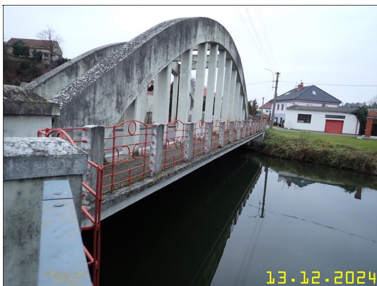
116 LEVÁ ŘÍMSA V POHLEDU PROTI SMĚRU STANIČENÍ.JPG
