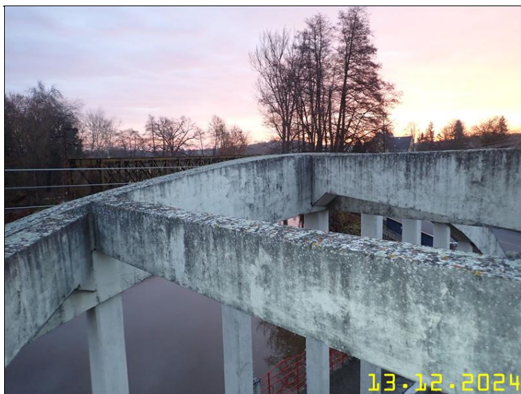
128 NOSNÁ KONSTRUKCE Z PLOŠINY.JPG
