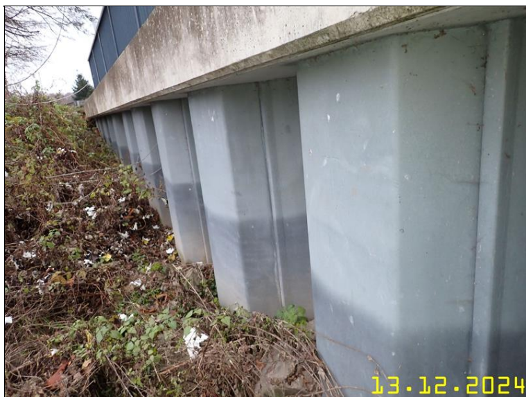
113 PŘILEHLÁ ZĚĎ K OPĚŘE O2 VLEVO.JPG
