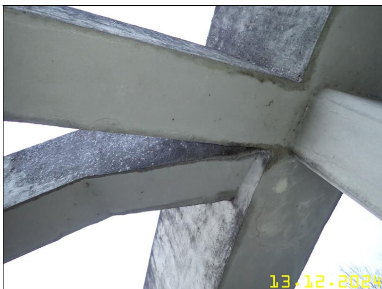
177 NOSNÁ KONSTRUKCE Z PLOŠINY.JPG
