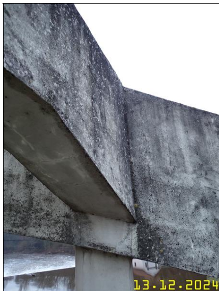
118 NOSNÁ KONSTRUKCE Z PLOŠINY.JPG
