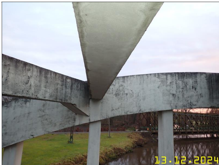
160 NOSNÁ KONSTRUKCE Z PLOŠINY.JPG
