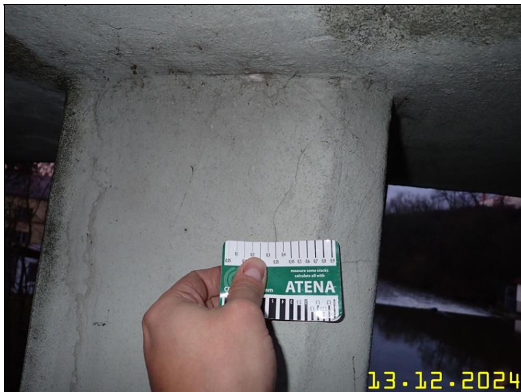
151 NOSNÁ KONSTRUKCE Z PLOŠINY.JPG
