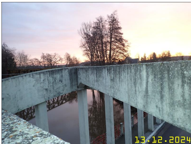
146 NOSNÁ KONSTRUKCE Z PLOŠINY.JPG
