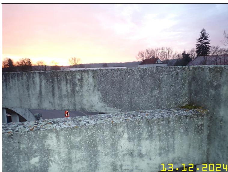
126 NOSNÁ KONSTRUKCE Z PLOŠINY.JPG
