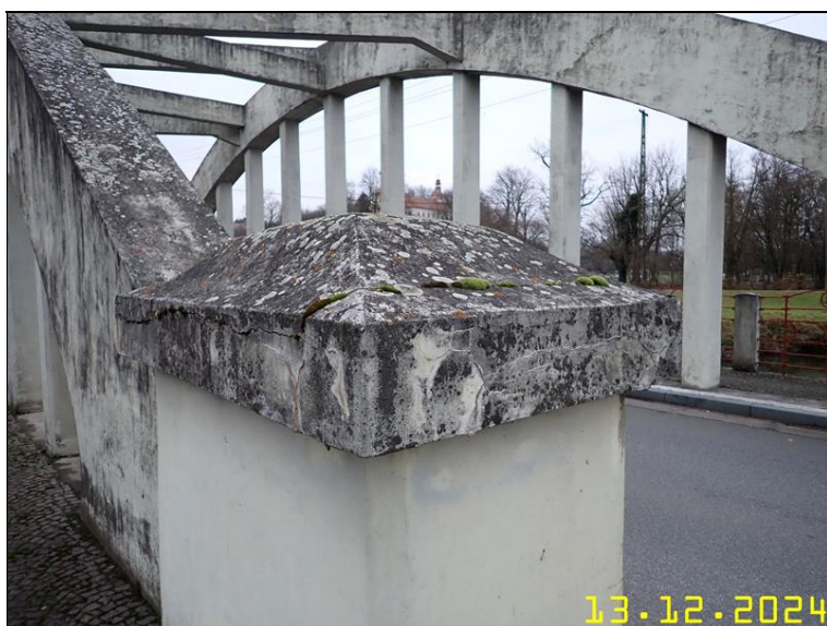
021 OBLOUK NA PRAVÉ STRANĚ PROTI SMĚRU STANIČENÍ.JPG
