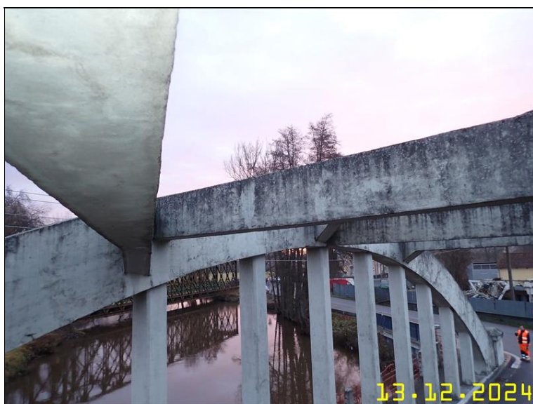
123 NOSNÁ KONSTRUKCE Z PLOŠINY.JPG
