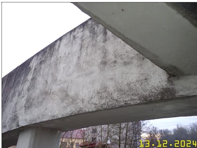
173 NOSNÁ KONSTRUKCE Z PLOŠINY.JPG
