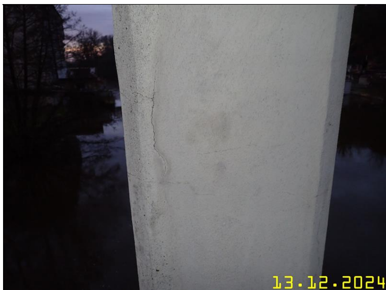
158 NOSNÁ KONSTRUKCE Z PLOŠINY.JPG
