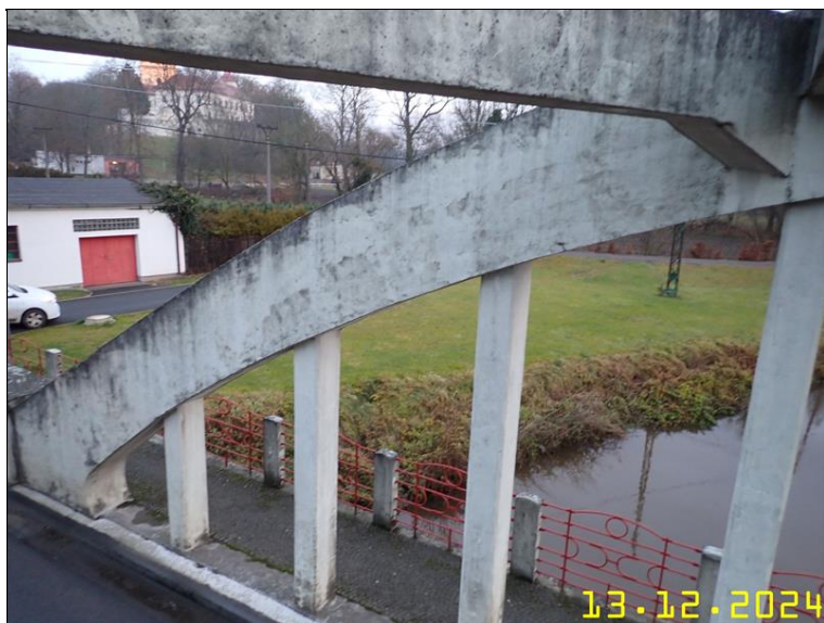
169 NOSNÁ KONSTRUKCE Z PLOŠINY.JPG
