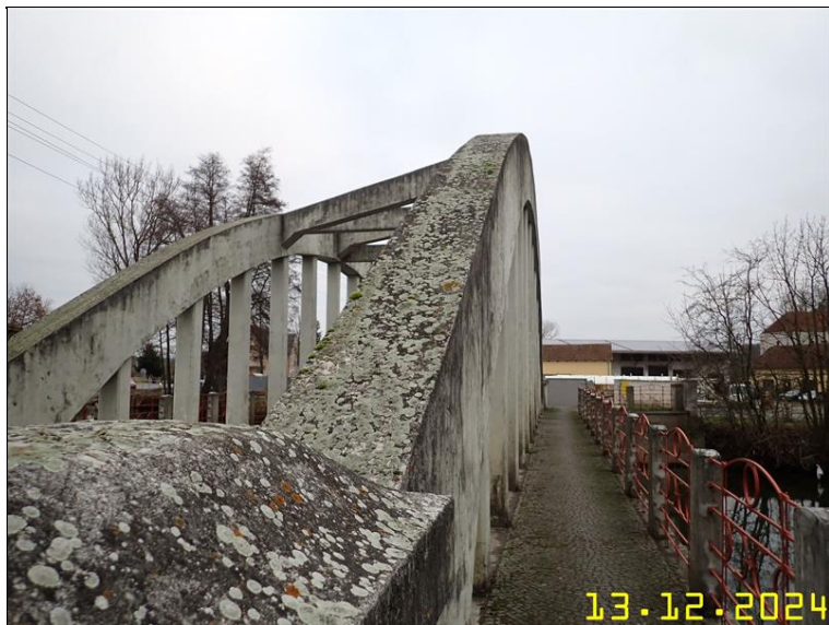
007 HORNÍ POVRCH PRAVÉHO OBLOUKU CCA U OPĚRY O1.JPG
