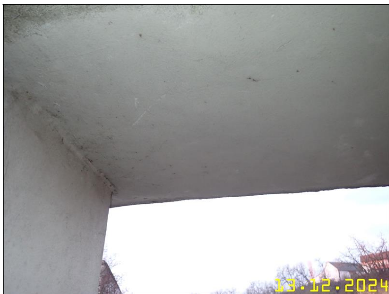
154 NOSNÁ KONSTRUKCE Z PLOŠINY.JPG
