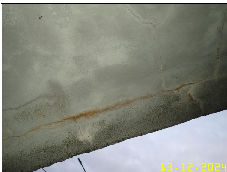
180 NOSNÁ KONSTRUKCE Z PLOŠINY.JPG
