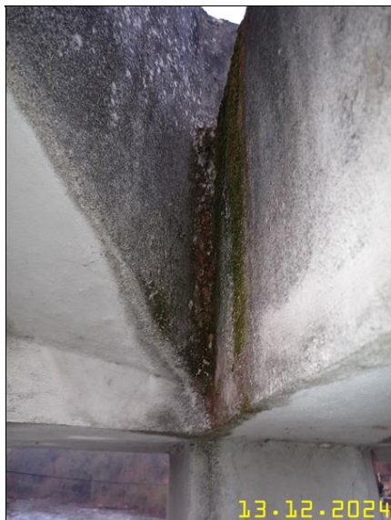
163 NOSNÁ KONSTRUKCE Z PLOŠINY.JPG
