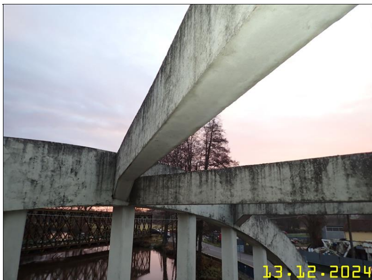
161 NOSNÁ KONSTRUKCE Z PLOŠINY.JPG
