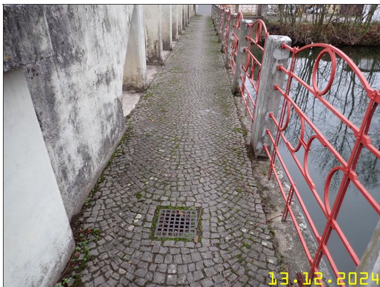
005 CHODNÍK NA PRAVÉ STRANĚ MOSTU.JPG
