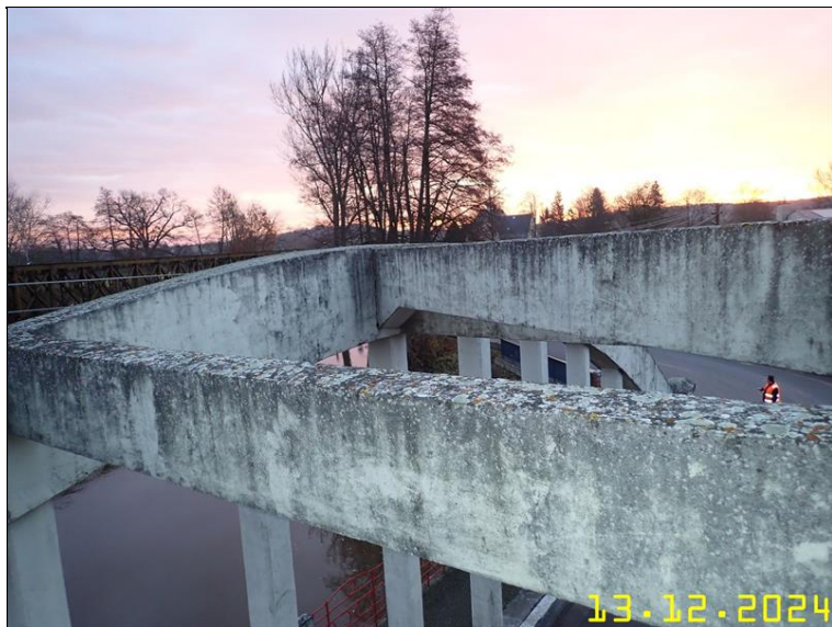
127 NOSNÁ KONSTRUKCE Z PLOŠINY.JPG
