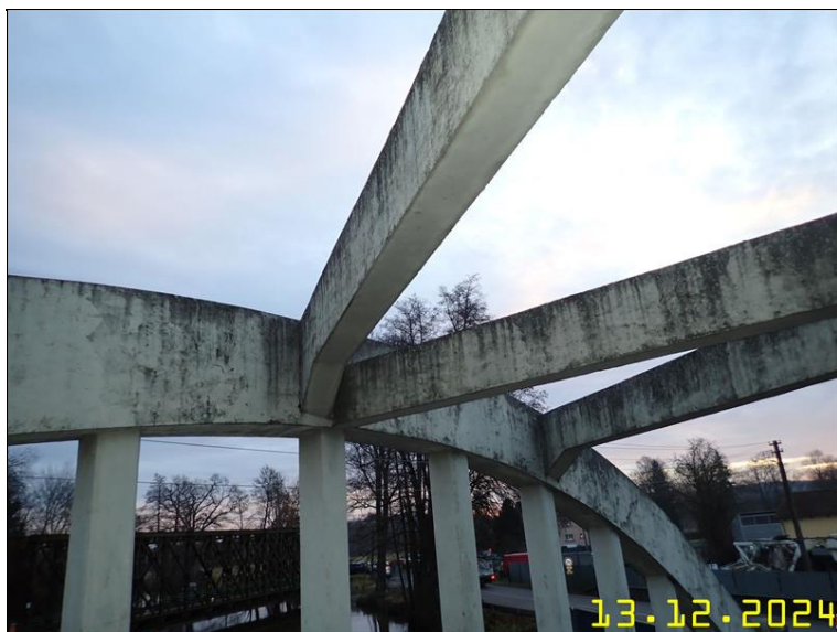
176 NOSNÁ KONSTRUKCE Z PLOŠINY.JPG
