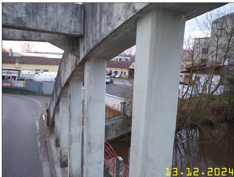
172 NOSNÁ KONSTRUKCE Z PLOŠINY.JPG
