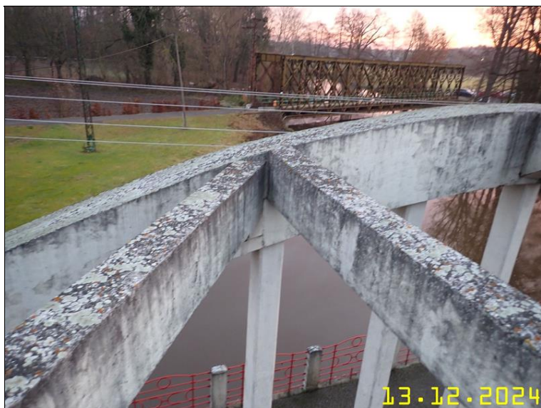
140 NOSNÁ KONSTRUKCE Z PLOŠINY.JPG
