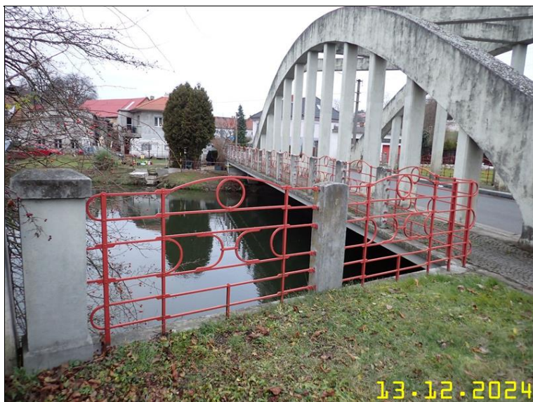
023 PRAVÁ STRANA MOSTU.JPG
