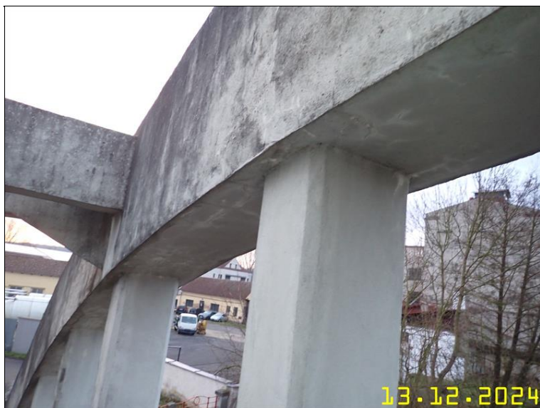
164 NOSNÁ KONSTRUKCE Z PLOŠINY.JPG
