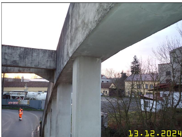
153 NOSNÁ KONSTRUKCE Z PLOŠINY.JPG
