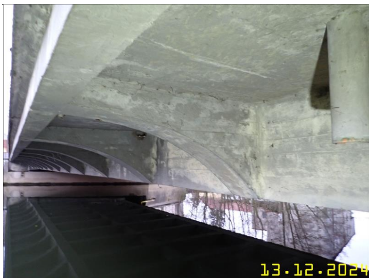
077 PRAVÁ STRANA NK PODHLED.JPG
