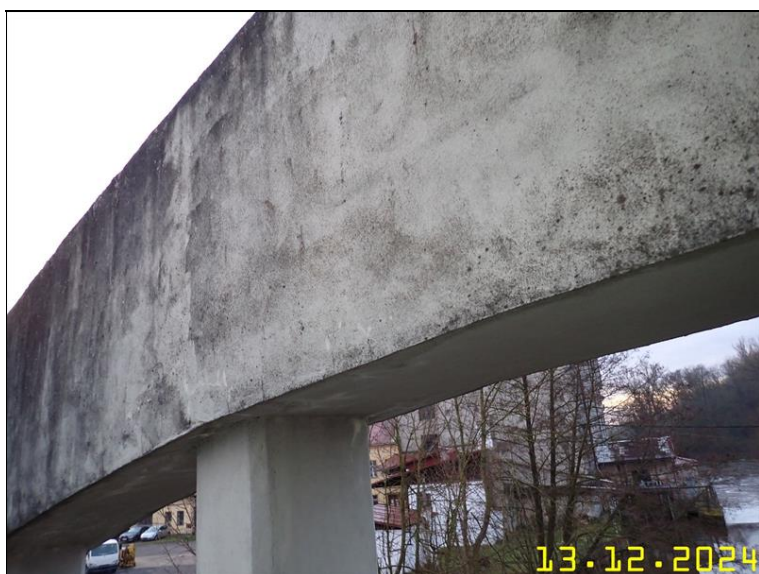
162 NOSNÁ KONSTRUKCE Z PLOŠINY.JPG
