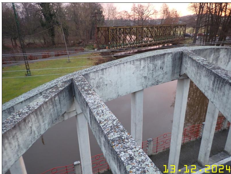
143 NOSNÁ KONSTRUKCE Z PLOŠINY.JPG
