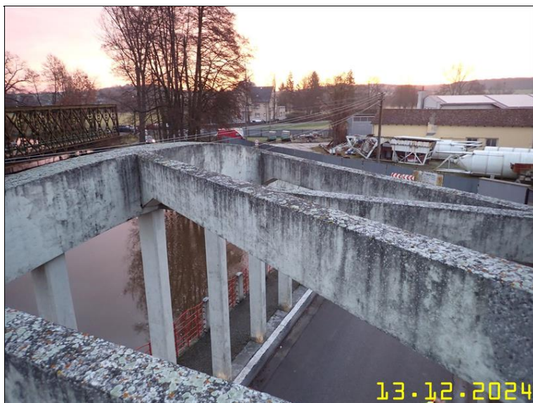
139 NOSNÁ KONSTRUKCE Z PLOŠINY.JPG
