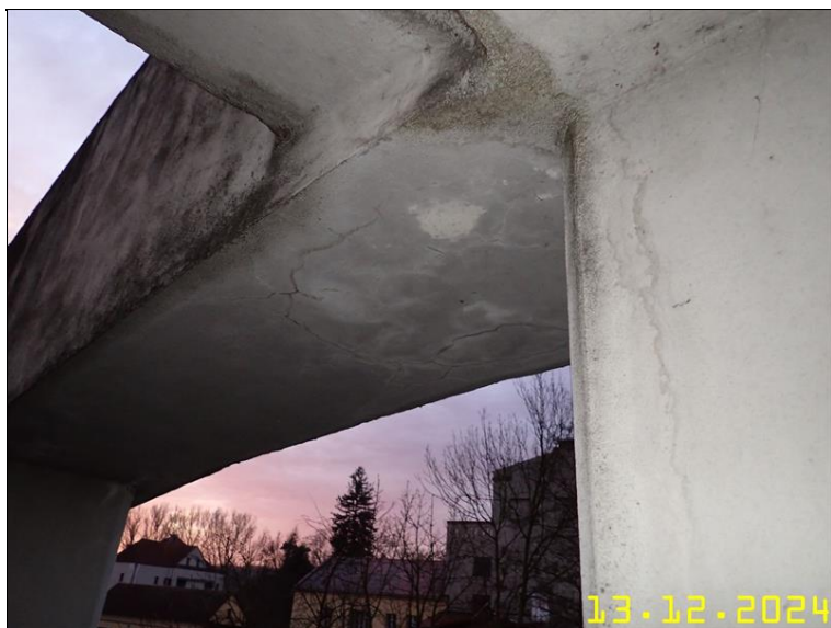
152 NOSNÁ KONSTRUKCE Z PLOŠINY.JPG
