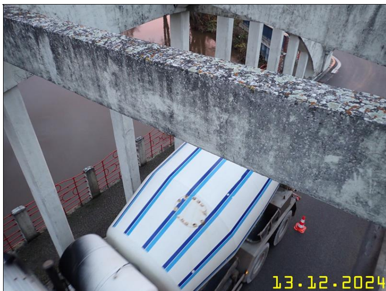
131 NOSNÁ KONSTRUKCE Z PLOŠINY.JPG
