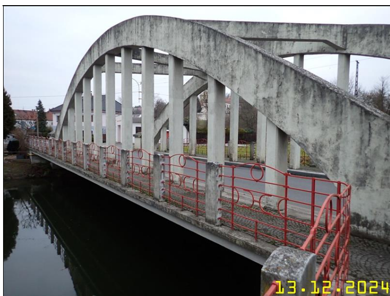
117 PRAVÁ ŘÍMSA V POHLEDU PROTI SMĚRU STANIČENÍ.JPG
