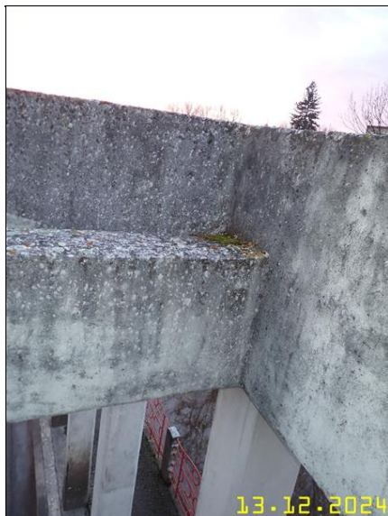
133 NOSNÁ KONSTRUKCE Z PLOŠINY.JPG
