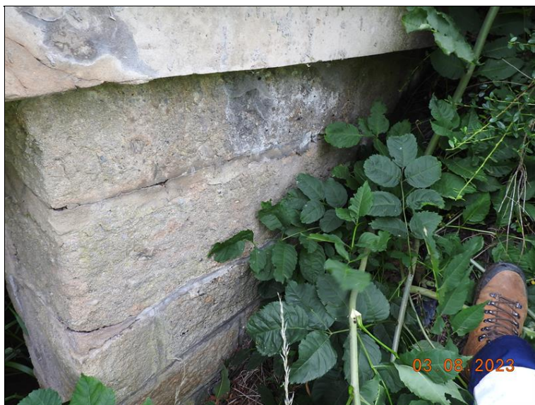
004_Levé křídlo OP1. Znamky po zatékání, degradace zdiva.jpg
