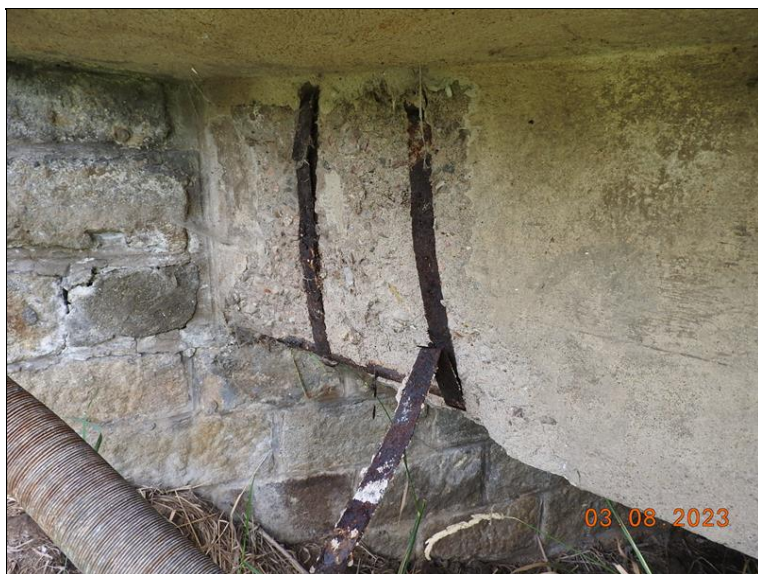
027_Nosná konstrukce u OP1 detail. Separace krycí vrstvy, koroze třmínků.jpg
