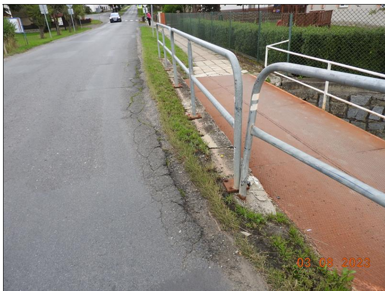
015_Krajnice vpravo. Zanesení vegetací.jpg
