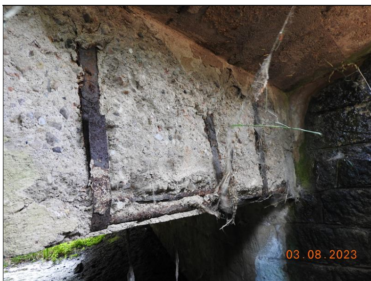
023_Nosná konstrukce detail vpravo. Degradace betonu, silná koroze třmíneků.jpg
