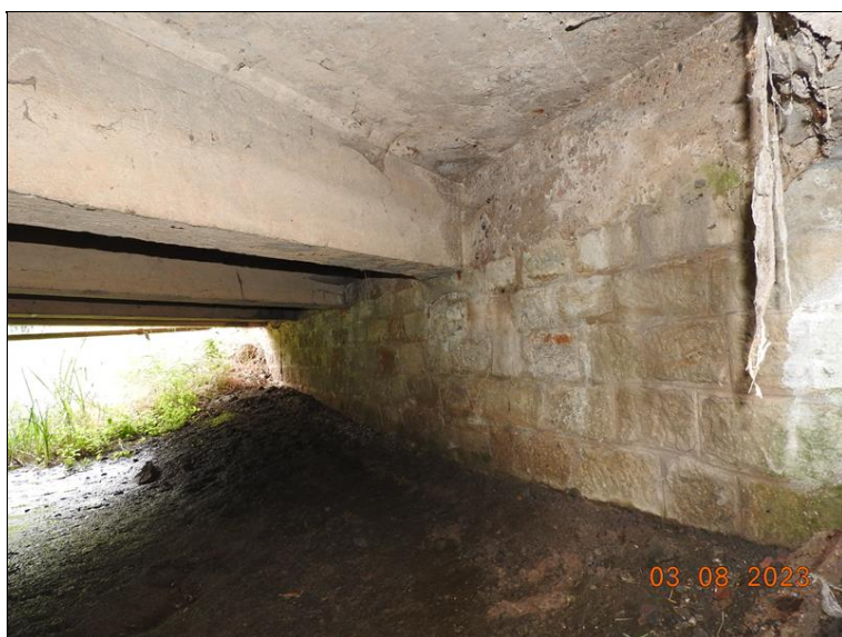
022_OP2 pohled. Vlhkost, bionapadení, degradace zdiva.jpg
