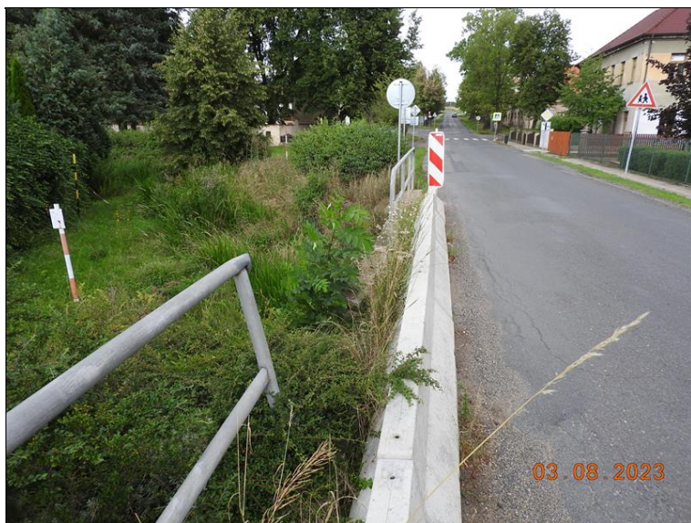
012_Levé zábradlí. Chybějící zábradlí, vychýlení, uvolněné kotvení.jpg
