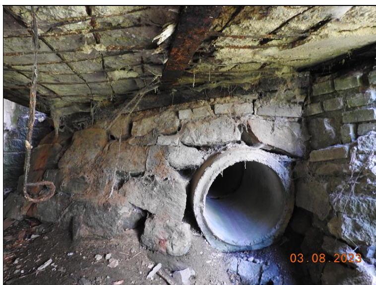
020_Opěra lávky. Degradace spárování a vyboulení zdiva.jpg
