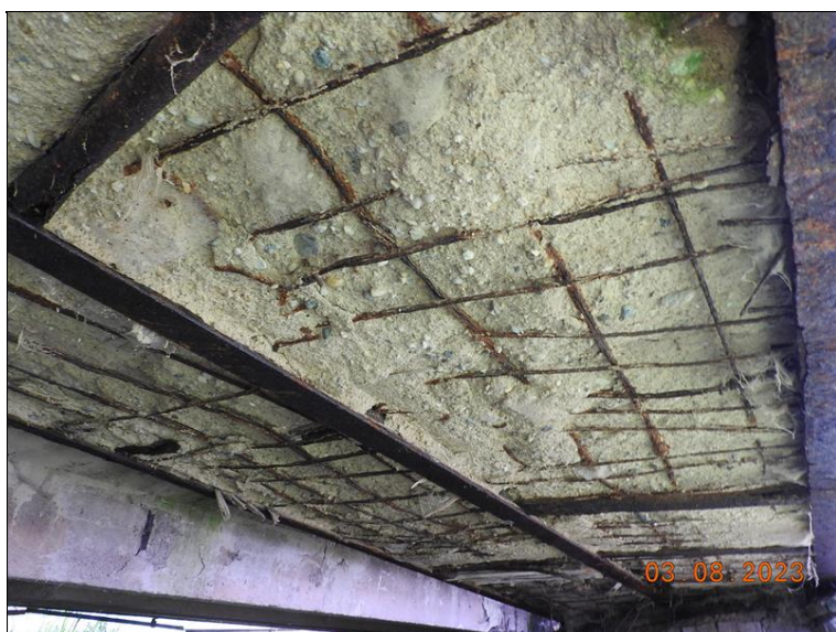
019_Podhled lávka. Obnažená výztuž, prokorodované pruty, drolení betonu, prokorodovaný nosník.jpg
