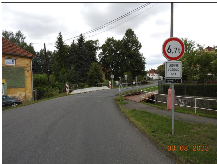
000_Šířkové uspořádání na mostě, pohled ve směru staničení. Chybí SDZ B14.jpg
