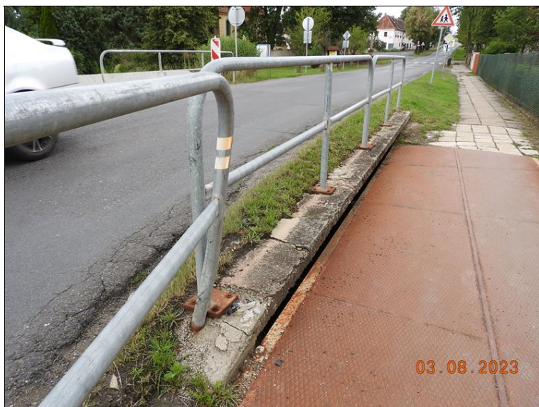
013_Pravé zábradlí. Lokální koroze, koroze kotvicích prvků, deformace.jpg
