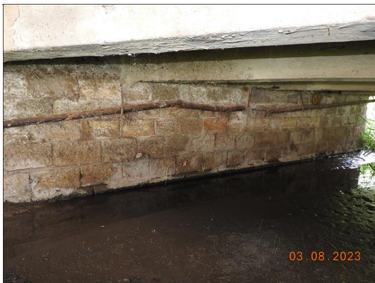
021_OP1 pohled. Vlhkost, bionapadení, degradace zdiva.jpg
