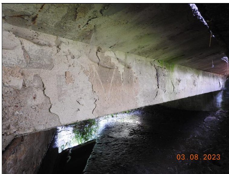
014_Bok nosné konstrukce zprava. Degradace povrchu betonu, koroze, bionapadení, známky zatékání.jpg
