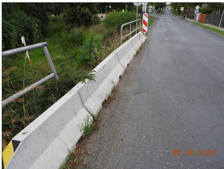
016_Krajnice vlevo. Betonová svodidla - zanesené otvory.jpg
