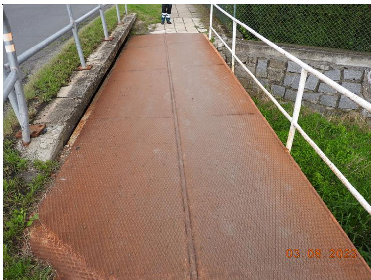
018_Pochozí lávka. Plošná povrchová koroze.jpg
