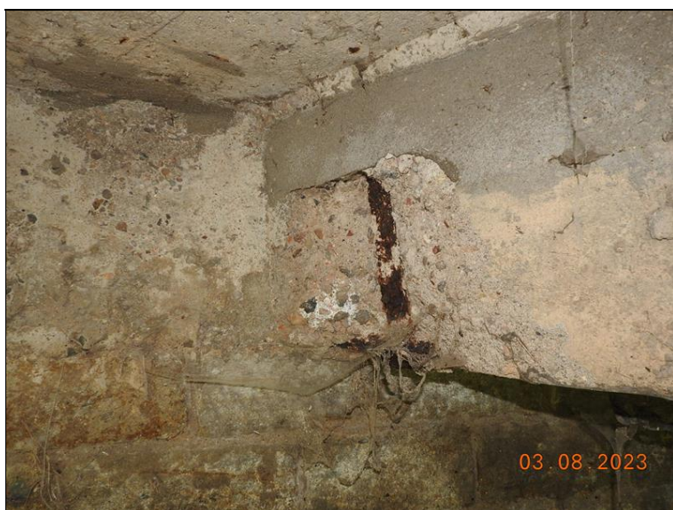
026_Nosná konstrukce u OP1 detail. Separace krycí vrstvy, koroze třmínků.jpg
