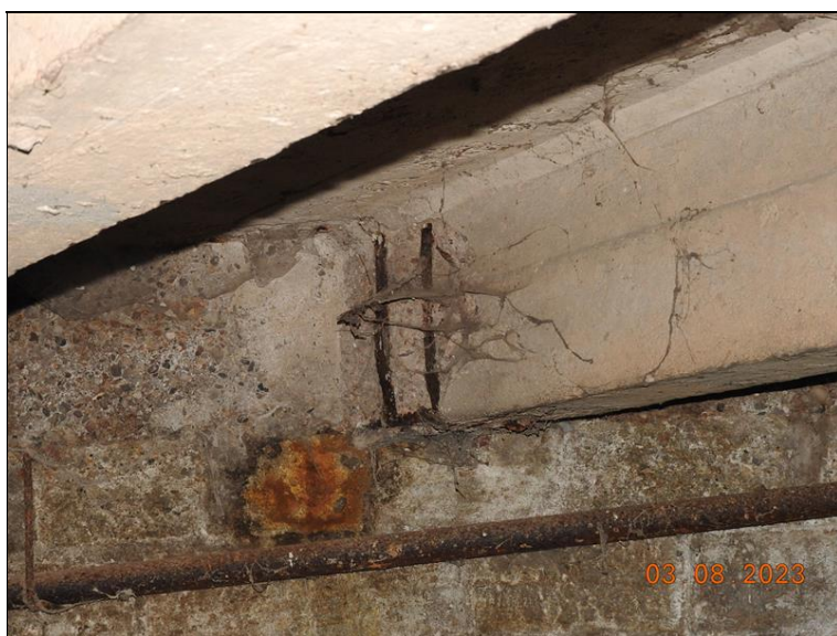
029_Nosná konstrukce pohled u OP1. Degradace krycí vrstvy, prokorodované třmínky.jpg
