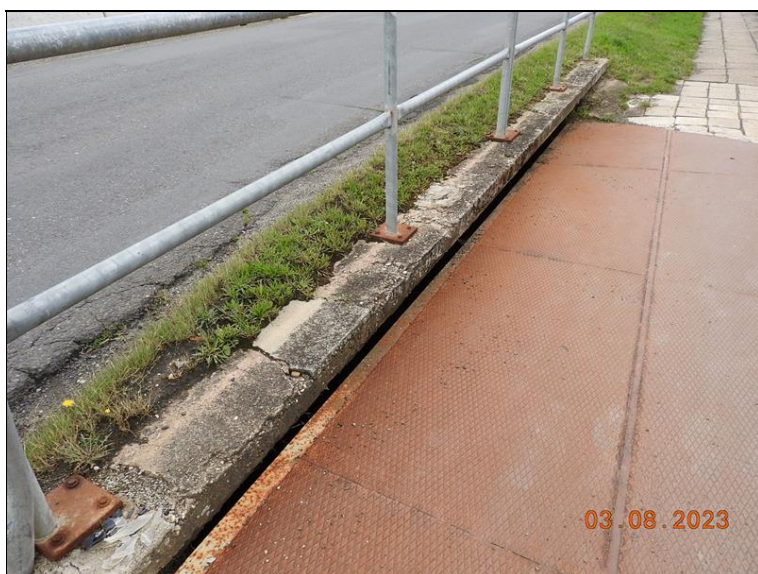
011_Pravá římsa. Bionapadení, povrchová degradace betonu.jpg
