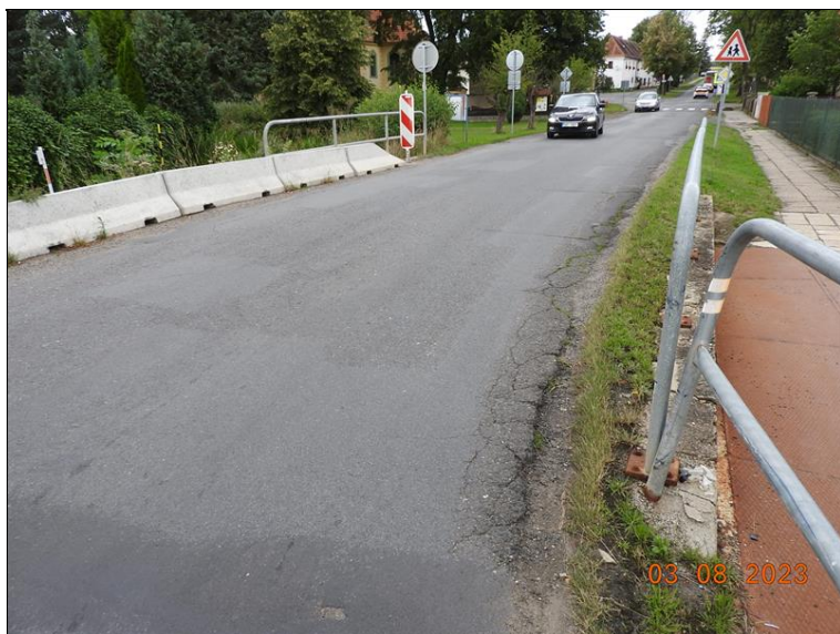
009_Vozovka. Přebalení vozovky, trhliny, lokálně výtluky.jpg
