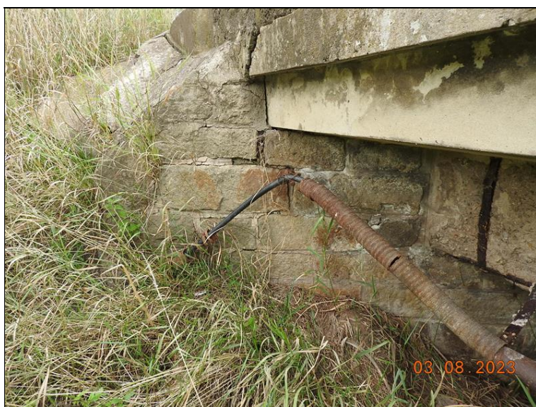
005_Levé křídlo OP2. Degradace spárování.jpg
