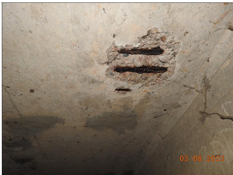
024_Podhled nosné konstrukce detail. Separace krycí vrstvy, koroze výztuže.jpg
