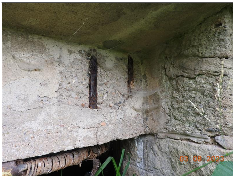
028_Pohled nosné konstrukce vpravo detail. Degradace krycí vrstvy, prokorodování třmínků.jpg
