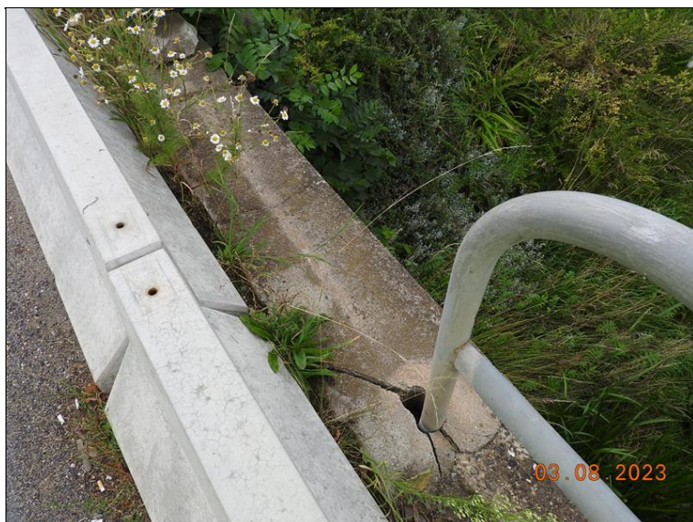
010_Levá římsa. Degradace betonu, bionapadení, poškození betonu vlivem nárazu.jpg
