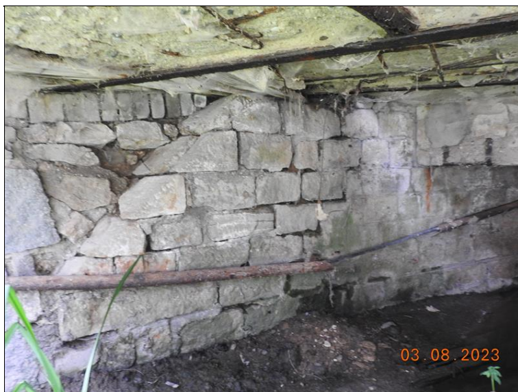
006_Pravé křídlo OP1. Degenerace spárování, uvolněné zdivo, bionapadení.jpg
