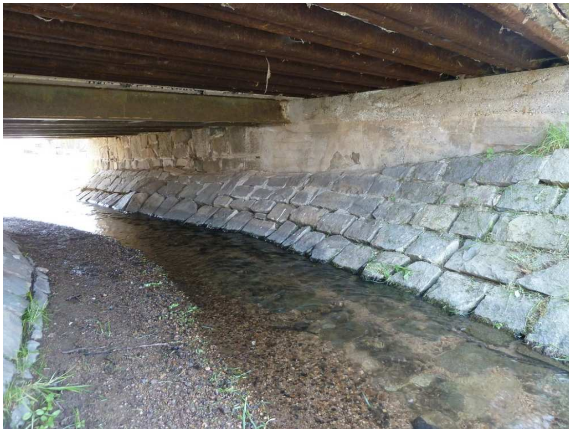
Foto 3: Podmostí stávajícího silničního mostu
