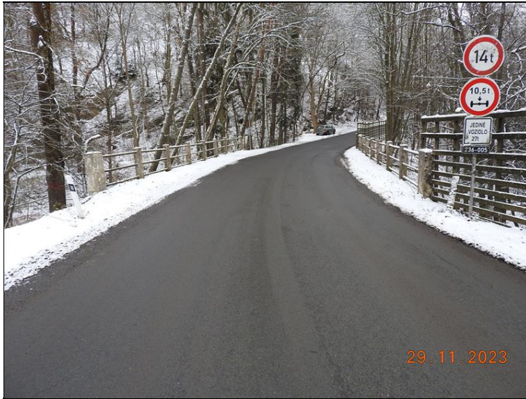
000_Šířkové uspořádání na mostě pohled ve směru staničení.jpg
