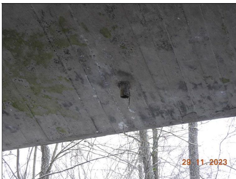
023_Pohled nosné konstrukce detail odvodnění.jpg
