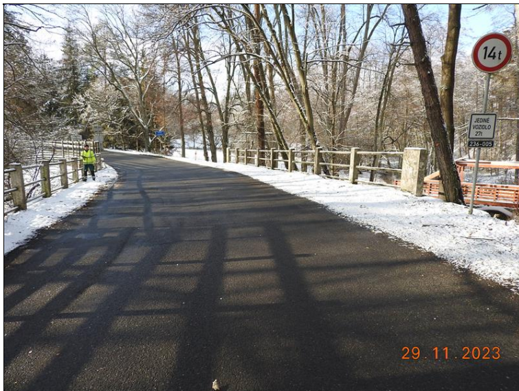
001_Šířkové uspořádání na mostě pohled proti směru staničení.jpg
