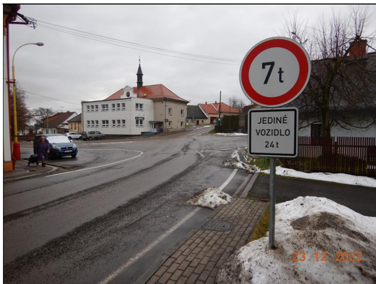
Pohled na most cca proti směru staničení.
