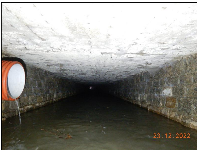
Vnitřní část mostu.
