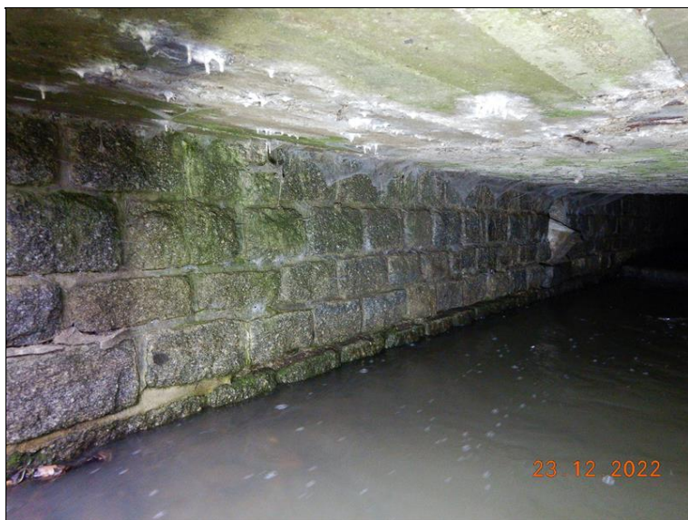
Opěra 02 u vtoku.
