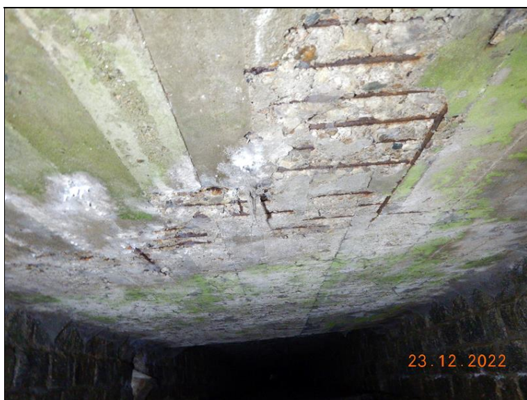
Podhled nosné konstrukce u výtoku.
