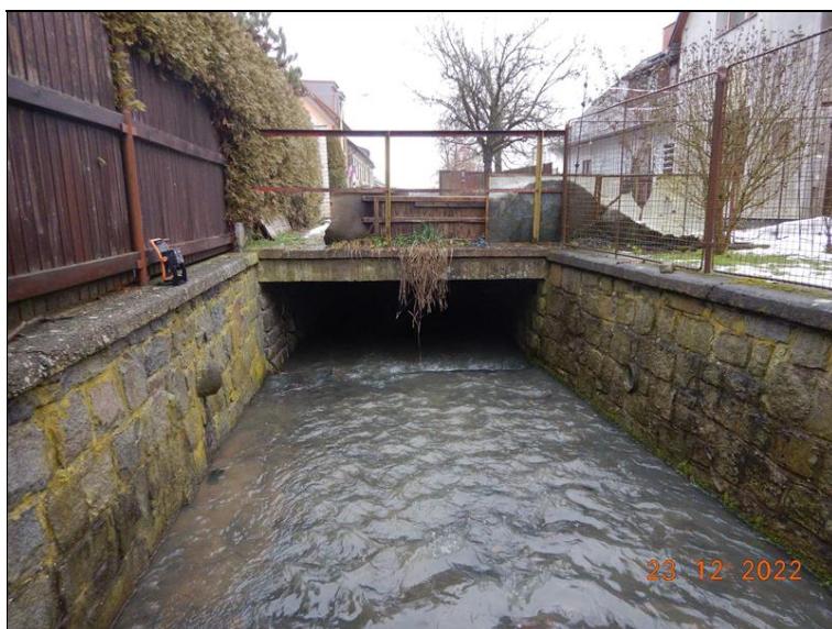
Výtokové čelo (levá strana mostu).
