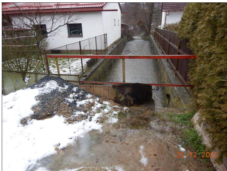
Vtokové čelo (levá strana mostu).
