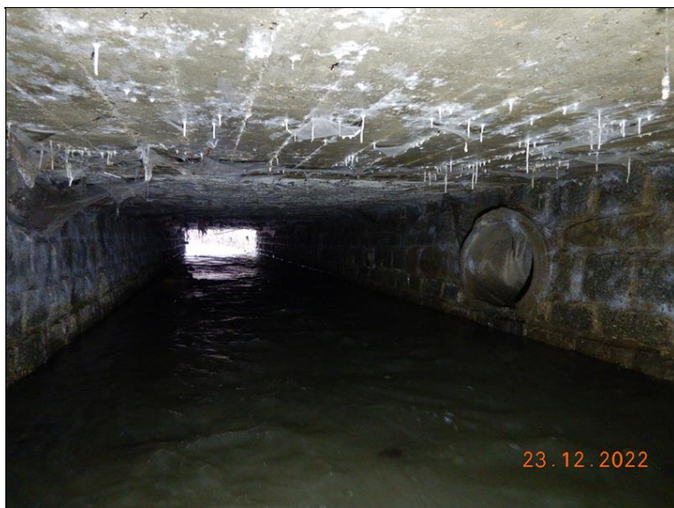
Vnitřní část mostu - cca polovina šířky.
