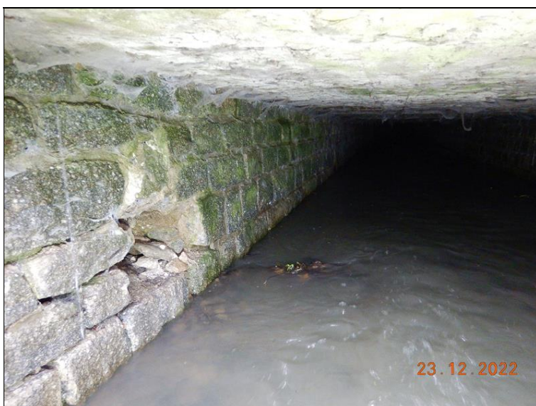
Opěra 02 u vtoku (vlevo).
