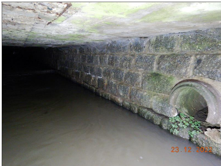
Opěra 02 u výtoku.
