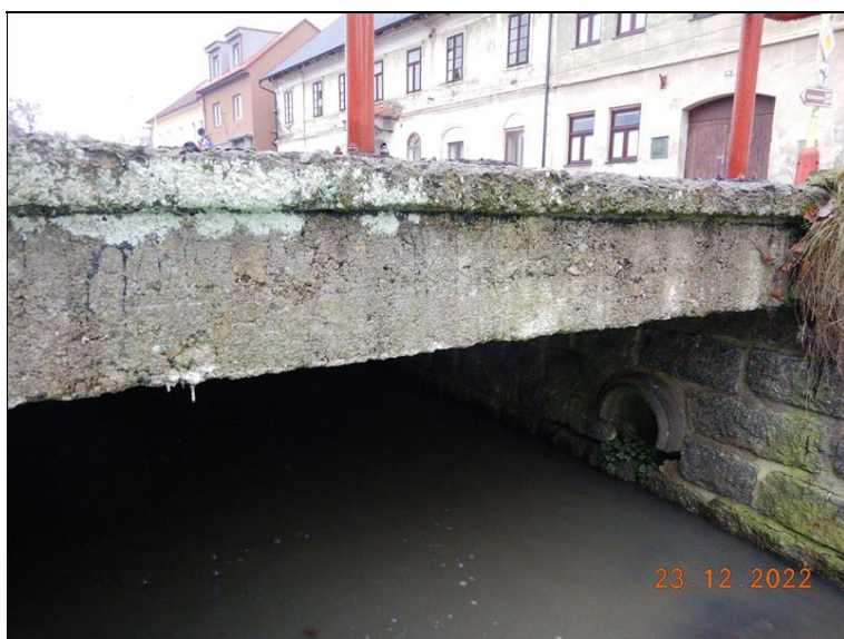
Čelo na výtoku.
