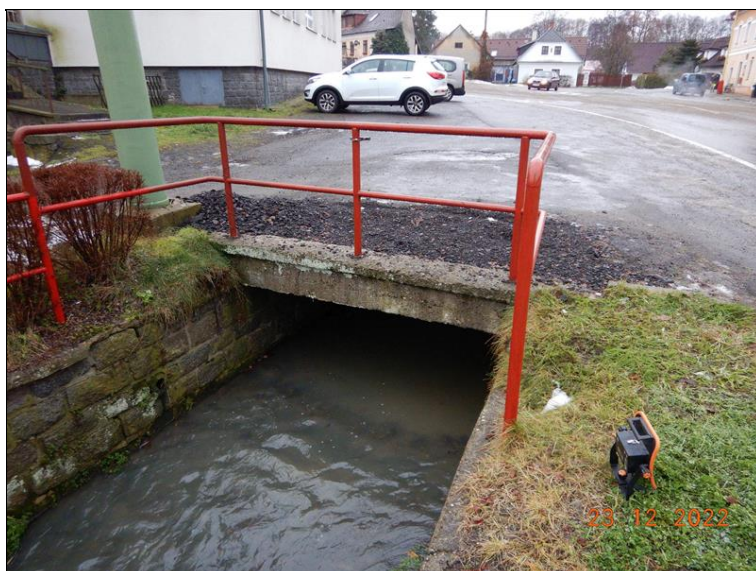
Výtokové čelo (pravá strana mostu).
