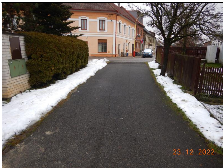
Vozovka od levého čela.
