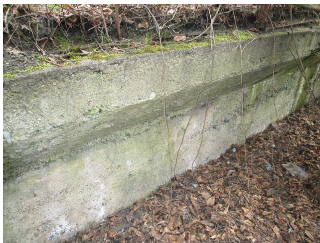
Líc zdi. Stopy zatékání a průsaků. Degradace betonu. Nazelenalý povlak, biologické napadení.
