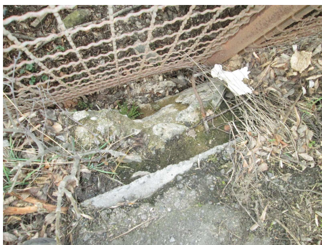
Masivní degradace betonu.
