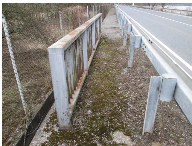
Nánosy, nečistoty na římse.
