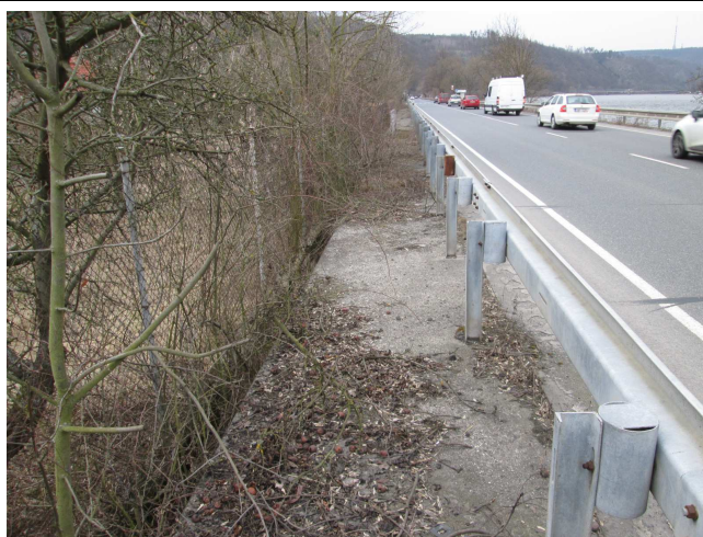
Nánosy, nečistoty na římse.
