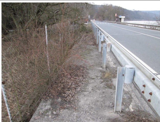
Nánosy, nečistoty na římse.
