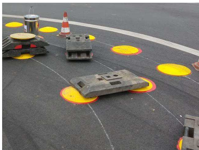
Obr. 6: Vzor instalovaných prvků. Vytlačené lepidlo mírně přesahuje obrys, styčná spára nesmí být otevřená.
