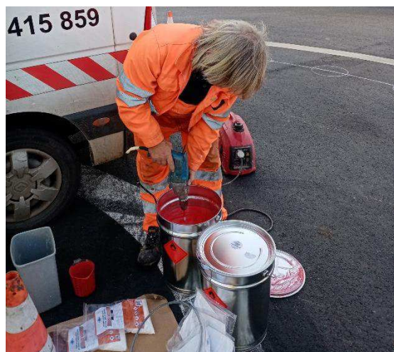
Obr. 3: Rozmíchání a odvážení lepidla.
