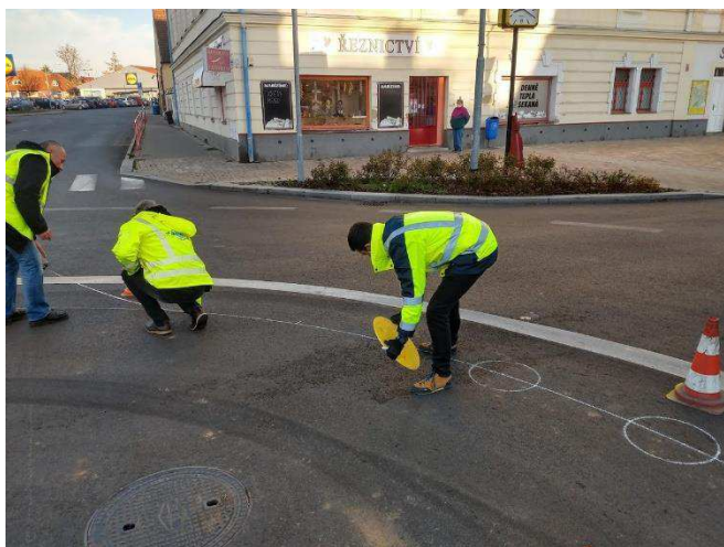
Obr. 1: Zakreslení polohy lepených prvků dle projektu.
