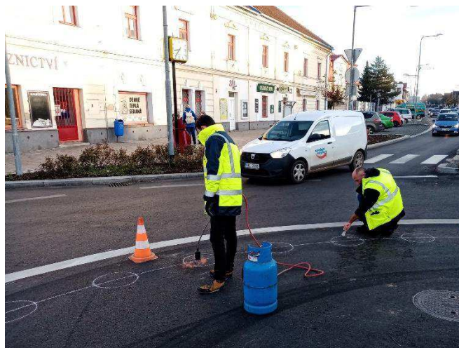
Obr. 2: Příprava povrchu (ohřívání, odstranění nečistot).
