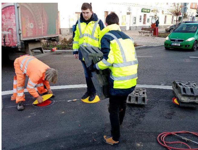
Obr. 5: Položení prvku do lepidla, zatěžování přilepených prvků (100 kg po dobu 10 minut).
