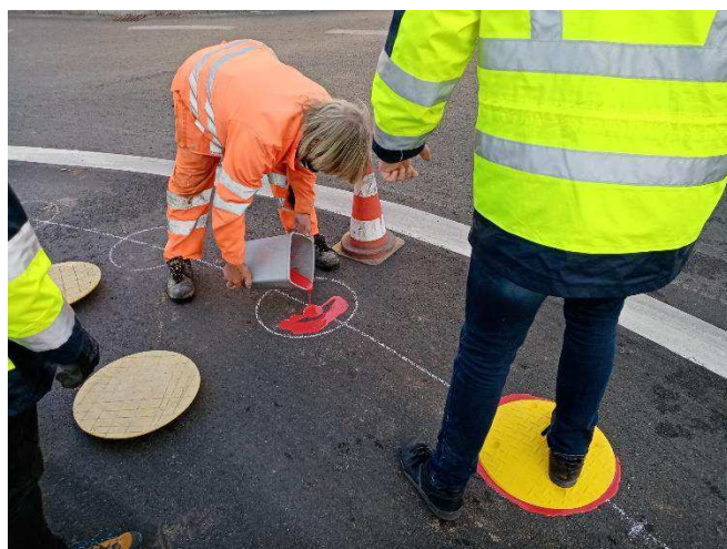
Obr. 4: Rozliv lepidla (množství pro 3 prvky cca 1,5 kg = 1 l složky A).
