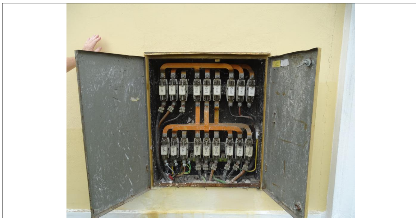
Obr. P2-8 – rozvaděč RH ve fasádě u hlavního vstupu /zde bude kompletně vyměněn a doplněn o nové jističní odpojitelné signálem EPS/
