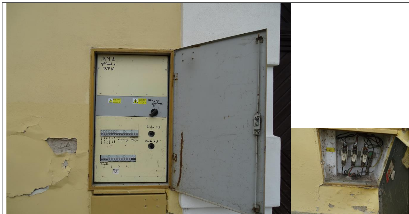
Obr. P2-8 – rozvaděč RPV /zde bude jištění R-UPS1, jistič čerpadel budou nově v R-UPS1/
