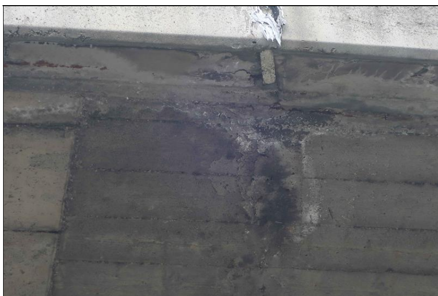
průsak příčnou sparou v římse na spodní líc konzoly mostovky
