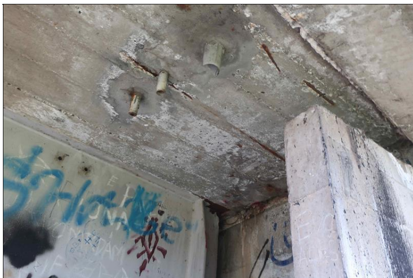
trubky odvodnění povrchu izolace u O5
