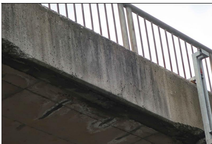
trhliny v pravé římse
