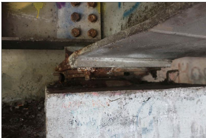
intenzivní koroze ložiska na O5
