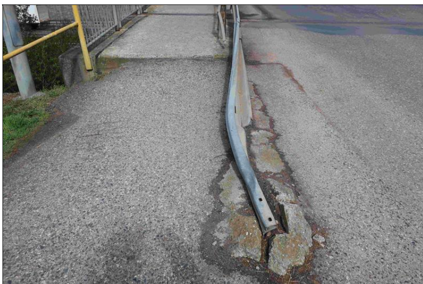
detail zakončení svodnice levého svodidla před O1
