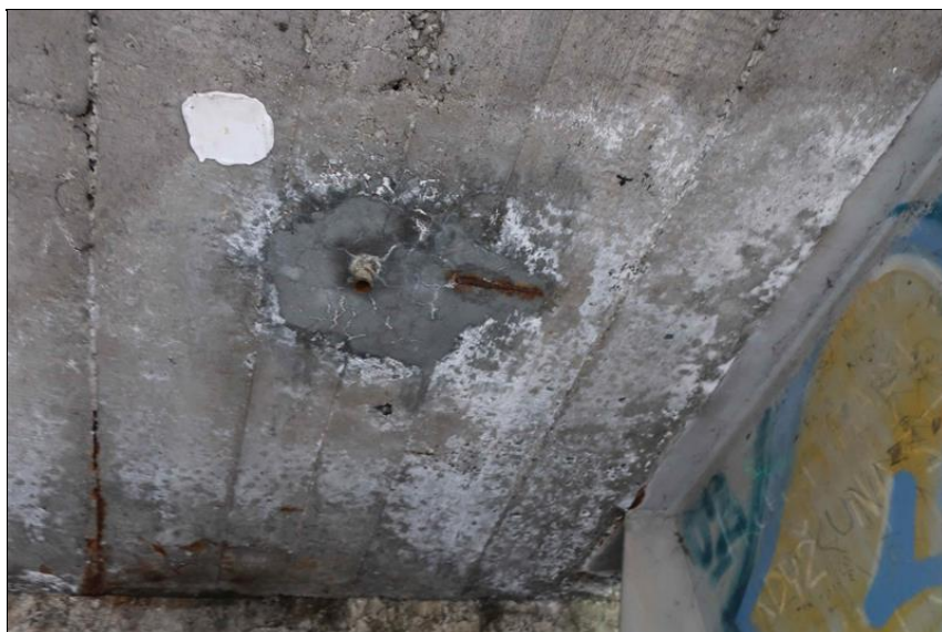
stopy po průsacích s výluhy pojiva na spodním líci mostovky
