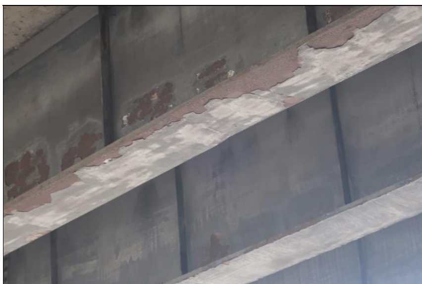
separace PKO ze spodního líce dolní pásnice hlavního nosníku
