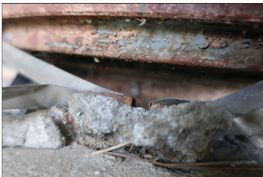
DTTO - sevřená spára, znemožnění pootočení ložiska
