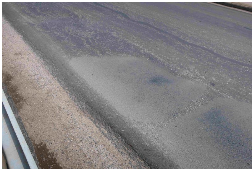
degradace betonu a trhliny v nášlapné hraně levé římsy
