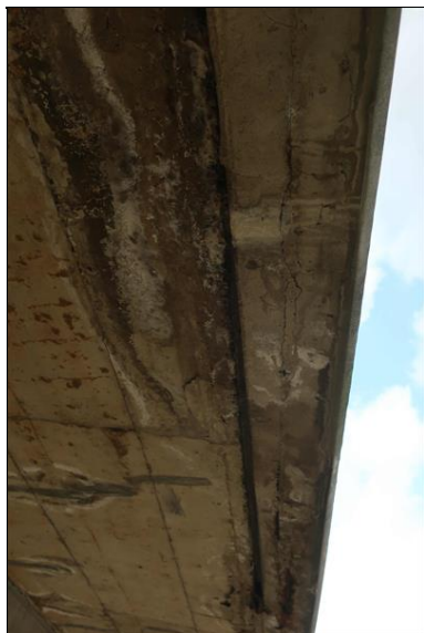
podélné trhliny na spodním líci římsou jsou charakteristické pro separaci krycí vrstvy nad korodující výztuží
