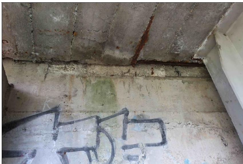
stopy po průsacích a koroze obnažené výztuže na spodním líci mostovky u dilatační spáry O5
