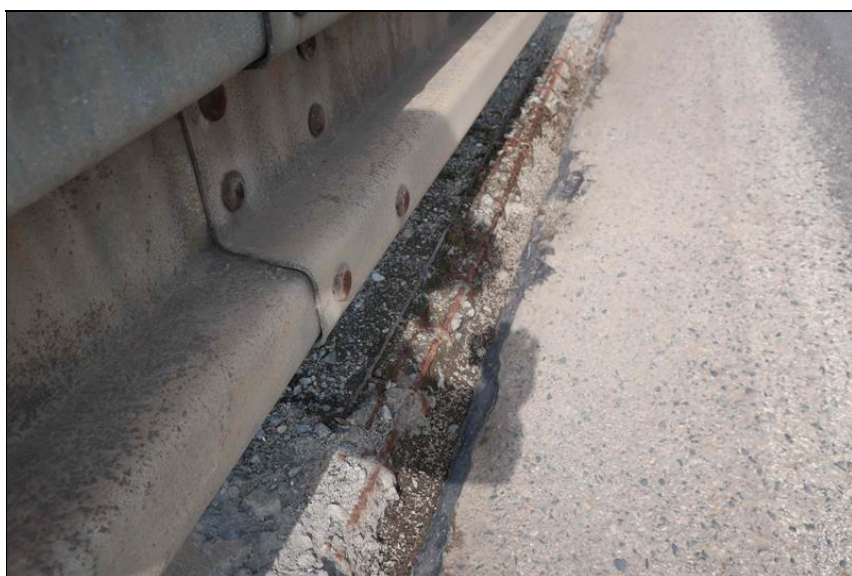
rozpad betonu a intenzivní koroze výztuže levého chodníku
