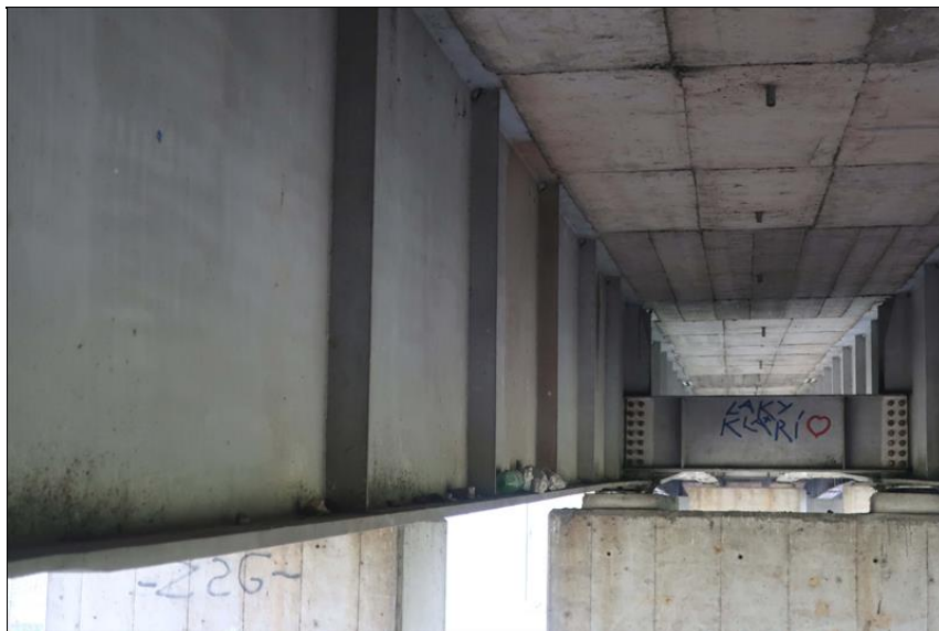
kameny na horním líci spodní pásnice hlavního nosníku
