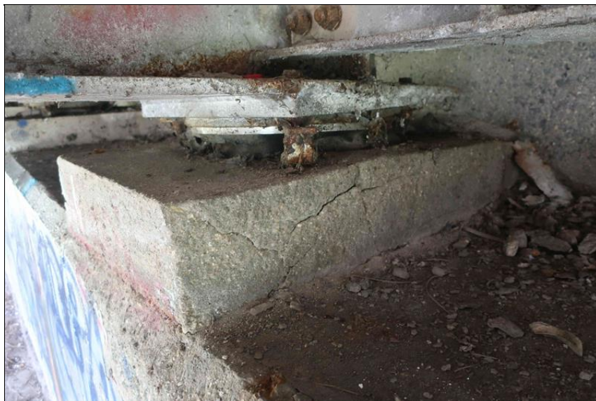
rozpad podkladního bloku pod ložiskem O5
