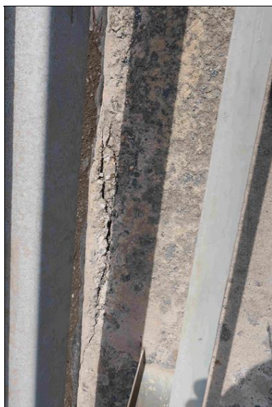
degradace betonu a trhliny v nášlapné hraně levé římsy
