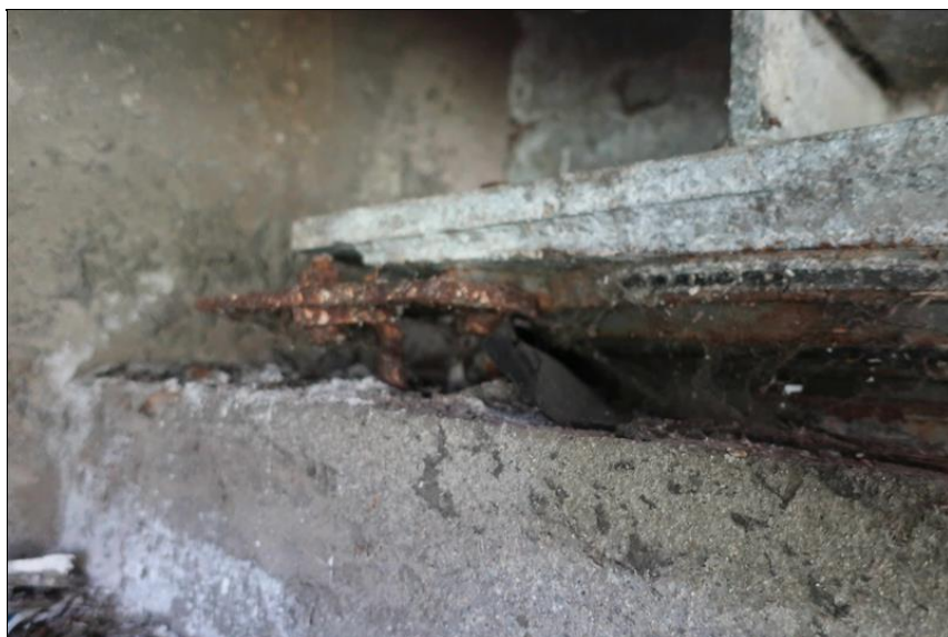
ponechané korodující aretační šrouby ložiska na O5
