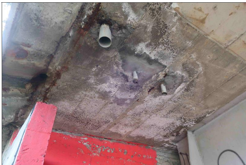
aktivní průsaky pravou konzolou mostovky u O1
