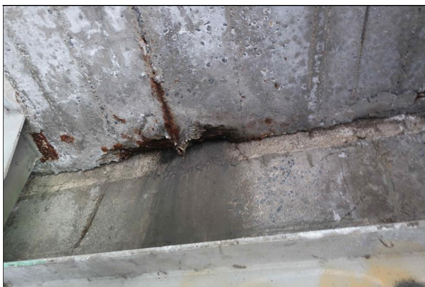
aktivní průsak dilatační sparou O5
