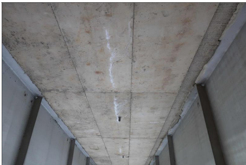
podélná trhlina s výluhy pojiva na spodním líci mostovky
