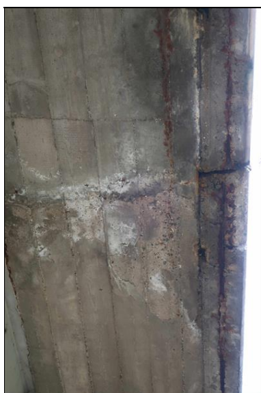
podhled NK nad P4, pravá konzola
