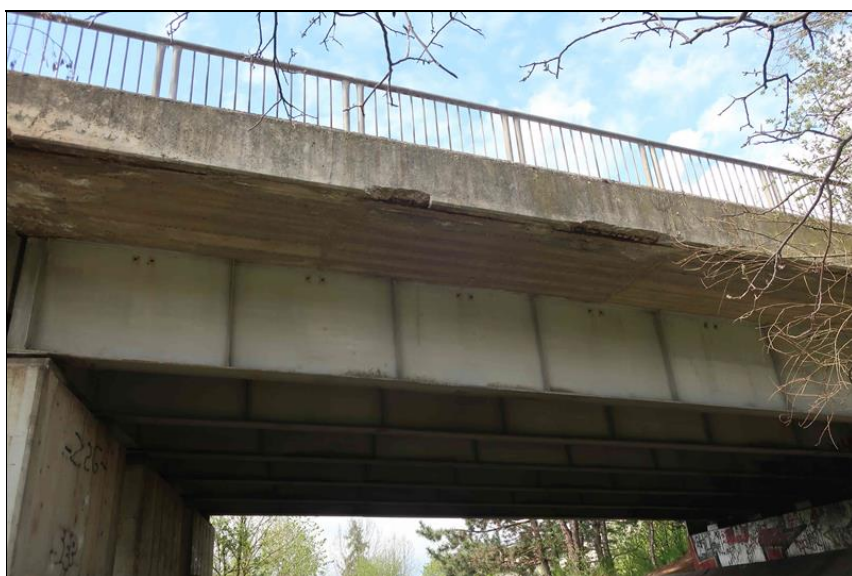
separovaná krycí vrstvy nad korodující výztuží na spodním lici římasy
