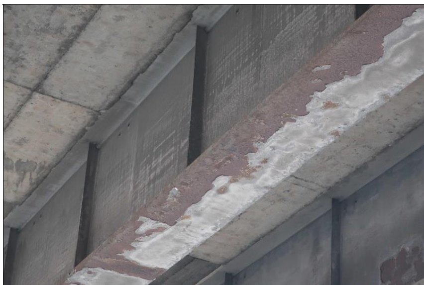
plošná povrchová koroze na spodním líci dolní pásnice hlavního nosníku
