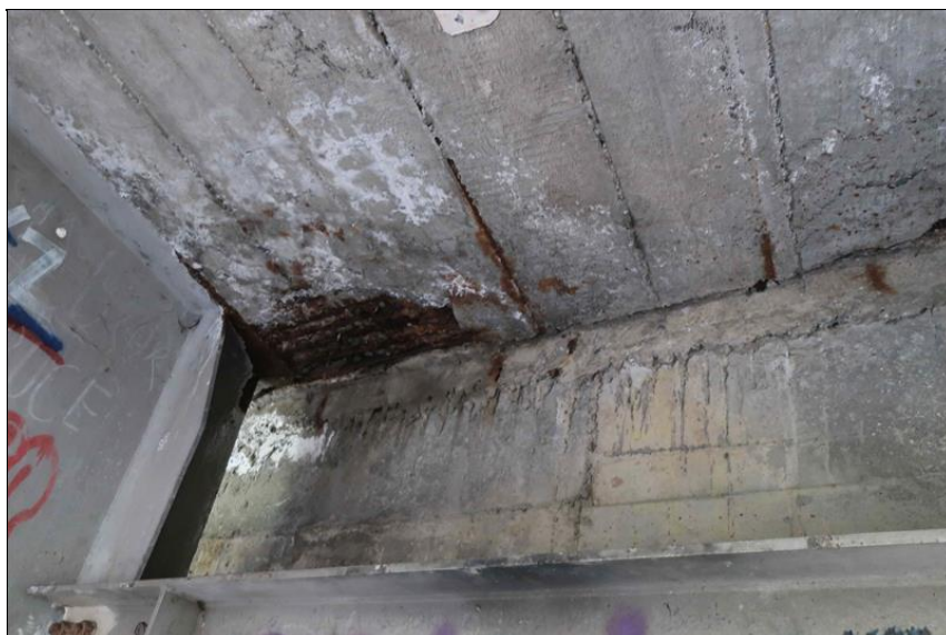
hloubková degradace betonu a intenzivní koroze výztuže mostovky v okolí prosakující dilatační spáry nad O5
