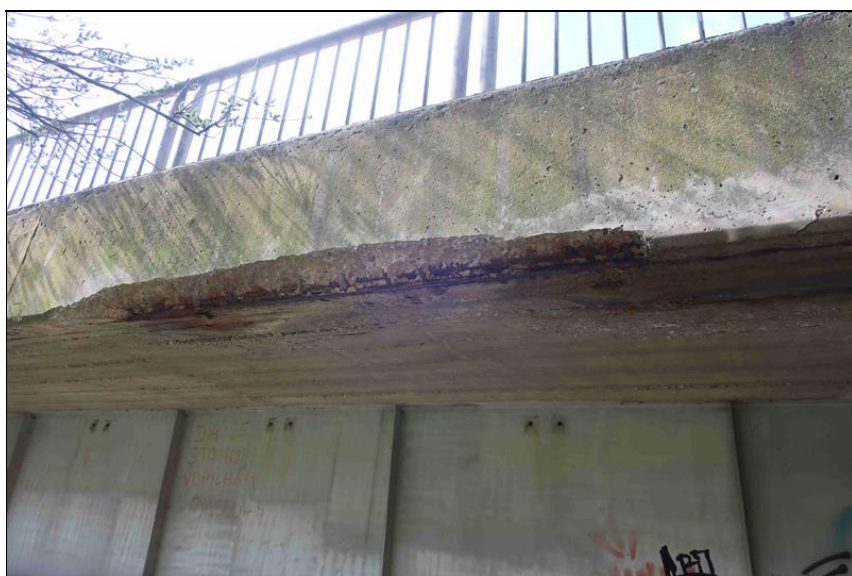
odpadlá krycí vrstva nad korodující výztuží na spodním lici římsy
