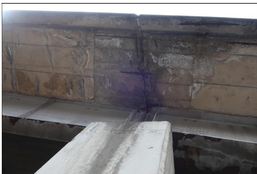
prosakovající pracovní spára v konzole mostovky nad P2
