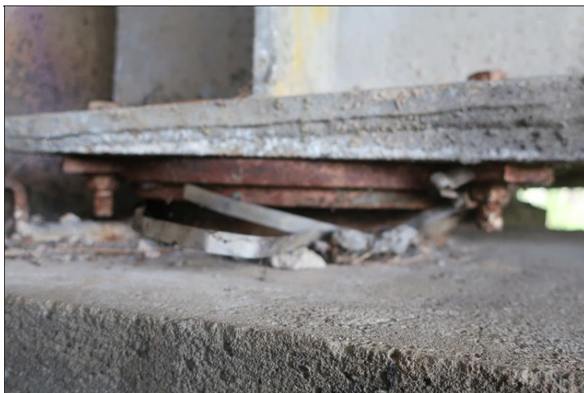
intenzivní koroze ložiska pod 1. nosníkem ve 4. poli na O5
