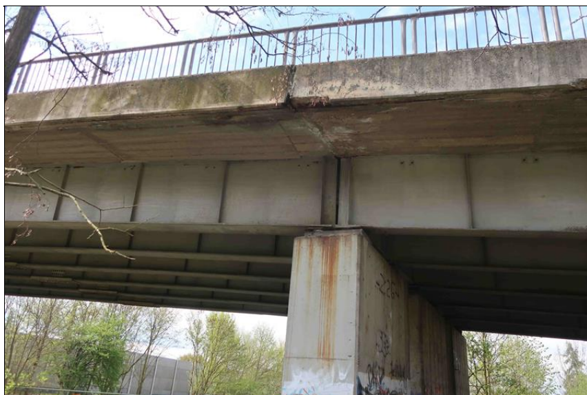
stopy po průsaku se stopami koroze na pravém boku P4
