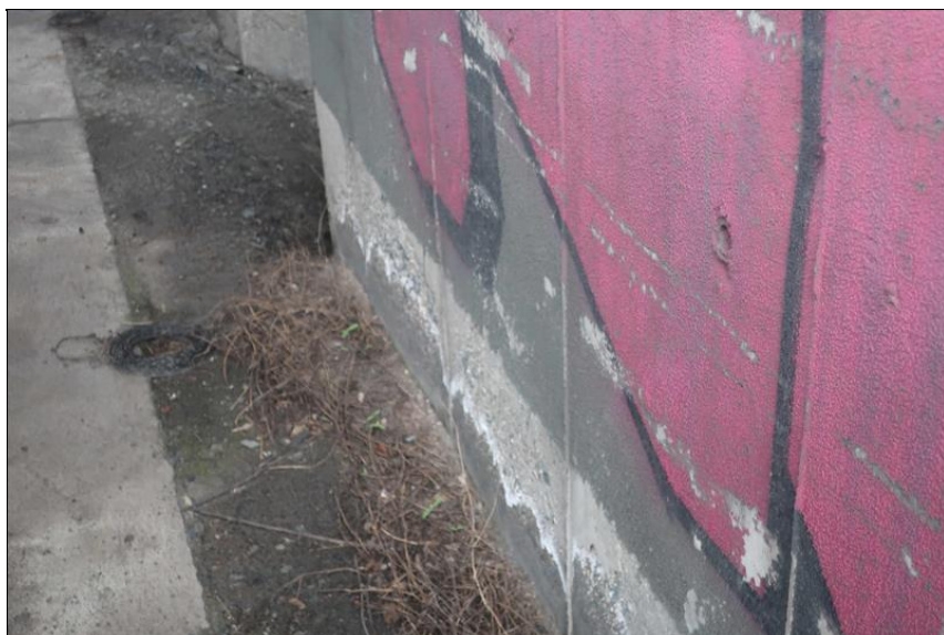
degradace betonu stojky P2 v úrovni terénu
