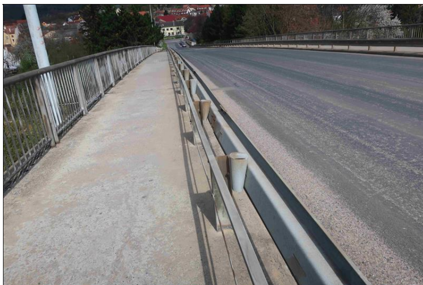
levé svodidlo deformované nárazem vozidla
