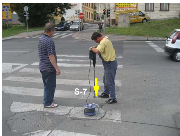
foto 47: Hloubení vrtané sondy S-7, křižovatka Hajnova/Huťská
