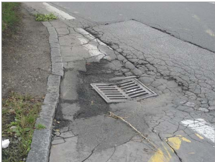
foto 37: Poruchy v místě kanalizačních vpustí v úseku č. 7
