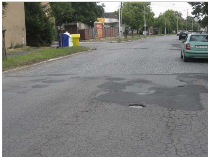
foto 26: Rozhraní úseků č. 3 (živičný povrch) a č. 4 (dlažba)
