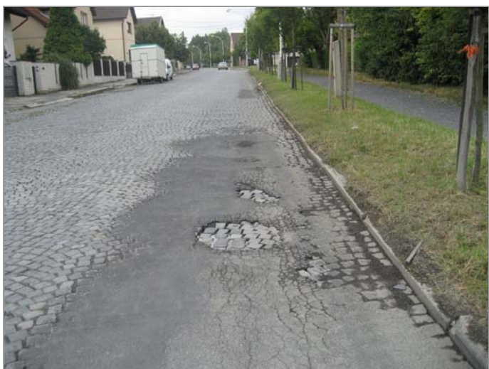
foto 29: Živičnou směsí opravená dlažba v úseku č. 4
