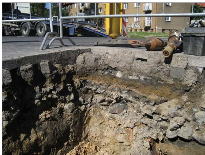
foto 16: Skladba konstrukce vozovky ve výkopu/sondě S-4
