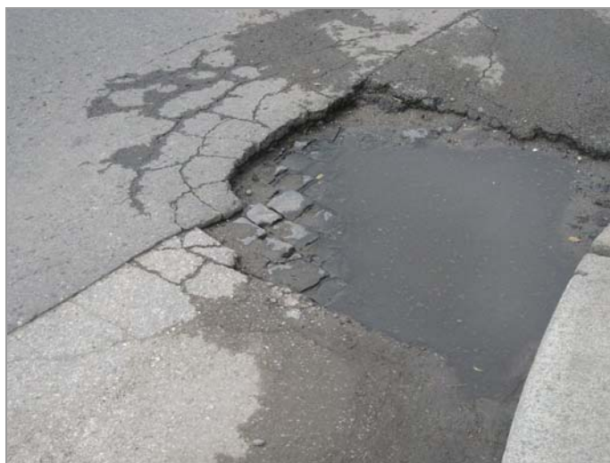
foto 34: Detail staré dlažby pod živičným povrchem v úseku č. 6
