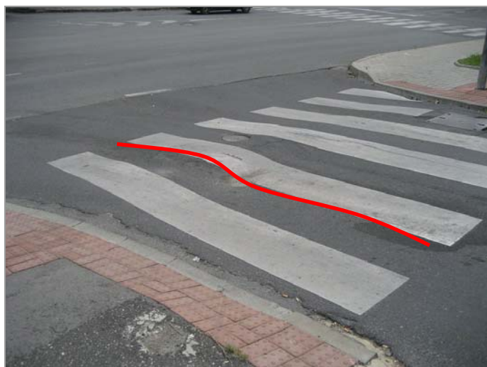
foto 45: Silně zvlněný povrch vozovky (ústí ul. Hajnova)
