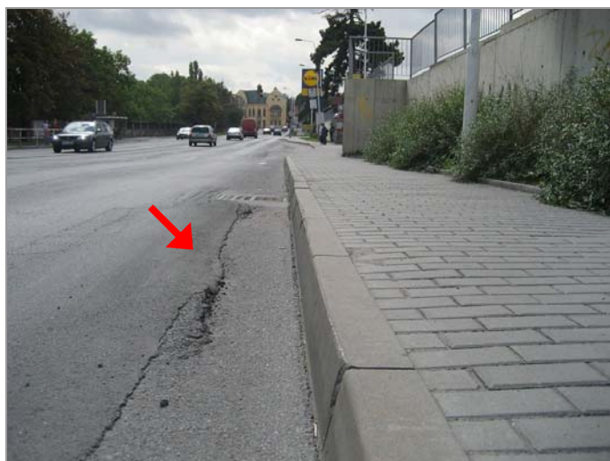
foto 44: Poruchy povrchu vozovky v úseku č. 7
