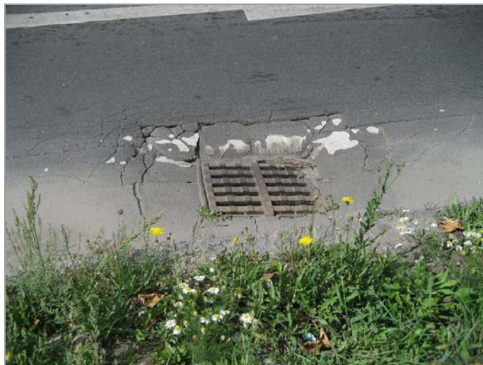
foto 38: Pokleslá kanalizačních vpust v úseku č. 7
