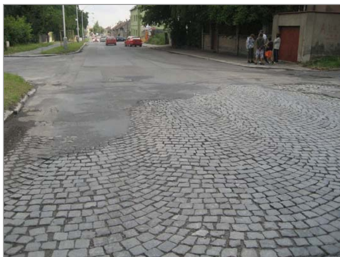
foto 30: Rozhraní úseků č. 4 (dlažba) a č. 5 (živičný povrch)
