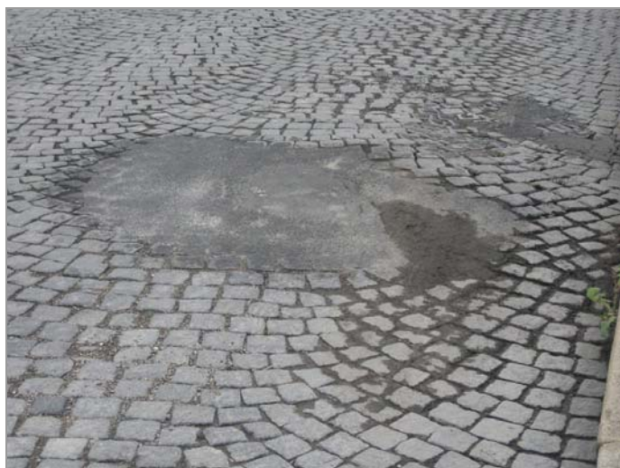
foto 28: Detail živičnou směsí opravené dlažby v úseku č. 4
