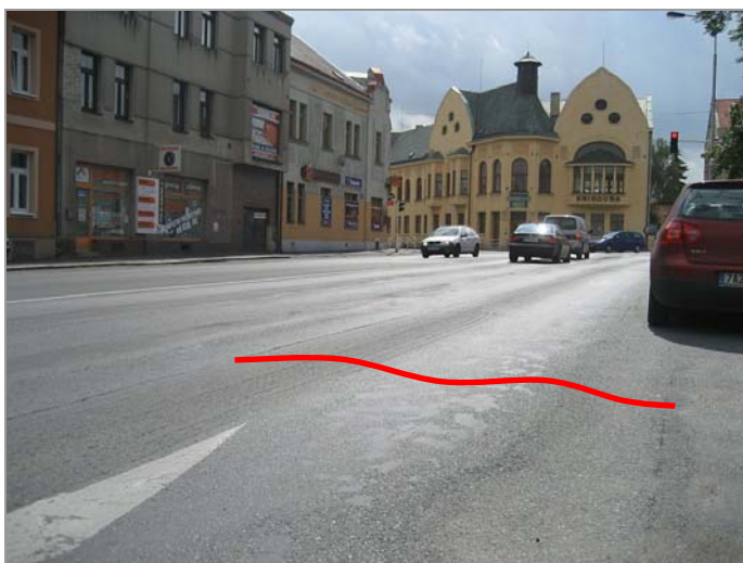
foto 35: Vlnovitě vytlačený povrch vozovky v úseku č. 7
