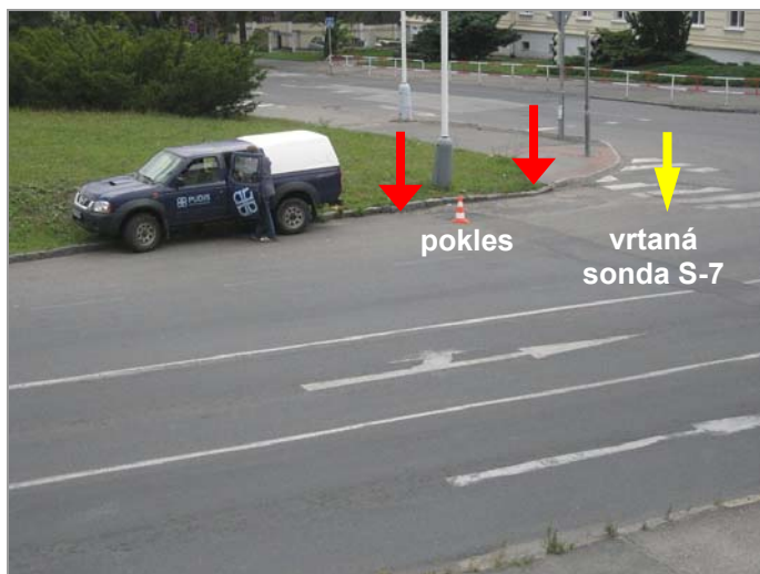
foto 46: Pokleslá vozovka v prostoru křižovatky Hajnova/Huťská
