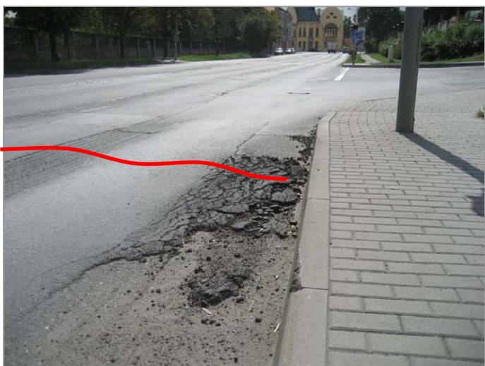
foto 41: Poruchy a vlnovitě vytlačený povrch vozovky v úseku č. 7
