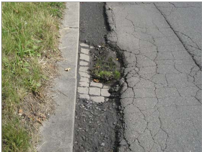
foto 25: Detail staré dlažby pod živičným povrchem v úseku č. 3
