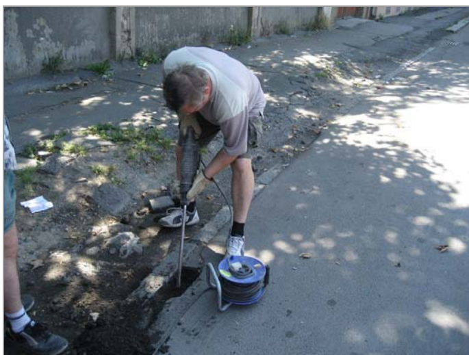
foto 11: Hloubení kopané průzkumné sondy S-1
