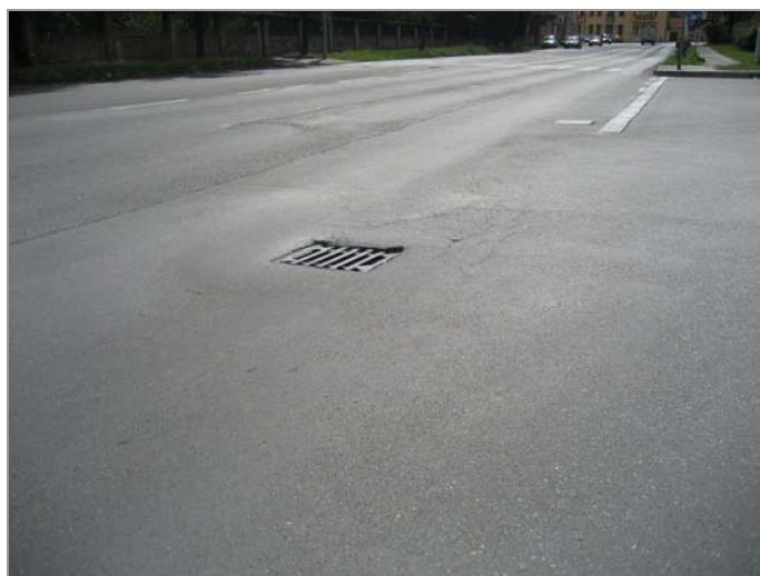
foto 40: Pokleslá kanalizačních vpust v úseku č. 7
