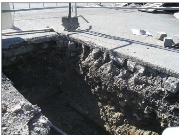
foto 17: Skladba konstrukce vozovky ve výkopu/sondě S-4
