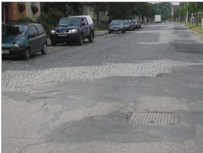
foto 31: Rozhraní úseků č. 4 (dlažba) a č. 5 (živičný povrch)
