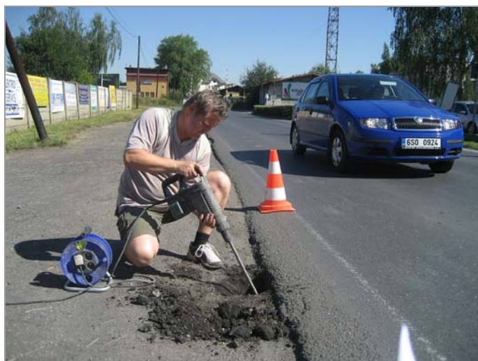
foto 20: Hloubení kopané průzkumné sondy S-6
