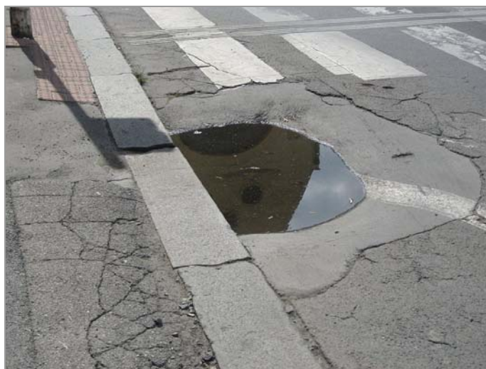
foto 36: Poruchy v místě kanalizačních vpustí v úseku č. 7
