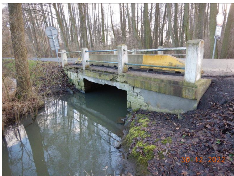
Podhled NK z levé strany.
