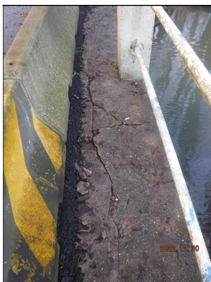
Detail sítě rozevřených trhlin mezi betonovým svodidlem a zábradlím na levé straně mostu.
