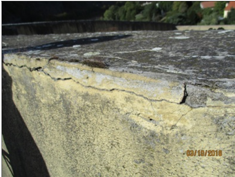
Příčné ztužidlo - horní povrch - typická porucha - odražená krycí vrstva
