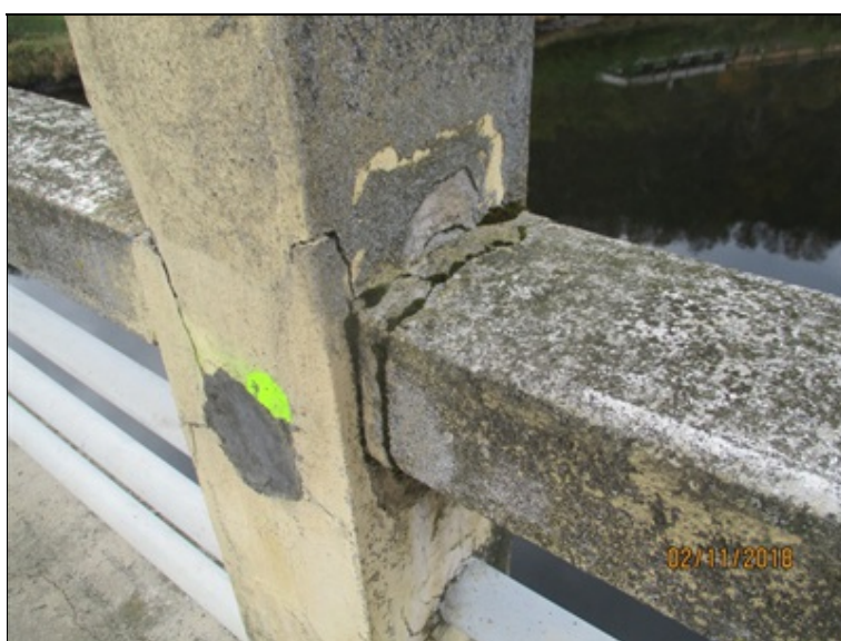
Závěs mostovky - detail napojení horního madla zábradlí - levá strana
