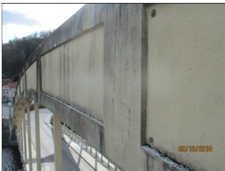
Pravý oblouk - vnější boční plocha v místě zakotvení závěsu, odvětrávací otvory dutiny oblouku
