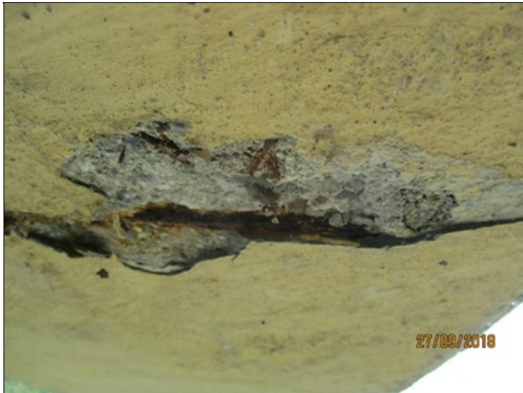
Mostovka - deska - příčná trhлина přes celý průřez - pravděpodobná pracovní spára
