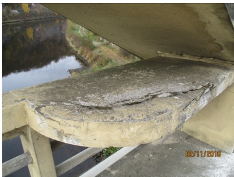
Detail ukončení zábradlí u prvního závěsu mostovky - nad opěrou O2 vlevo
