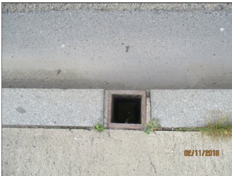
Odvodňovač na pravé straně - chybějící víko poklopu
