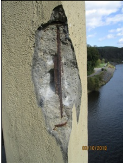
Závěs mostovky (táhlo) - typická porucha - odražená krycí vrstva v rozích, obnažená výztuž závěsu
