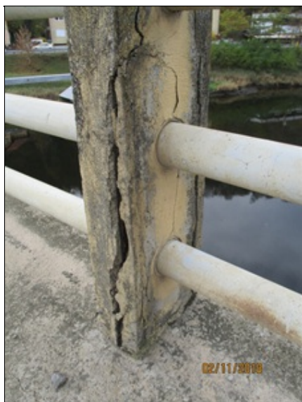
Sloupek zábradlí - typická porucha - levá vnitřní strana
