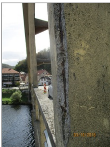
Závěs mostovky (táhlo) - typická porucha - odražená krycí vrstva v rozích
