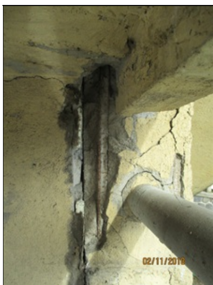
První závěs mostovky - nad opěrou O2 vpravo - obnažená výztuž závěsu
