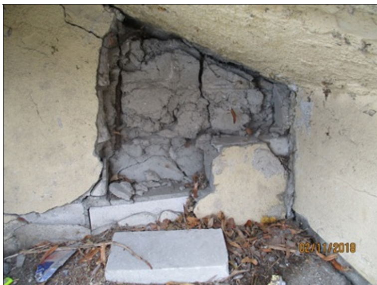
Přizdívka u prvního závěsu mostovky - nad opěrou O2 vlevo
