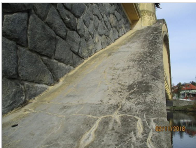
Pravý oblouk - horní povrch nad opěrou O1 - povrchové trhliny v sanační vrstvě, mech a lišejníky
