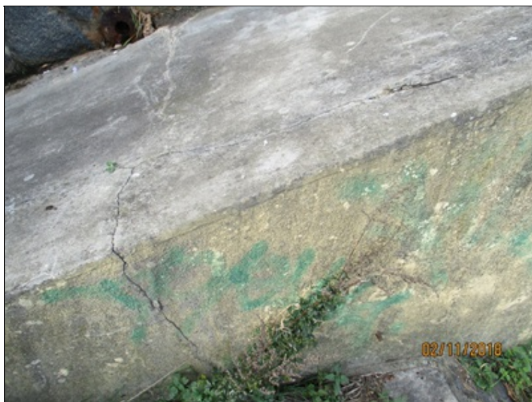
Pravý oblouk - trhlina v uložení nad opěrou O1
