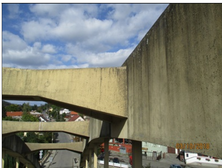
Oblouk nosné konstrukce - vetknutí ztužidla
