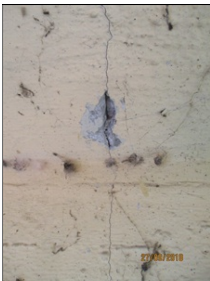
Mostovka - deska - příčná trhлина přes celý průřez - pravděpodobná pracovní spára
