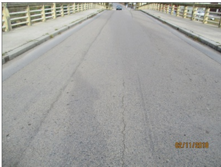
Vozovka ve střední části mostu - podélná trhlina - pohled po směru staničení
