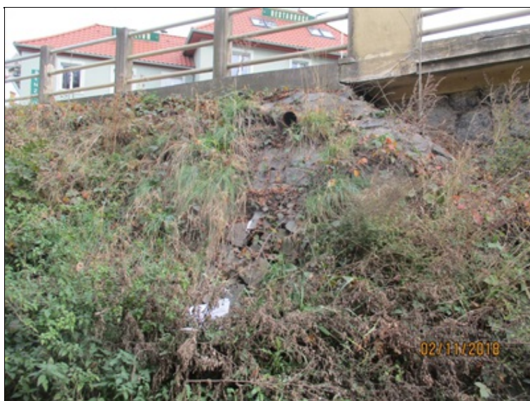
Opevnění kužele a svahu u levého křídla za opěrou O2 - dlažba prorostlá vegetací
