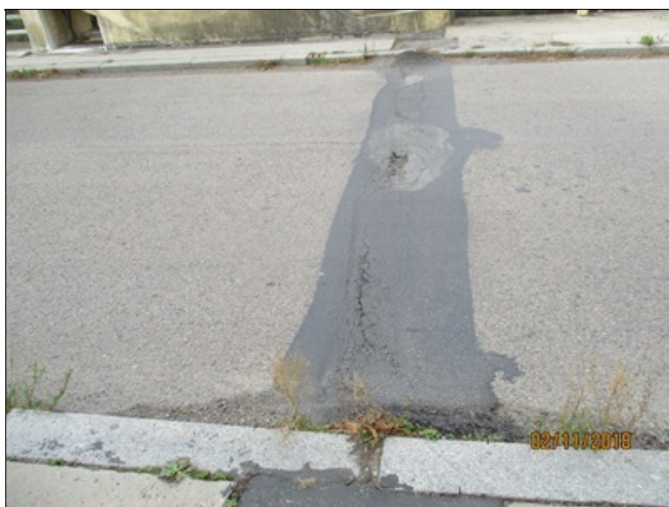
Mostní závěr nad opěrou O2 - pohled z pravé strany
