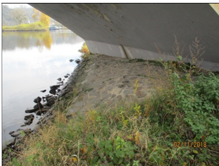
Opevnění břehu před O1 - pohled z levé strany
