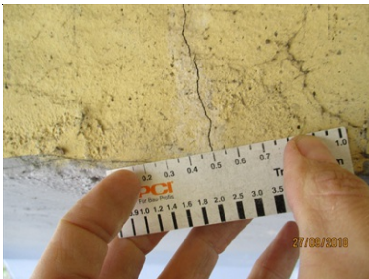
Čelná plocha opěry O1 - svislá trhlina pod uložením mostovky
