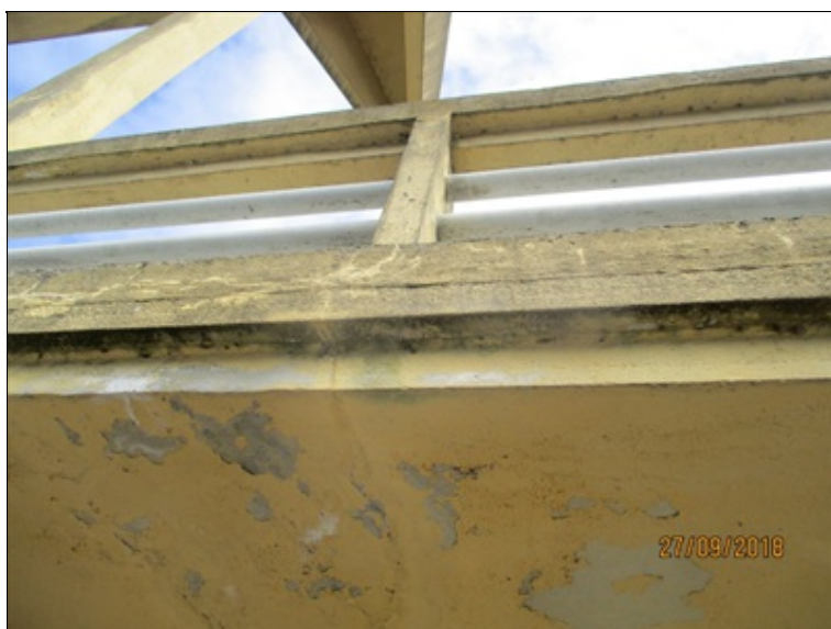
Závěs mostovky (táhlo) - typická porucha - odražená krycí vrstva v rozích
