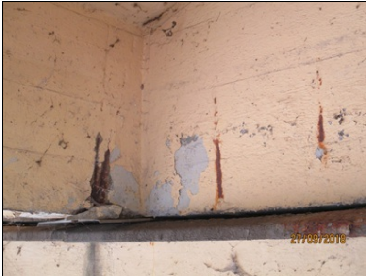
Mostovka - uložení nad opěrou O1 - obnažená výztuž v podélníku
