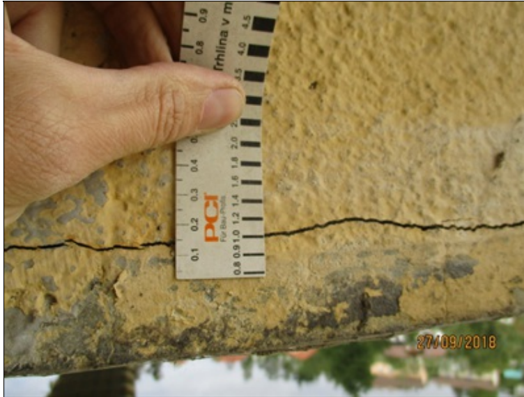
Mostovka - příčník - detail typické poruchy - odražení betonu v krycí vrstvě
