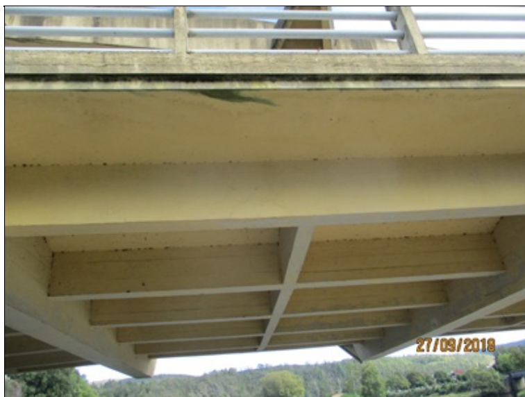
Podhled mostovky - detaily prvků - příčnky, podélníky, deska, konzola
