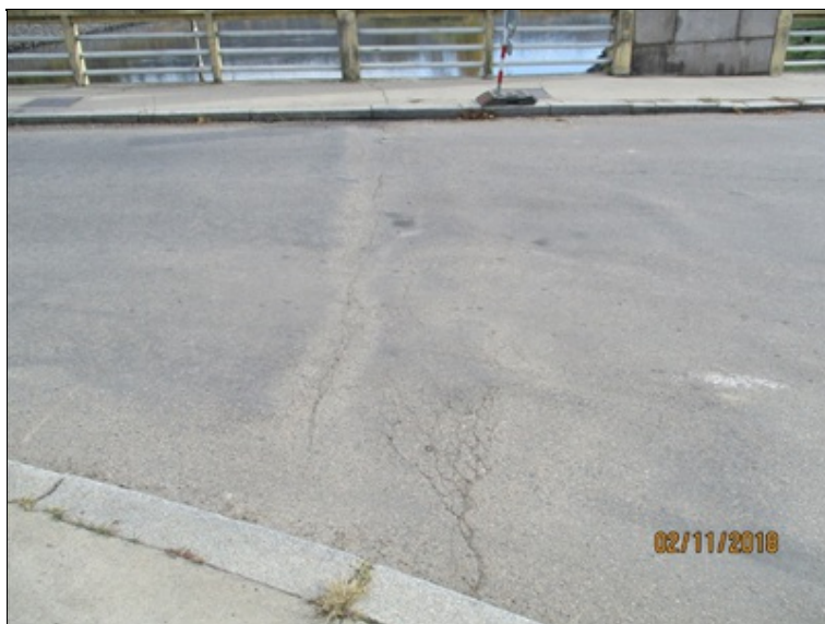
Vozovka na předmostí nad opěrou O1 z levé strany - výrazná příčná trhlina
