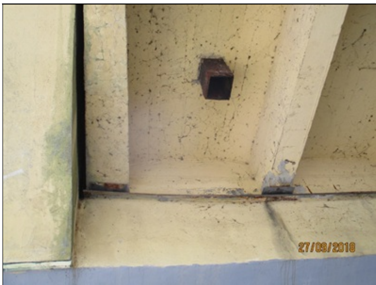
Mostovka - uložení nad opěrou O1 - odtok odvodňovače - koroze
