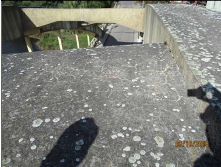
Příčné ztužidlo - horní povrch - povrchové trhliny v sanační vrstvě, mech a lišejníky
