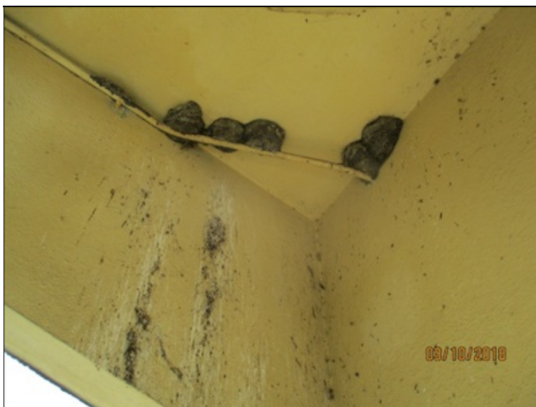
Příčné ztužidlo - podhled - typický jev - ptačí hnízda
