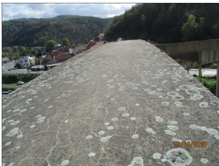
Pravý oblouk - horní povrch - povrchové trhliny v sanační vrstvě, mech a lišejníky
