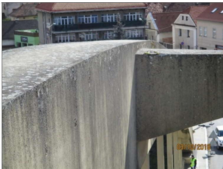
Oblouk nosné konstrukce - vetknutí ztužidla
