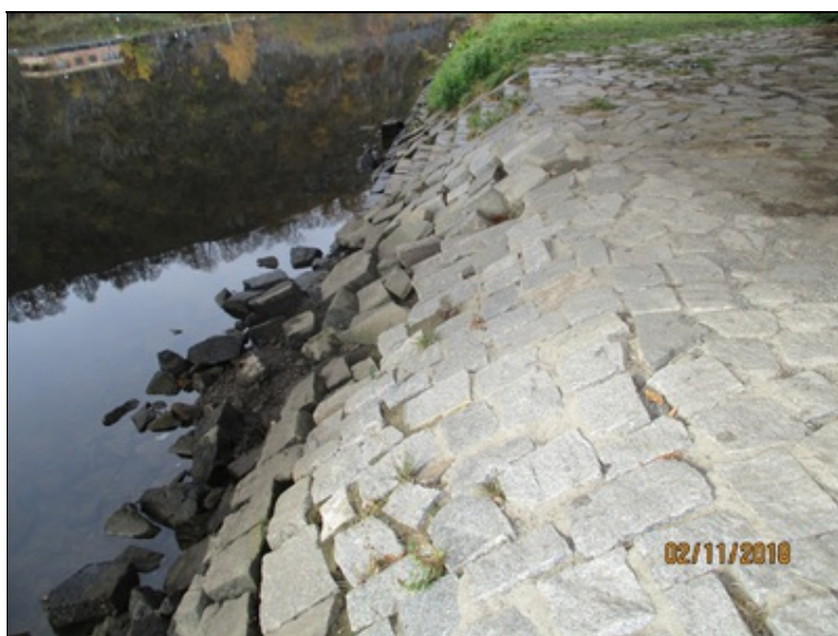
Opevnění pravého břehu řeky před opěrou O2 - rozpadlá dlažba, uvolněné kameny
