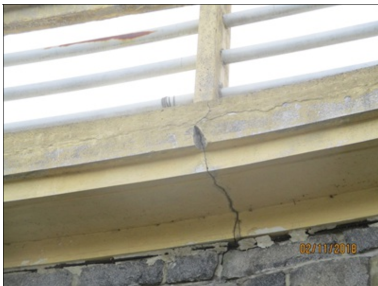
Konzola chodníku nad pravým křídlem opěry O1 - příčné a podélné trhliny
