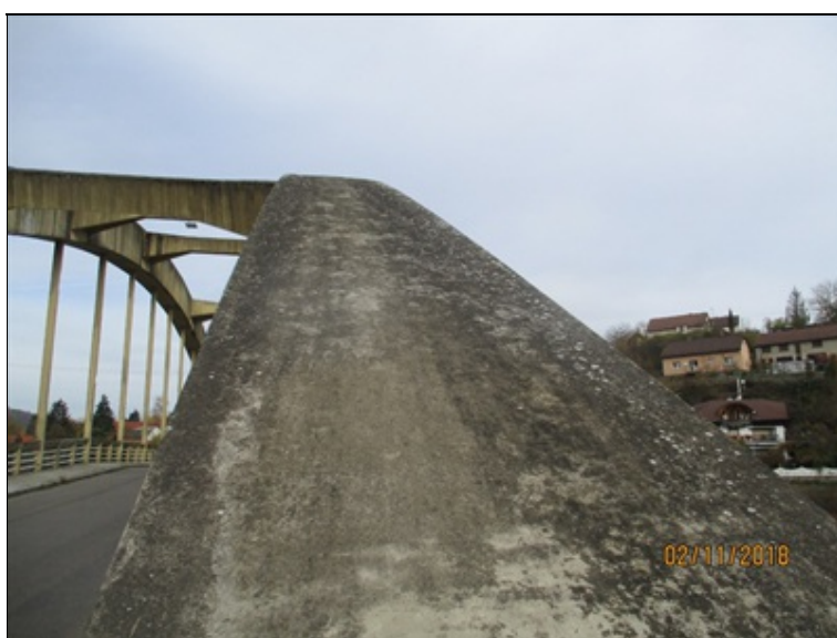
Pravý oblouk - horní povrch u opěry O1 - mech a lišejníky
