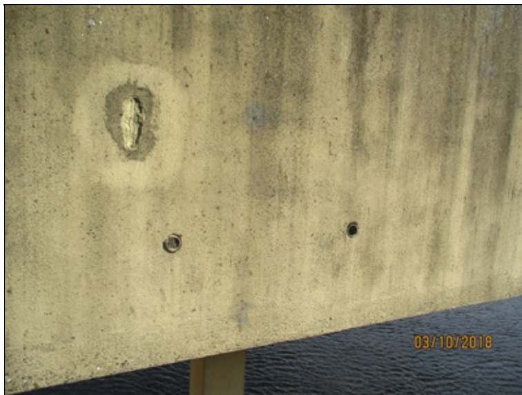
Pravý oblouk - vnitřní boční plocha v místě zakotvení závěsu, odvětrávací otvory dutiny oblouku
