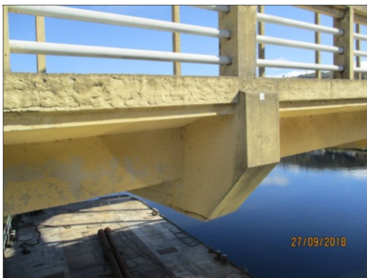
Nosná konstrukce - detaily napojení táhla na příčník - pravá strana
