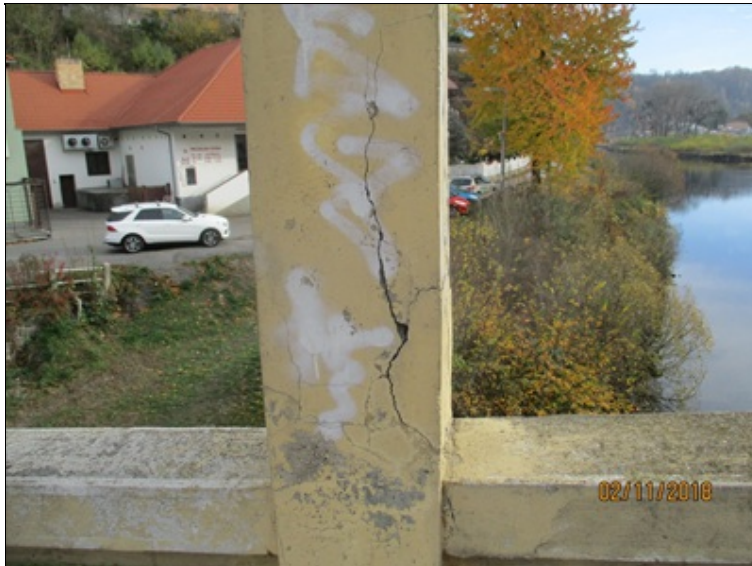
Závěs mostovky (táhlo) - typická porucha - odražená krycí vrstva v rozích i ploše
