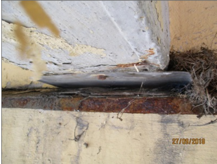
Mostovka - detail uložení nad opěrou O1 - koroze plechů, ptačí hnízdo vpravo
