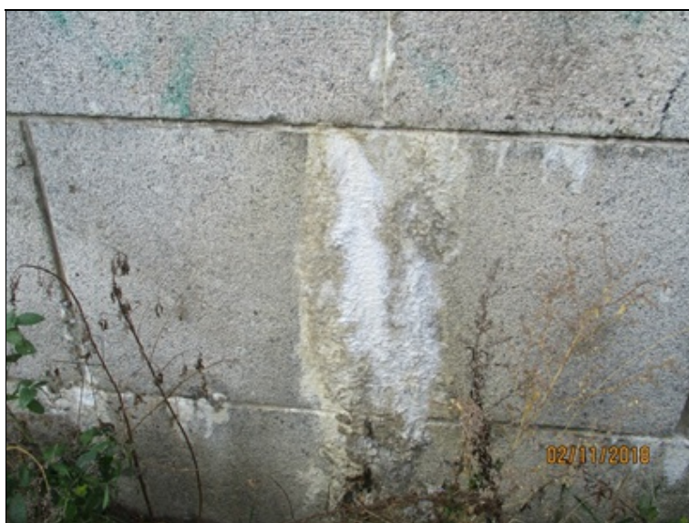
Zdivo sloupu s hodinami u pravého křídla opěry O1 - vápenné výluhy ze spáry zdiva
