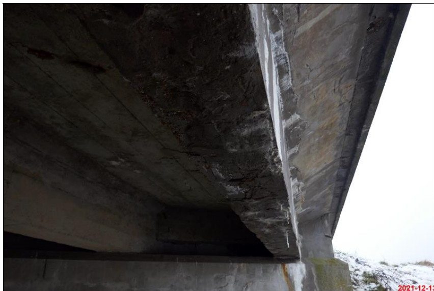
25_degradace vnejsiho tramu.JPG
