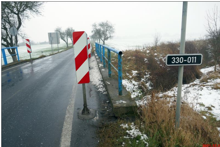
02_pohled na pravou rimsu.JPG
