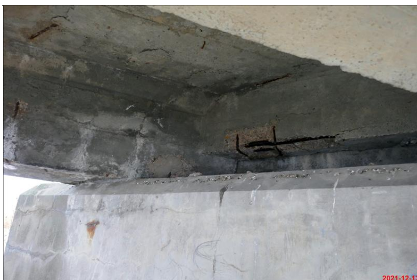
26_odstrelujici kryci vrstva.JPG
