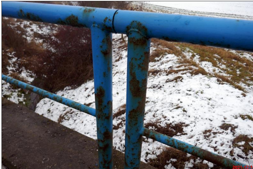
05_koroze svodidla.JPG
