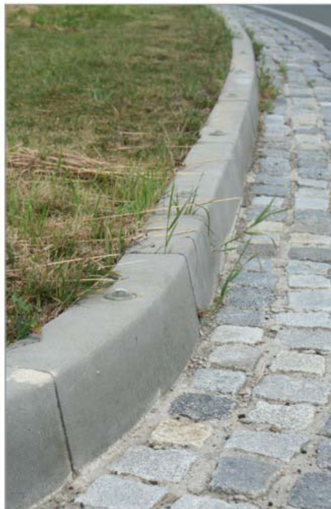
Obrázek 5: Detail obrubníku s tzv. "rybím okem" a šířkového uspořádání dlážděného okraje ostrůvku
