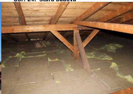
Obr. 26: Zateplení podlahy půdy internátu
