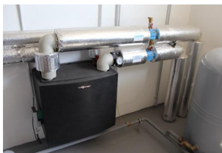
Obr. 29: Deskový výměník pro nabíjecí zásob. systém se směš. armaturou
