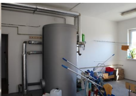
Obr. 30: Nepřímoohřívavý zásobník TV
