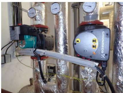
Obr. 40: Oběhová čerpadla
