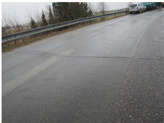
Obr. 2 Pokles vozovky, popraskání živičného krytu
