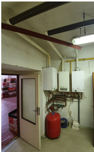
Obrázek 4 – Trojice kotlů pro vytápění
