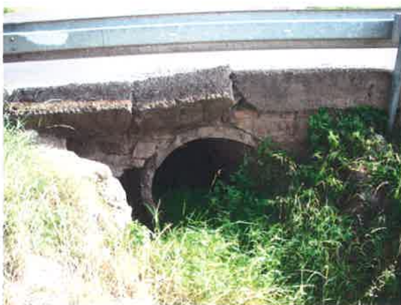
propustek na křiž. se sil. III/511
