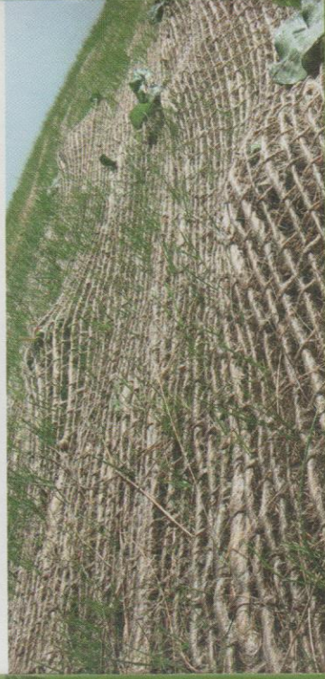
Na místech náchylnějších k erozi lze zelené seno zajistit geotextilními rohožemi.
