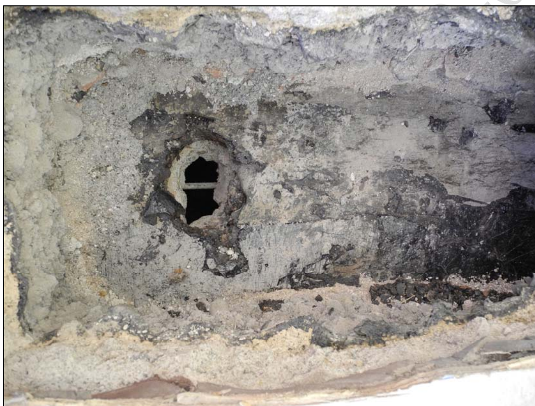
Obr. 3.2/ 1 Detail výztuže v místě sondy S6 do stropní konstrukce nad místností 1.13
