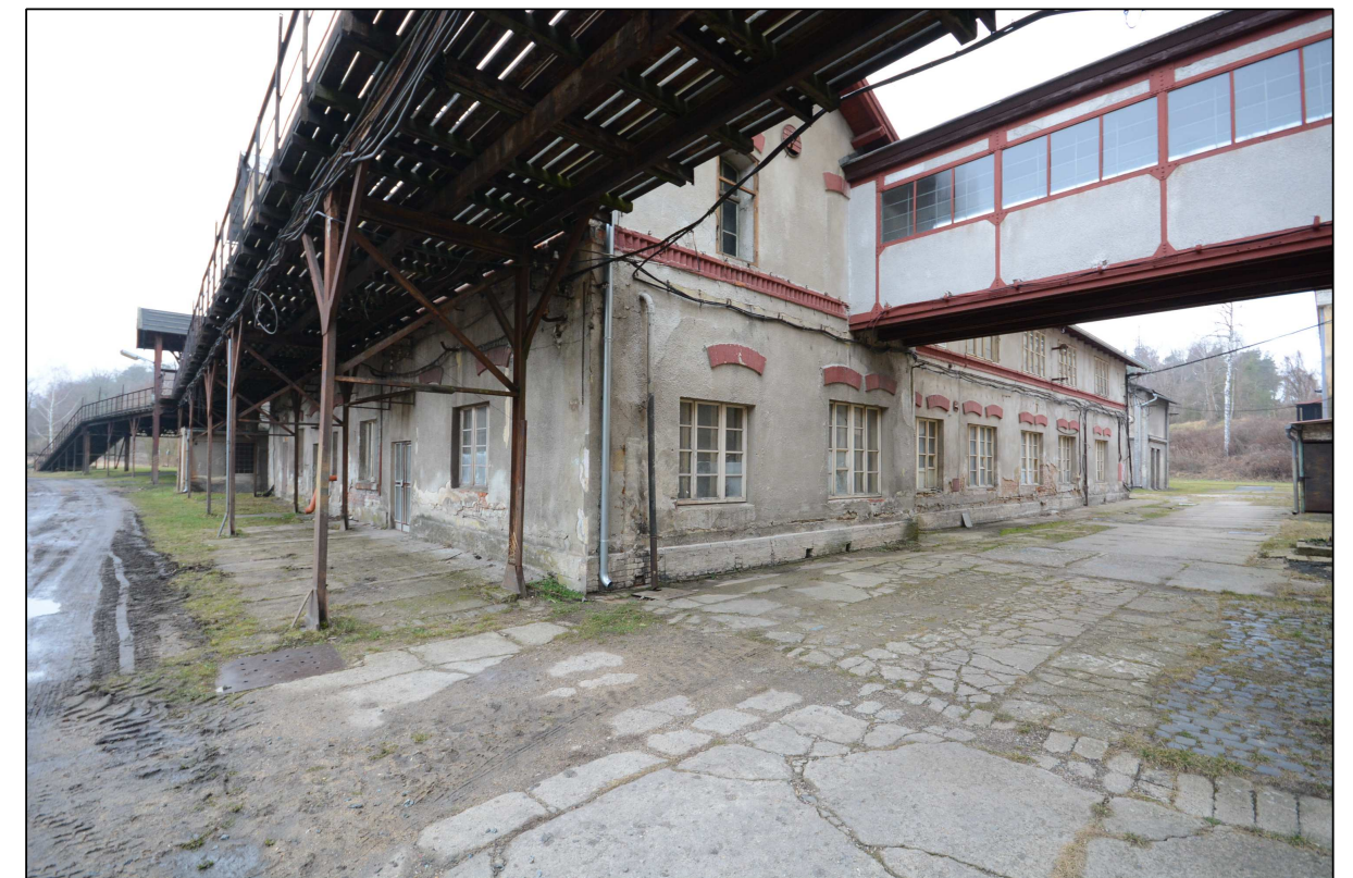
jihovýchodní (východní) průčelí
