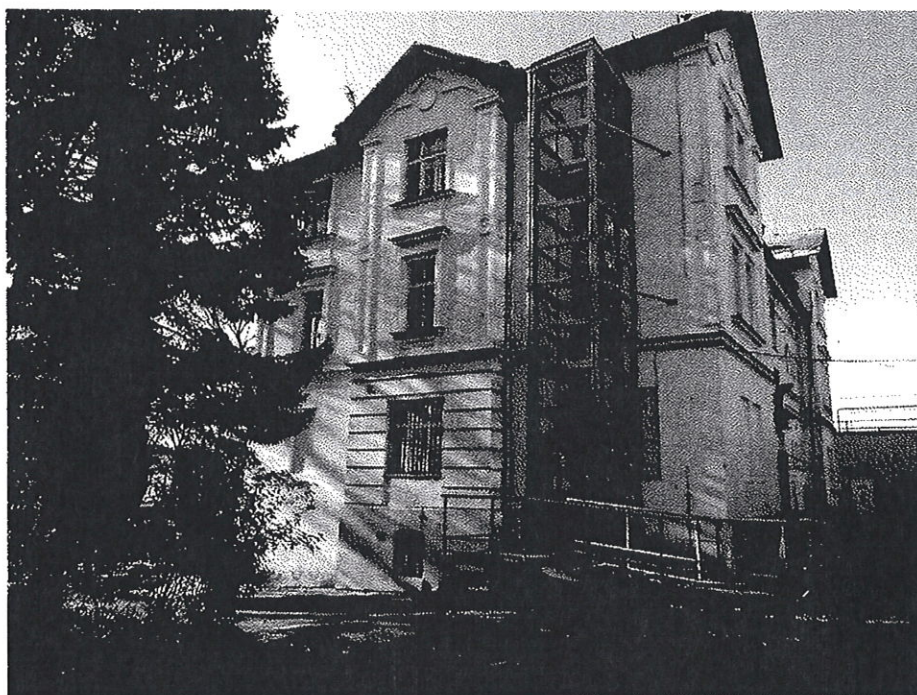
obrázek č.4 Východní pohled na budovu
