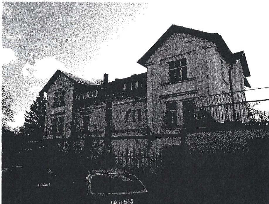
obrázek č.3 Severní pohled na budovu
