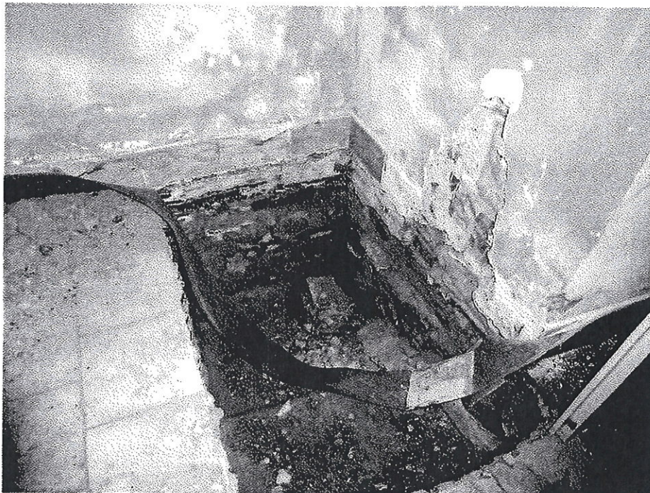
obrázek č.5 Sonda základu
