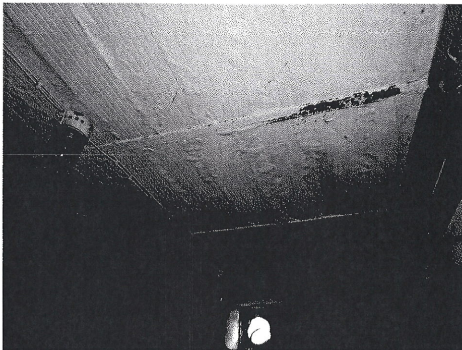
obrázek č.9 Dodatečně provedený strop z ocelových nosníků a výplní
