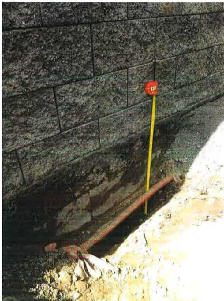
Obr.č.3 – sonda sonda u paty přilehlé zdi
