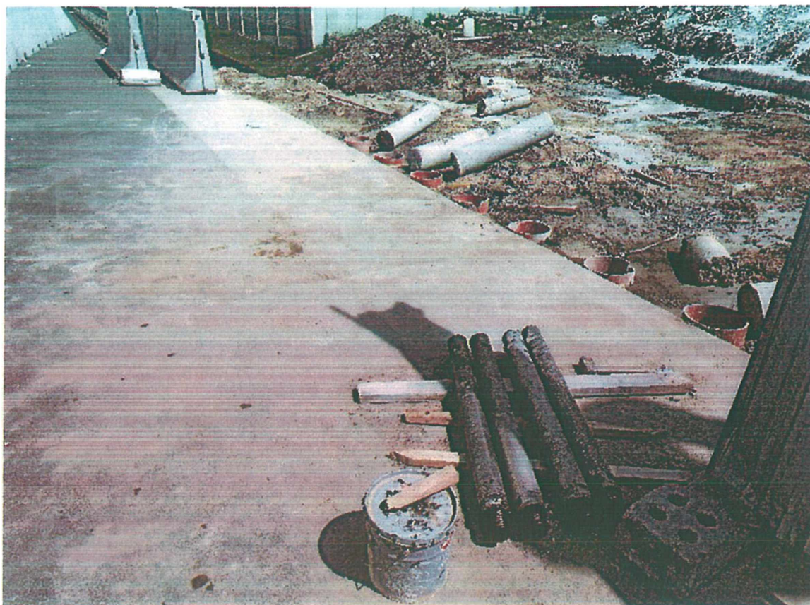
Pohled na vrty včetně jádra
