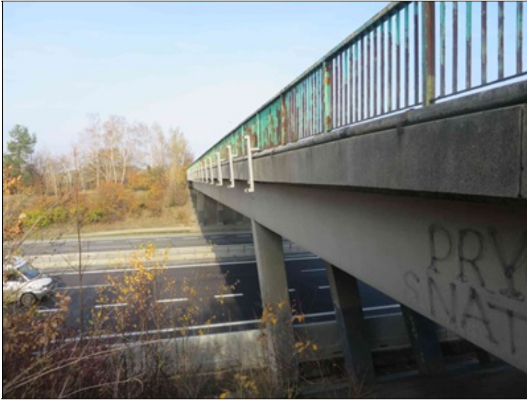
pravý bok mostu
