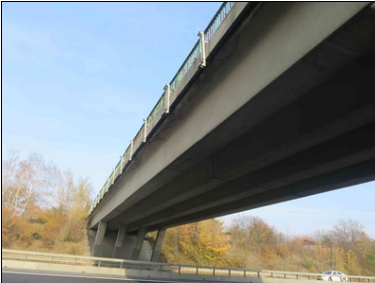
podhled 2. pole od P3
