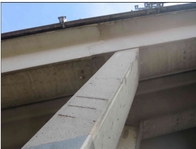
podhled 4. nosníku u P2
