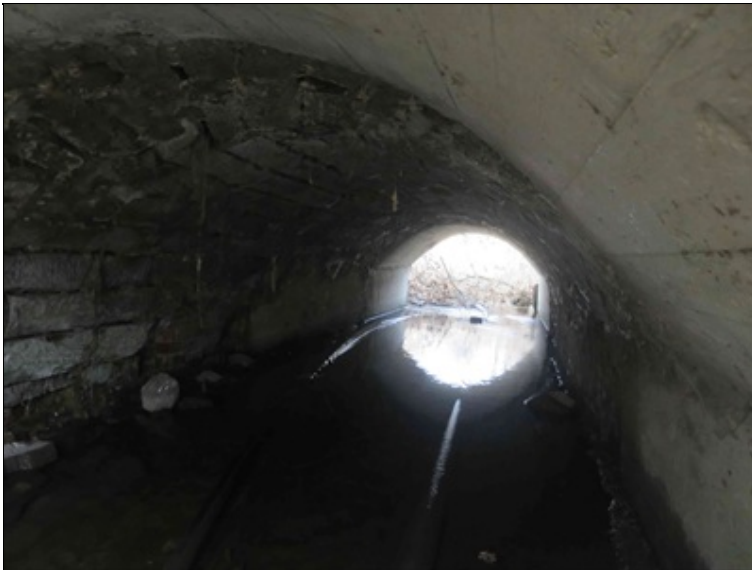
průhled mostním otvorem zprava
