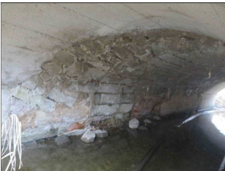
původní část opěry 1
