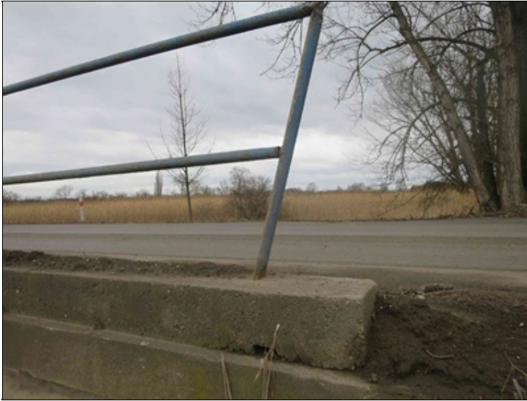
stávající stav pravého zábradlí
