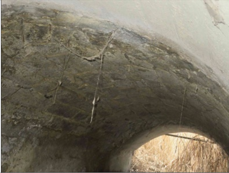
podhled klenbového pasu
