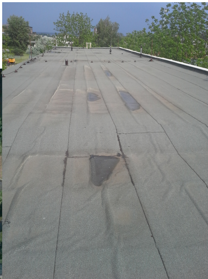
foto /2/ pohled na jednu z předmětných střech
